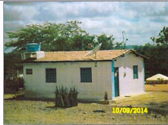
Casa concluída, comunidade Cruz dos Riachos, Cabrobó/PE
