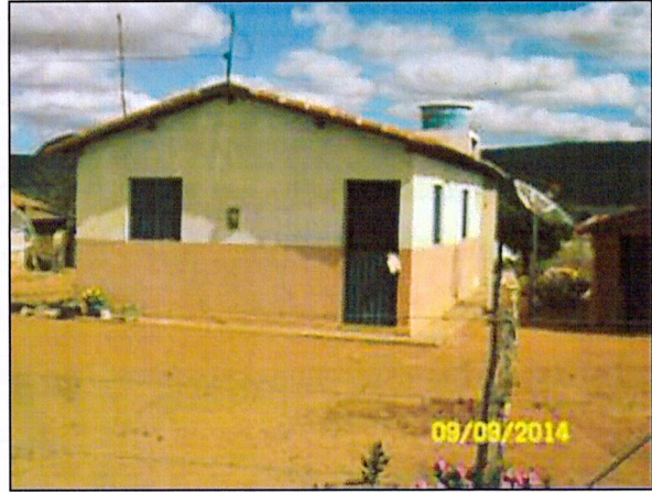
Casa concluída, comunidade Jatobá II, Cabrobó/PE
