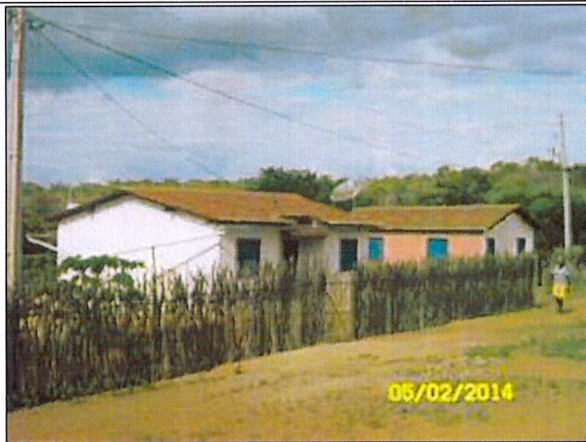
Casa concluída, comunidade Feijão/Posse, Cabrobó/PE
