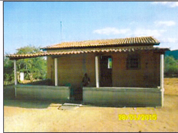
Casa concluída, comunidade Jatobá II, Cabrobó/PE
