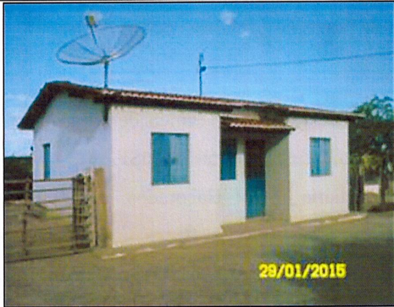
Casa concluída, comunidade Cruz dos Riachos, Cabrobó/PE
