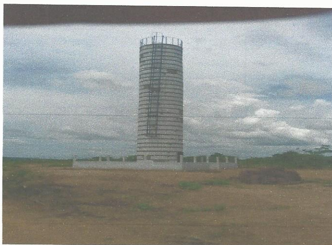
Reservatório Elevado (30 m 3 )
