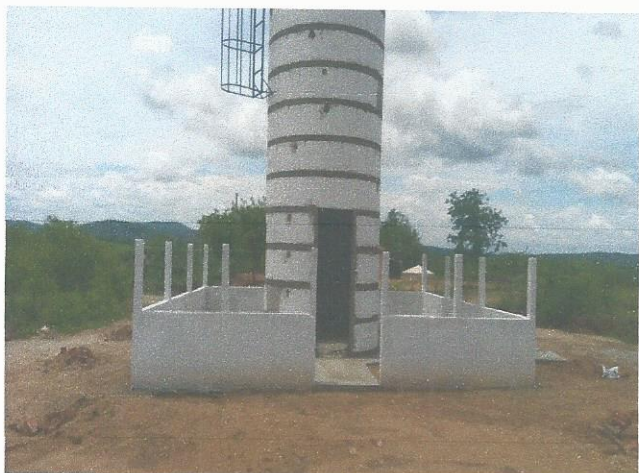
Reservatório Elevado (10 m 3 )
