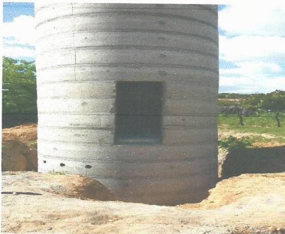
Reservatório Elevado (30 m 3 )
