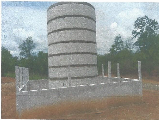
Reservatório Apoiado (25 m 3 )
