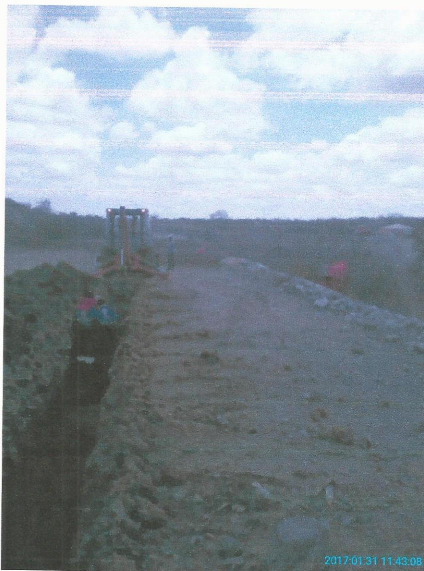
Figura 01–Escavação das valas.
