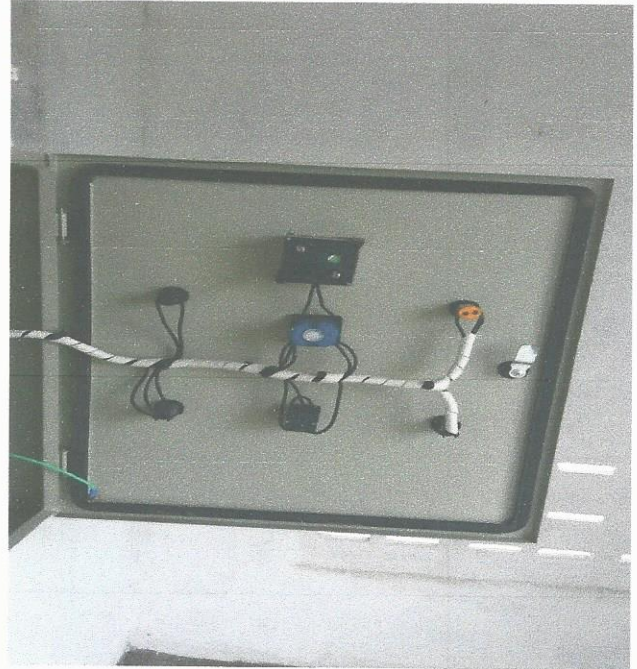
Quadro de Comando para acionamento da eletrobomba submersa
