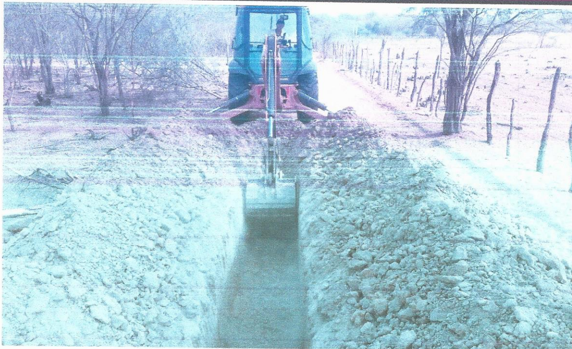
Figura 02–Escavação das valas.
