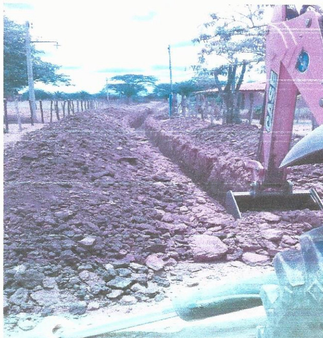
Figura 01 –Escavação das valas.
