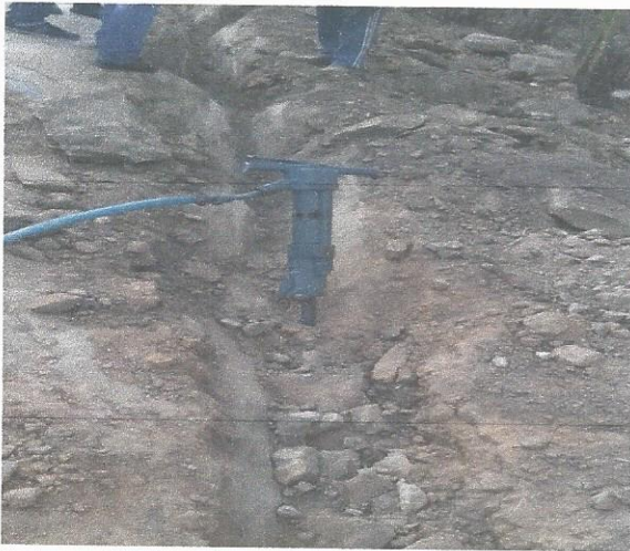
Escavação de vala em rocha (mat. 3ª categoria)
