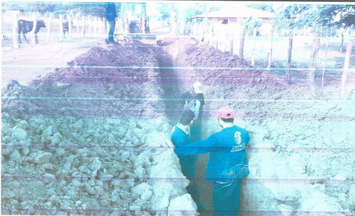
Figura 01 –Escavação das valas e início do assentamento.
