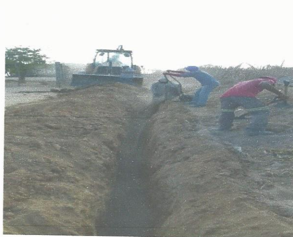
Assentamento da tubulação e Reaterro de valas da tubulação das Redes Adutora e de Distribuição
