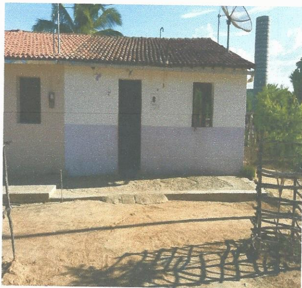
Ligação Domiciliar – Torneira (ponto de chegada)
