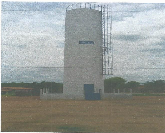
Reservatório Elevado (40 m 3 ) – Cerca com mureta; Escada com Guarda Corpo; Portão e Porta de Entrada
