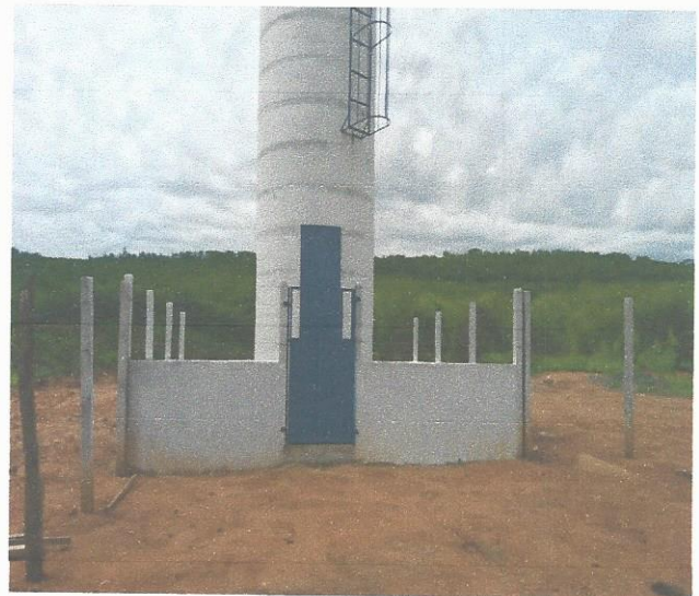
Reservatório Elevado (15 m 3 ) – Porta de entrada (foto à esquerda); Cerca com mureta; Portão e Escada com Guarda-Corpo (foto à direita)
