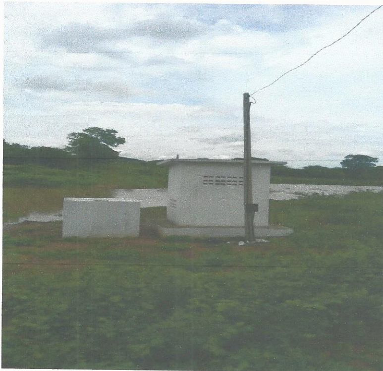
Casa de Comando; Proteção do Poço Tubular Profundo e Poste Padrão de entrada da Rede de Distribuição de energia elétrica.
