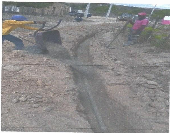
Assentamento da tubulação e Reaterro de valas da tubulação das Redes Adutora e de Distribuição
