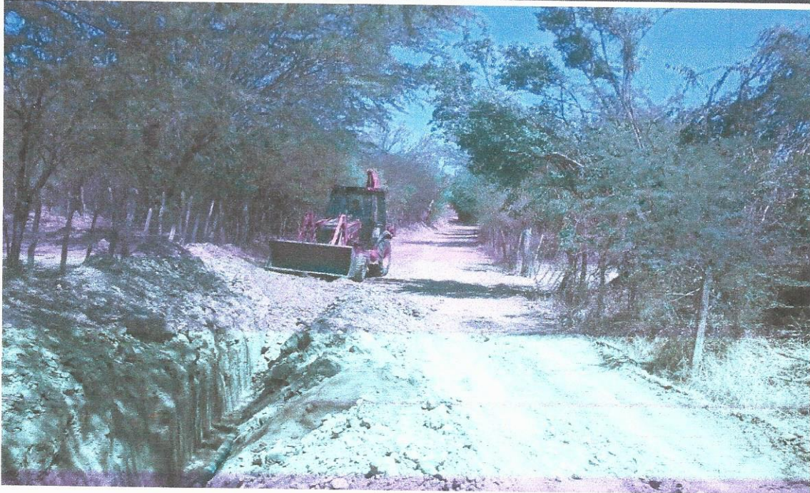
Figura 02 –Tubos assentados e execução do reaterro.
