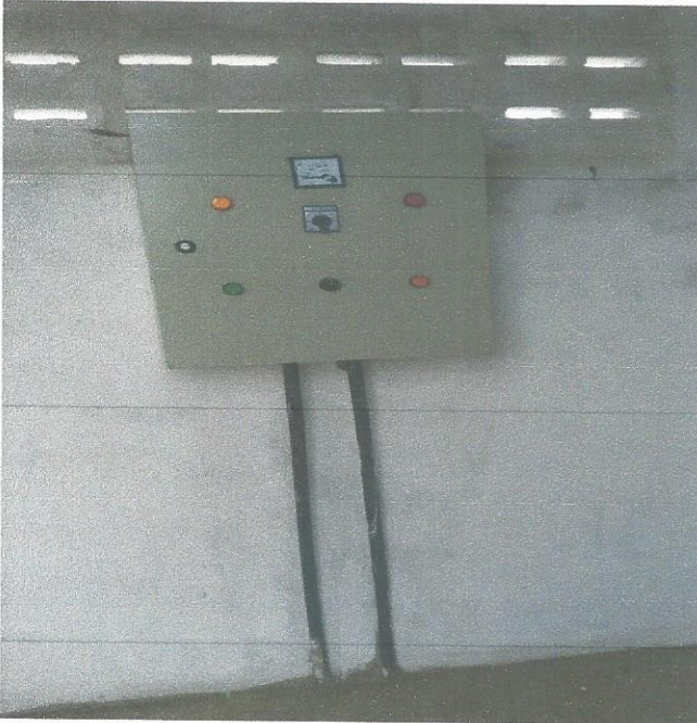
Quadro de Comando para acionamento da eletrobomba submersa
