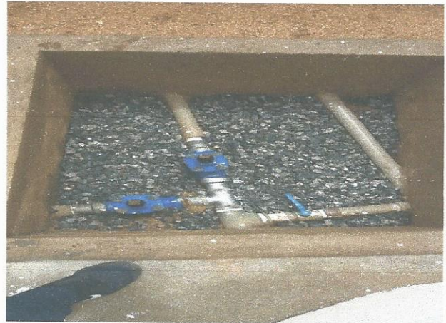
Registros de manobras das Redes de Distribuição e Tubulação para limpeza/extravasamento do R.Elev.
