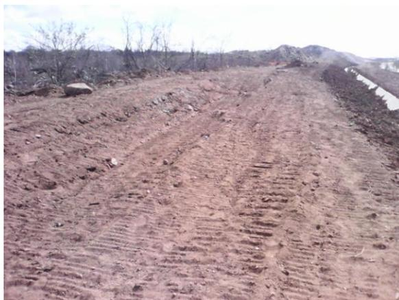
**Figura 326:** Detalhe da área com presença de top-soil sobre a superfície e área em regeneração.
