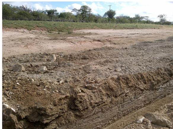
**Figura 81:** Detalhe mostrando intervenções da obra como, por exemplo, construção de canais de drenagem lateral.
