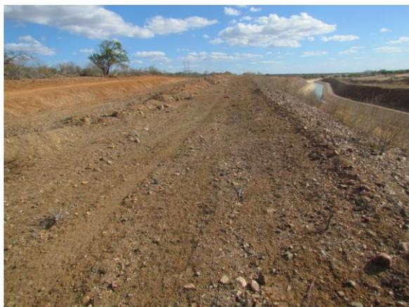
**Figura 260:** Aspecto geral da área a ser recuperada, destacando presença de material de 2ª categoria acumulado.
