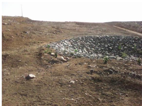
**Figura 196:** Destaque para solo exposto com material de bota fora amontoado.
