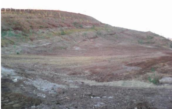
**Figura 328:** Aspecto geral da área que receberá intervenção, com destaque para o solo exposto e declividade do terreno.
