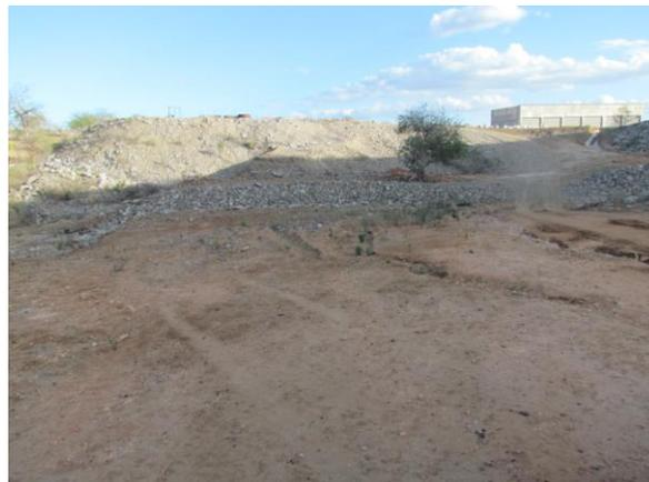
**Figura 287:** Aspecto geral da área a ser recuperada, destacando solo exposto com material de 2ª categoria espalhado.
