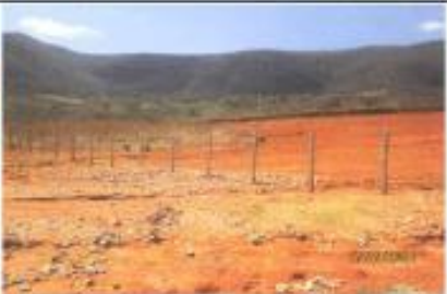
Construção das cercas;
