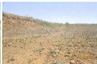
Área explorada sem erosões com taludes em cortes conformizados.
