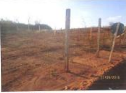
Construção das cercas;
