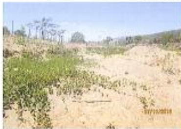
Área explorada sem erosões com taludes em cortes conformizados e presença de vegetação nativa.
