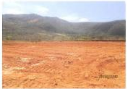
Recuperação e conformização dos talude após finalizar a extração da argila
