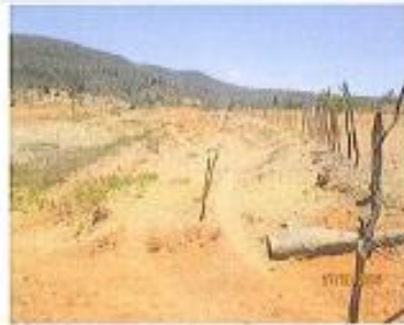
Área explorada sem erosões com taludes em cortes conformizados e com presença de vegetação.
