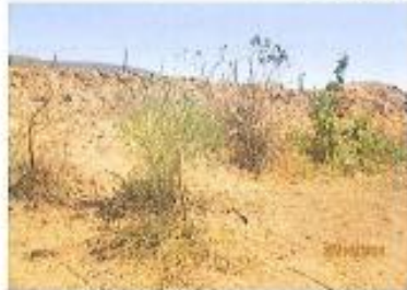
Taludes estabilizados sem erosões e com indício de vegetação nativa.
