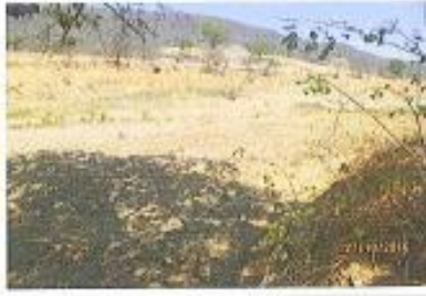
Área explorada sem erosões com taludes em cortes conformizados e com presença de vegetação nativa.
