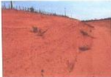
Área explorada com talude recuperado sem presença de erosões.
