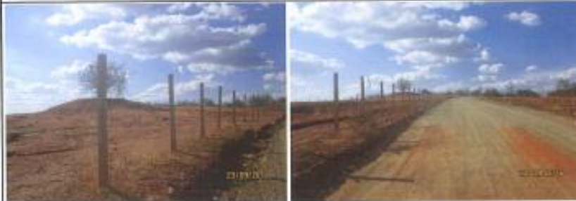
Construção das cercas e valetas para melhor escoamento das águas;
