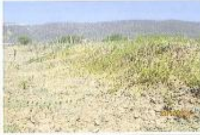
Área explorada sem erosões com taludes em cortes conformizados e com presença de vegetação.
