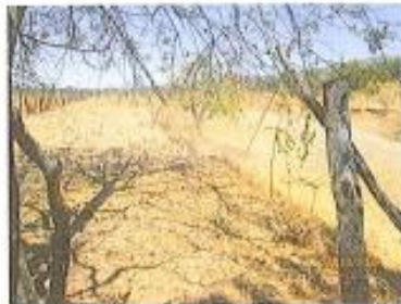
Área explorada sem erosões com taludes em cortes conformizados e com presença de vegetação.
