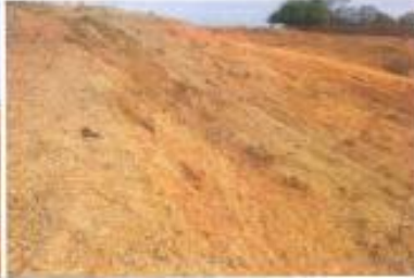
Área explorada sem erosões com taludes em cortes conformizados e presença de vegetação nativa.
