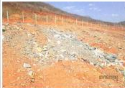
Recuperação e conformização dos talude após finalizar a extração de argila e correção de erro profundo com uso de rochas;
