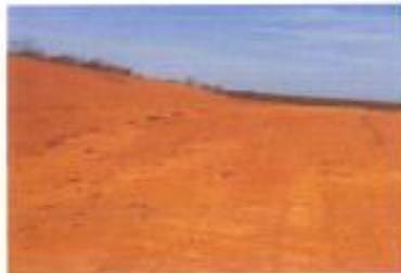
Área explorada com talude recuperado sem presença de erosões.
