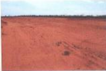
Área explorada conformizada sem presença de erosões.
