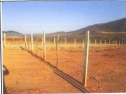
Construção das cercas;
