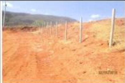
Construção das cercas;
