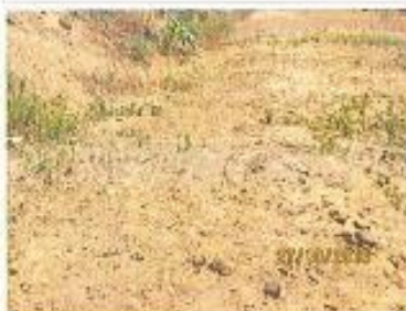
Área explorada sem erosões com taludes em cortes conformizados e com presença de vegetação.
