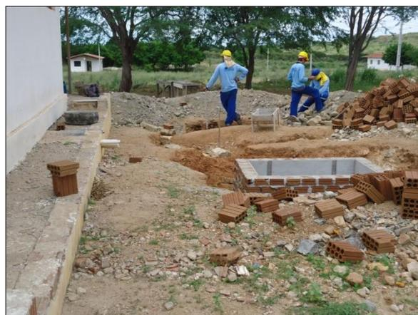
Foto 4.8.10. Detalhe de construção das instalações hidrossanitárias, fossa e sumidouro da casa nº 25, VPR Salão (mar/2014).
