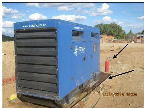
Foto 4.2.56. Gerador instalado sobre bandeja de contenção e extintor contra incêndio na frente de serviço do aqueduto Mari (fev/2014).
