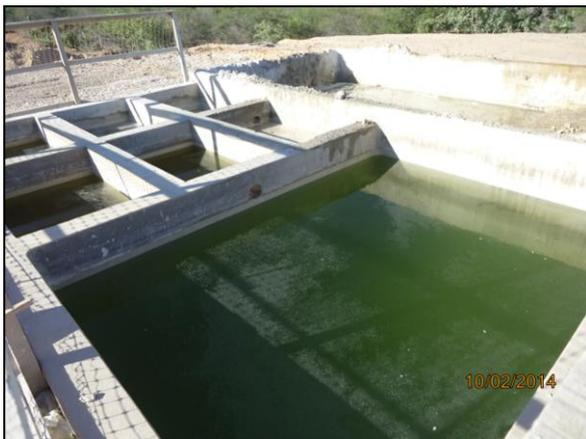
Foto 4.2.295. Tanque de decantação dos efluentes provenientes dos caminhões-betoneira da frente de serviço da EBI-1 (fev/2014).
