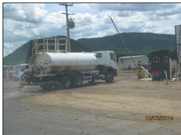
Foto 4.2.248. Caminhão-pipa em atividade de umectação da via de acesso do canteiro de apoio da EBI-02 (mar/2014).
