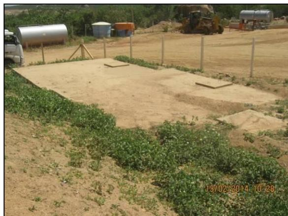
Foto 4.2.154. Sistema de tratamento de efluentes provenientes do refeitório e alojamento do canteiro de Salgueiro – PE, composto por tanque séptico seguido de filtro anaeróbico (fev/2014).
