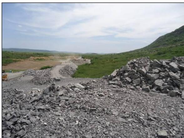
Foto 4.2.490. Bota-fora com material de 3ª categoria na frente de serviço do desemoque do túnel Cuncas I - WBS 1410 (jan/2014).
