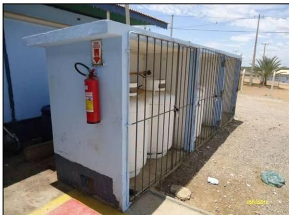
Foto 4.2.33. Equipamento contra incêndio disponibilizado na baia de armazenamento dos botijões de gás do canteiro de obras em Cabrobó - PE (nov/2013).
