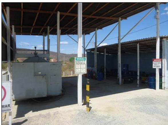
Foto 4.2.469. Posto de combustível coberto, sinalizado e sistema de tratamento de efluentes, no canteiro central (dez/2013).
