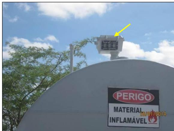
Foto 4.2.325. Indicador de nível em tanque aéreo do posto de abastecimento (jan/2014).
