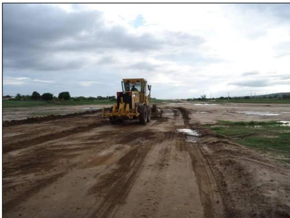
Foto 4.2.212. Aplainamento da via de acesso do segmento de canal WBS 1233 (fev/2014).
