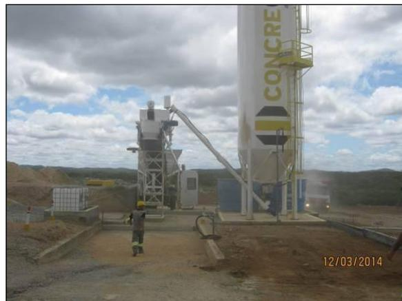
Foto 4.2.420. Central de concreto sendo instalada no WBS 2225 (mar/2014).
