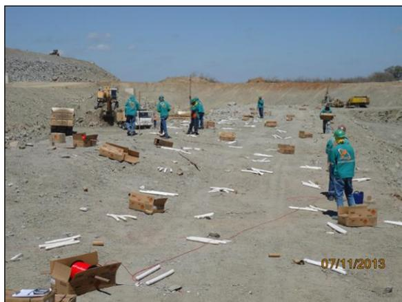
Foto 4.2.109. Colaboradores em atividade de instalação dos explosivos para desmonte de rocha na área do reservatório Serra do Livramento - WBS 1107 (nov/2013).
