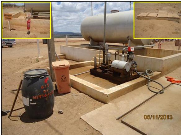
Foto 4.2.281. Posto de combustível do canteiro de apoio da EBI-2 com bacia de contenção, pista impermeabilizada, canaletas de drenagem ligadas ao SAO, extintor de incêndio e kit mitigação (nov/2013).
