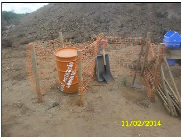
Foto 4.2.434. Kits mitigação disponibilizados nas frentes de serviços para contenção de vazamentos (fev/2014).
