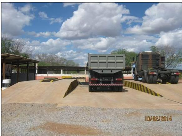
Foto 4.2.13. Lava-jato com pista impermeabilizada e canaleta ligada ao SAO (fev/2014).
