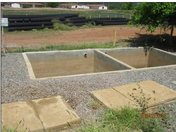
Foto 4.2.429. Estruturas do SAO do lava-jato e depósito de óleo com manutenção adequada (jan/2014).
