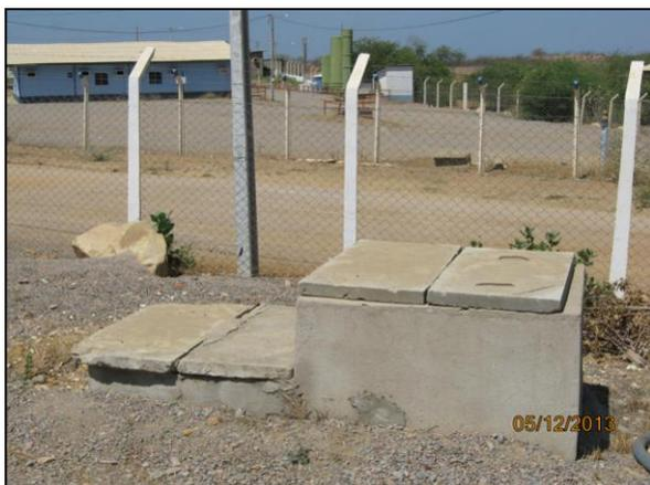
Foto 4.2.57. Caixa de passagem dos efluentes para fossa séptica no canteiro de obras de Cabrobó - PE (dez/2013).
