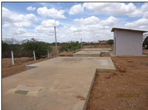
Foto 4.2.151. Sistema de tratamento de efluentes do canteiro de obras de Penaforte – CE composto por tanque séptico seguido de sumidouro (nov/2013).
