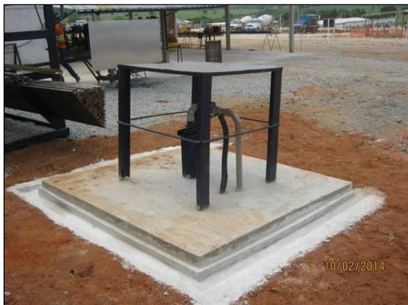
Foto 4.2.185. Poço tubular profundo implantado no canteiro central, com piso impermeável e cobertura (fev/2014).
