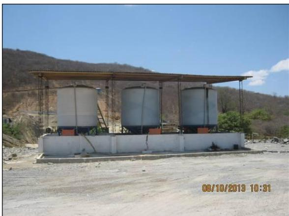
Foto 4.2.485. Bacia de contenção de aditivos implantada na frente de serviço do desemboque do túnel Cuncas I (out/2013).
