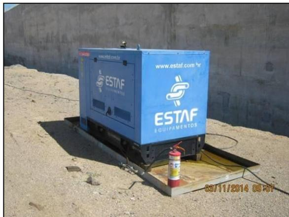
Foto 4.2.99. Gerador sobre bandeja de contenção e extintor contra incêndio na frente de serviço do vertedouro do reservatório Serra do Livramento - WBS 1107 (mar/2014).
