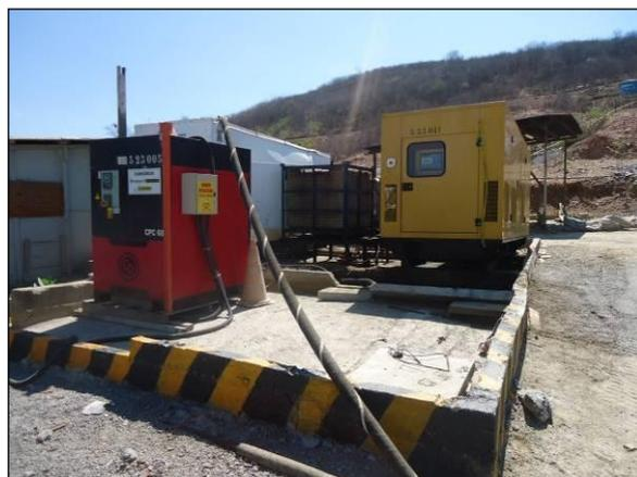
Foto 4.2.486. Bacia de contenção de grupo gerador disposto na frente de serviço da janela do túnel Cuncas I (dez/2013).
