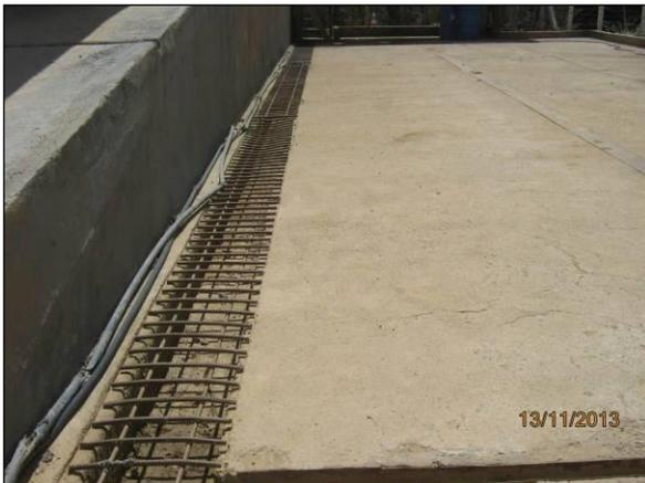
Foto 4.2.374. Lava jato com piso impermeabilizado, mureta para contenção dos efluentes e canaletas ligadas ao SAO (nov/2013).
