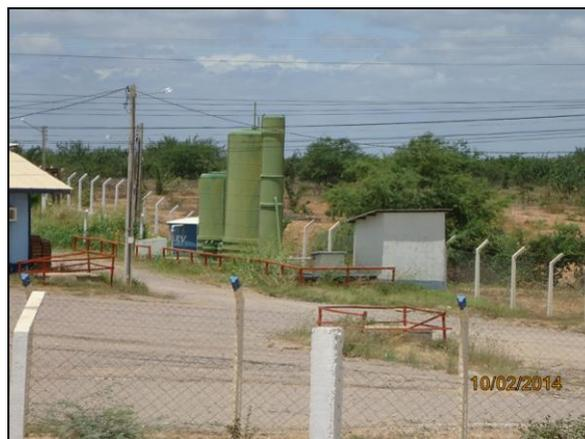
Foto 4.2.58. Sistema de tratamento de efluentes do canteiro de obras de Cabrobó - PE composto por reator UASB seguido de filtro anaeróbico (fev/2014).
