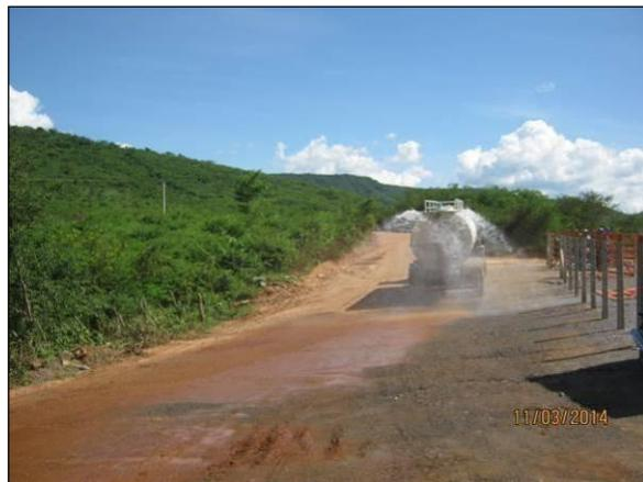
Foto 4.2.213. Umectação da via de acesso próximo ao canteiro avançado do reservatório Caiçara (mar/2014).
