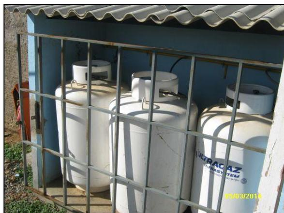
Foto 4.2.83. Botijões de gás GLP armazenados de forma adequada (mar/2014).
