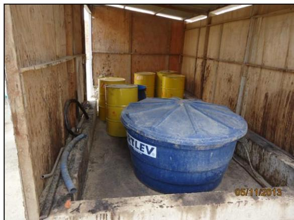
Foto 4.2.51. Estrutura para armazenamento de aditivos de concreto com piso impermeável adequado na central de concreto do WBS 1210 (nov/2013).
