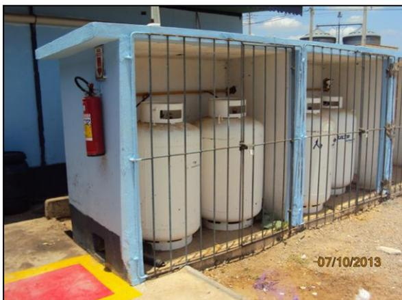
Foto 4.2.42. Baías para armazenamento de botijões de gás da cozinha do canteiro de obras com equipamento contra incêndio (out/2013).
