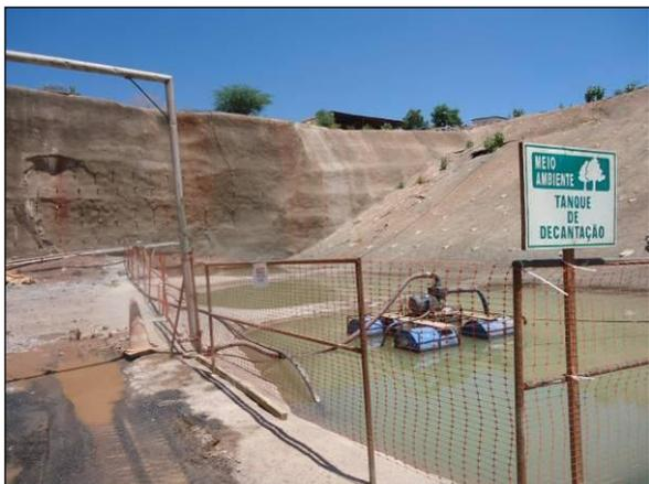
Foto 4.2.455. Instalação de guarda-corpo nos tanques de água de reuso do jumbo, na frente de serviço do emboque do túnel Cuncas I - WBS 1410 (dez/2013).
