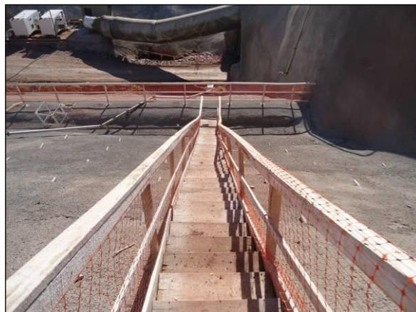
Foto 4.2.456. Escada com corrimão implantada em área de talude no emboque do túnel Cuncas I - WBS 1410. (mar/2014).
