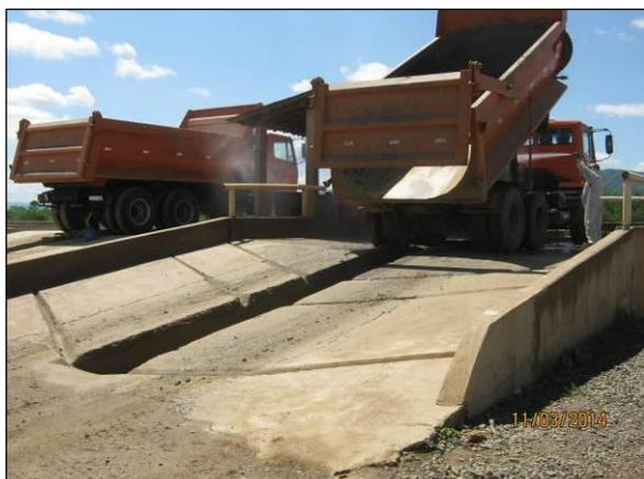
Foto 4.2.237. Lava jato com pista impermeabilizada e canaletas ligadas ao SAO, no canteiro central do antigo Lote 06 (mar/2014).
