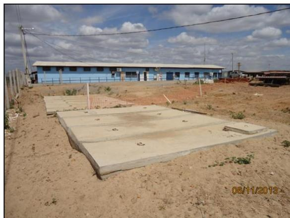
Foto 4.2.101. Sistema de tratamento de efluente do canteiro de obras composto por fossa séptica seguida de sumidouro (nov/2013).
