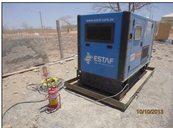
Foto 4.2.149. Gerador instalado sobre bandeja de contenção e equipamento contra incêndio disponível na frente de serviço do emboque do túnel Milagres-Jati – WBS 1403 (out/2013).
