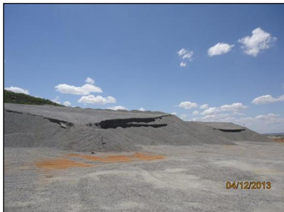
Foto 4.2.300. Material beneficiado em britador no reservatório Serra do Livramento – WBS 1107 em área de bota-espera para uso na construção da EBI-2 (dez/2013).
