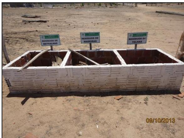
Foto 4.2.547. Baias para armazenamento de resíduos sólidos da estrutura de apoio (out/2013).
