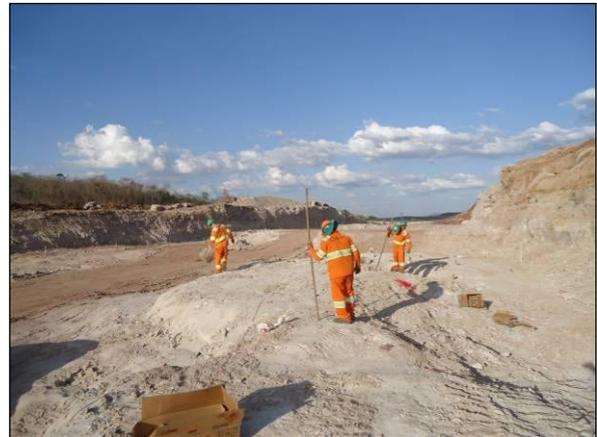
Foto 4.2.201. Atividade de carregamento de explosivos no vertedouro do reservatório Boi I (dez/2013).
