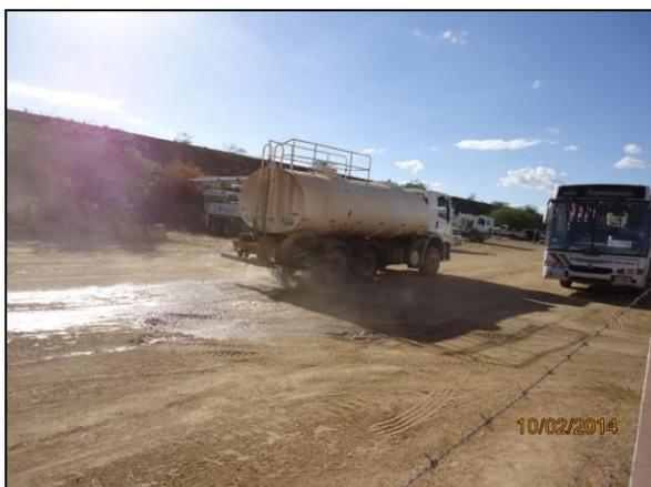
Foto 4.2.247. Umectação da via de acesso ao canteiro de apoio e à EBI-01 (fev/2014).
