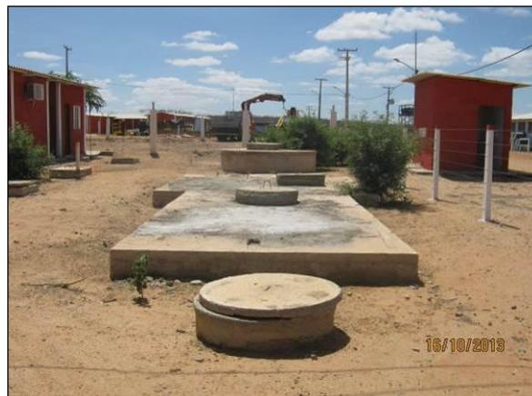
Foto 4.2.339. Sistema de tratamento de esgoto do canteiro de obras com manutenção satisfatória (out/2013).
