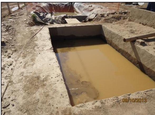
Foto 4.2.100. Sistema de tratamento de efluentes oriundos do lava-jato, oficina mecânica e posto de abastecimento do canteiro de obras do distrito de Umãs - PE (out/2013).
