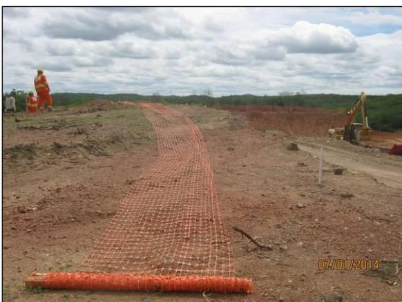
Foto 4.2.405. Instalação de tela sinalizadora em área de risco (jan/2014).
