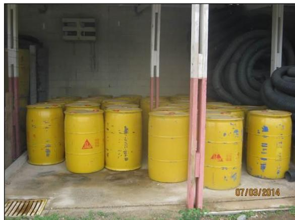
Foto 4.2.385. Aditivos armazenados em local coberto, com piso impermeabilizado sistema de prevenção contra vazamentos (mar/2014).
