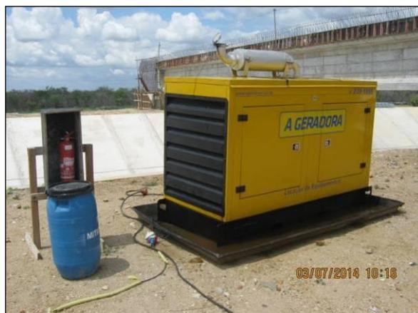
Foto 4.2.150. Gerador sobre bandeja de contenção e disponibilidade de equipamento contra incêndio e kit mitigação na frente de serviço da ponte WBS 1538 (mar/2014).
