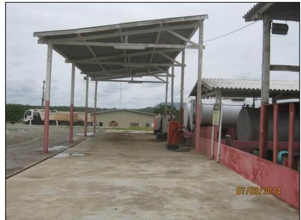
Foto 4.2.375. Posto de abastecimento com pista impermeabilizada, canaleta ligada ao SAO e área para abastecimento coberta (mar/2014).
