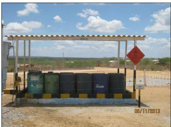
Foto 4.2.21. Local de armazenamento temporário de óleo usado com sinalização, cobertura, piso impermeável e sistema de contenção (nov/2013).
