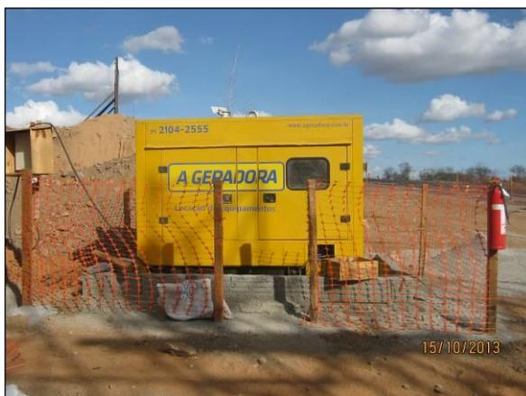
Foto 4.2.348. Bacia de contenção de grupo gerador e extintor de incêndio na frente de serviço do WBS 2205 (out/2013).
