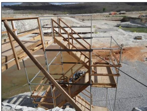
Foto 4.2.174. Escada com estrutura de andaime provida de corrimão e barras laterais de proteção na frente de obras do reservatório Porcos – WBS 1113 (nov/2013).
