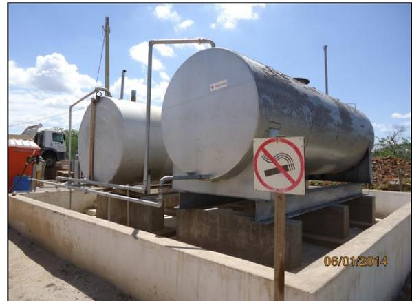
Foto 4.2.282. Posto de combustível do canteiro de obras central com disponibilidade de equipamento de segurança e de proteção ambiental (jan/2014).
