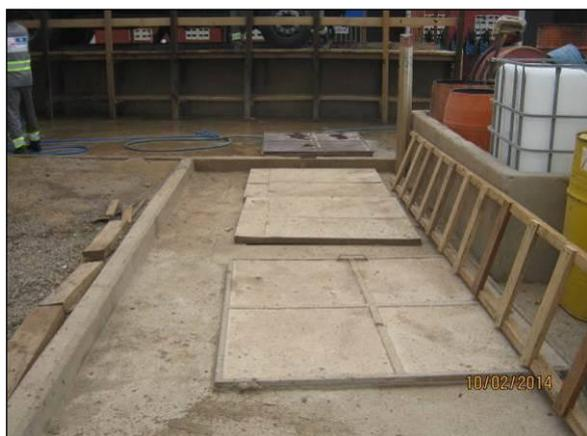
Foto 4.2.326. Separador de água e óleo do lava-jato com manutenção adequada em suas estruturas (fev/2014).
