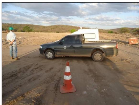
Foto 4.2.204. Barreira formada em distância de segurança para interromper o tráfego na área de desmonte de rocha (dez/2013).
