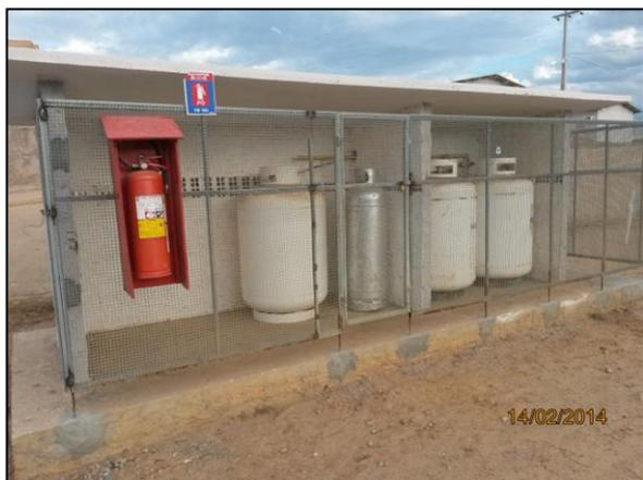
Foto 4.2.128. Equipamento contra incêndio disponível na baia de armazenamento de botijões de gás GLP no canteiro de Penaforte - CE (fev/2014).
