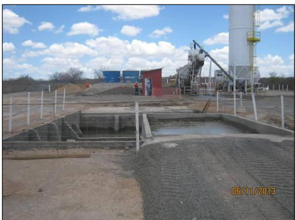
Foto 4.2.336. Sistema de tratamento da central de concreto com funcionamento adequado (nov/2013)
