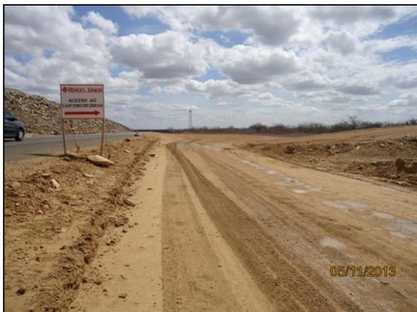
Foto 4.2.245. Vía de acesso ao canteiro de apoio da EBI-1 umectada e em condições adequadas para trafegabilidade (nov/2013).
