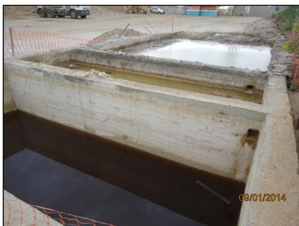
Foto 4.2.59. Tanque de decantação para lançamento dos efluentes provenientes da central de concreto do WBS 1210 e lavagem dos caminhões betoneiras (jan/2014).
