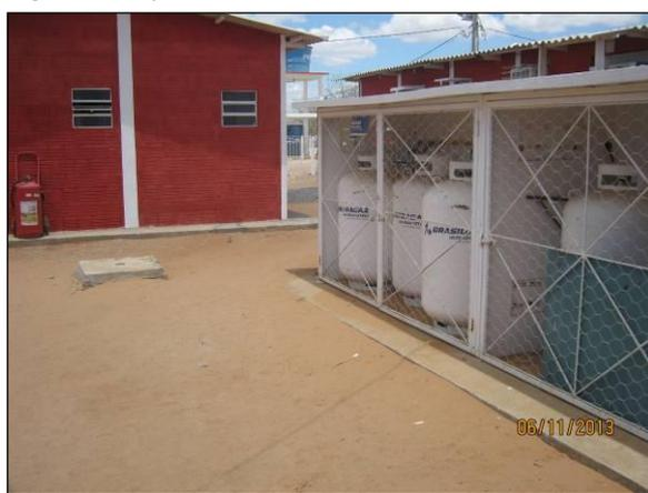
Foto 4.2.323. Armazenamento adequado dos botijões de gás da cozinha do canteiro de obras (nov/2013).
