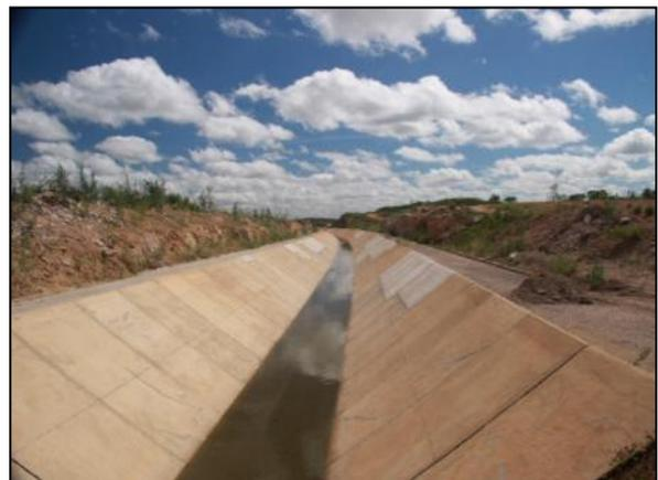
Foto 4.3.97. Canal concretado, Meta 3L, em Sertânia – PE (mar/2014).
