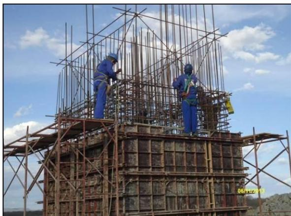
Foto 4.2.74. Colaboradores em atividade de armação em altura, com EPI adequados na frente de serviço da tomada d'água do reser. Serra do Livramento (nov/2013).
