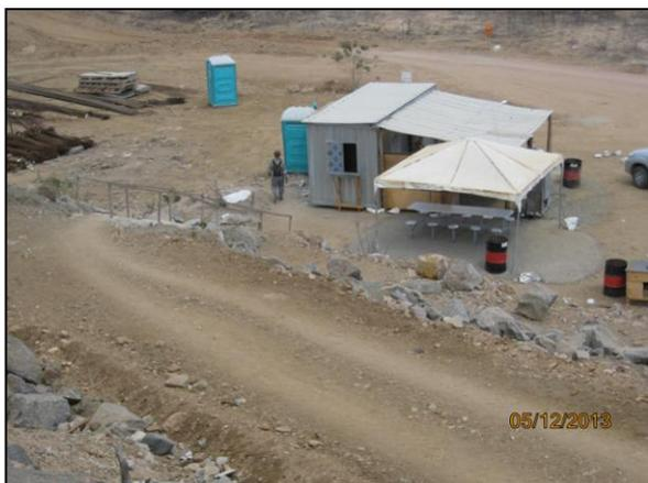
Foto 4.2.46. Estrutura de apoio da frente de serviço do aqueduto Logradouro - WBS 1305 com mesas, assentos, bebedouro, banheiros químicos e coletores de resíduos (dez/2013).
