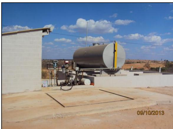
Foto 4.2.139. Posto de combustível com bacia de contenção, piso impermeável e canaletas de drenagem interligadas ao SAO no canteiro de obras de Penaforte – CE (out/2013).
