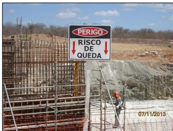
Foto 4.2.117. Placa com sinalização de risco de queda em segmento de corte na frente de serviço da estrutura de controle do reservatório Tucutu – WBS 1105 (nov/2013).
