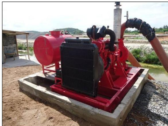
Foto 4.2.199. Motobomba com bacia de contenção na frente de serviço do reservatório Porcos – WBS 1113 (mar/2014).
