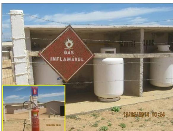
Foto 4.2.138. Armazenamento adequado dos botijões de gás GLP do canteiro de obras de Salgueiro – PE (fev/2014).
