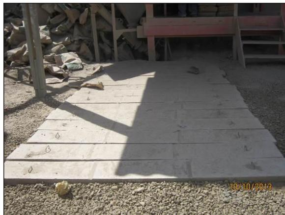
Foto 4.2.389. Sistema de tratamento que recebe os efluentes da rampa de abastecimento dos caminhões betoneiras em condições adequadas (out/2013).
