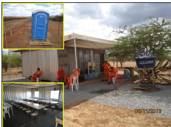
Foto 4.2.143. Estrutura de apoio com refeitório, bebedouro e banheiro químico na frente de serviço da tomada d' água do reservatório Terra Nova – WBS 1106 (nov/2013).
