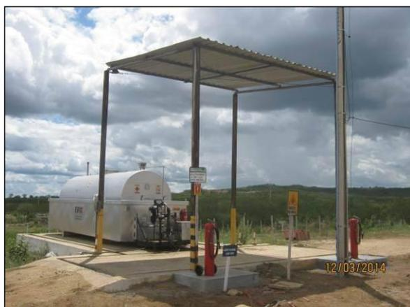
Foto 4.2.417. Posto coberto, com piso impermeabilizado, bacia de contenção e canaletas ligadas ao SAO (mar/2014).
