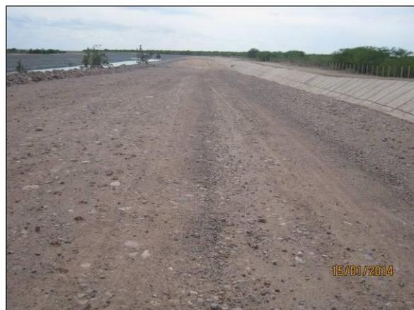
Foto 4.2.2. Via de acesso do Trecho II aplainada e bem dimensionada no canal de aproximação (jan/2014).
