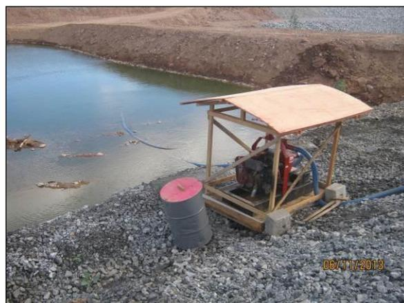
Foto 4.2.18. Gerador com cobertura e disposto sobre bandeja coletora no canal de aproximação (nov/2013).
