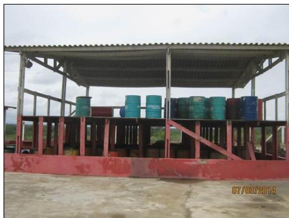
Foto 4.2.387. Baia para armazenamento de óleos e lubrificantes coberta, com piso impermeabilizado, mureta de proteção e canaletas ligadas ao SAO (mar/2014).
