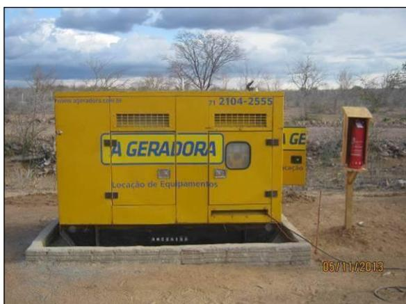
Foto 4.2.314. Extintor de incêndio em condições de uso disponibilizado em gerador nas frentes de serviços (nov/2013).
