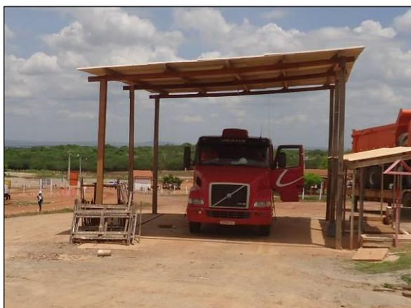
Foto 4.2.235. Posto de combustível implantado no canteiro central do antigo Lote 06, com área coberta, canaleta e sistema de tratamento de efluentes (fev/2014).
