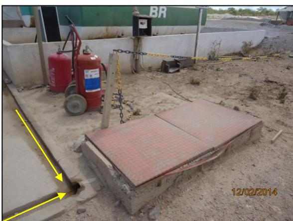
Foto 4.2.102. Canaletas de direcionamento de efluentes ao SAO do posto de abastecimento na frente de serviço do WBS 1214 (fev/2014).
