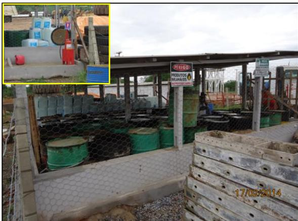
Foto 4.2.291. Baía para armazenamento de produtos perigosos com extintor de incêndio disponível (fev/2014).
