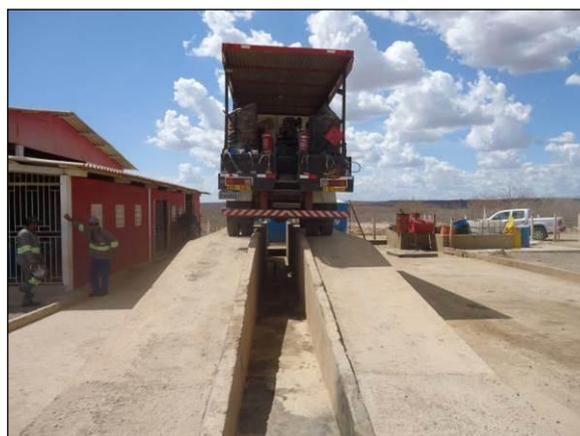
Foto 4.2.327. Lava-jato com piso impermeabilizado e sistema de contenção (dez/2013).
