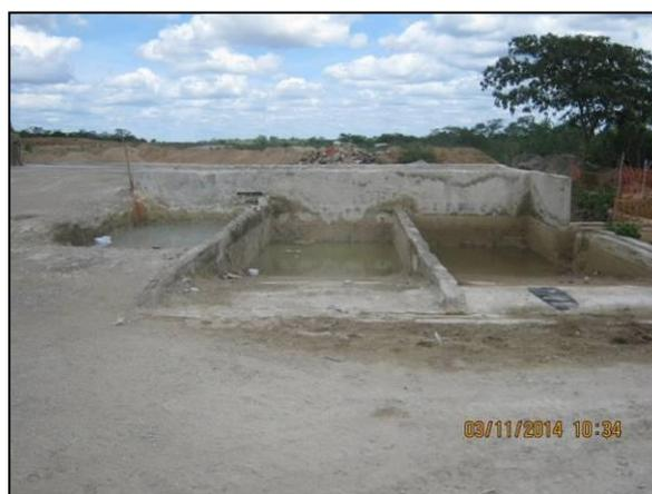
Foto 4.2.103. Tanques de decantação dos efluentes oriundos da lavagem dos caminhões-betoneira na central de concreto do WBS 1214 (mar/2014).
