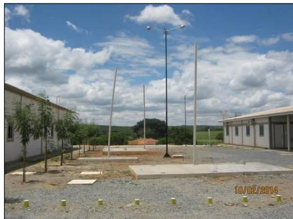
Foto 4.2.195. Fossas sépticas e sumidouros implantados para atender as instalações administrativas do canteiro central (fev/2014).
