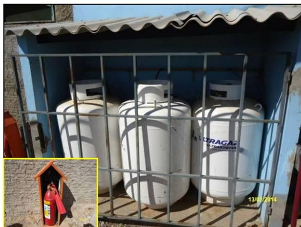
Foto 4.2.77. Equipamento contra incêndio disponibilizado próximo à baia de armazenamento dos botijões de gás do refeitório do canteiro de obras (fev/2014).
