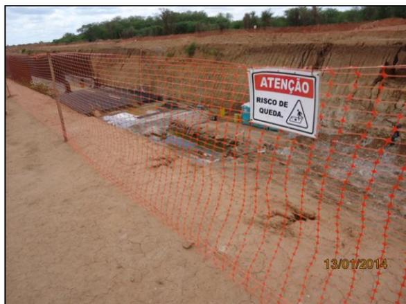
Foto 4.2.119. Placa e tela sinalizadoras instaladas em segmento de corte da frente de serviço da galeria Milagres – WBS 1365 (jan/2014).
