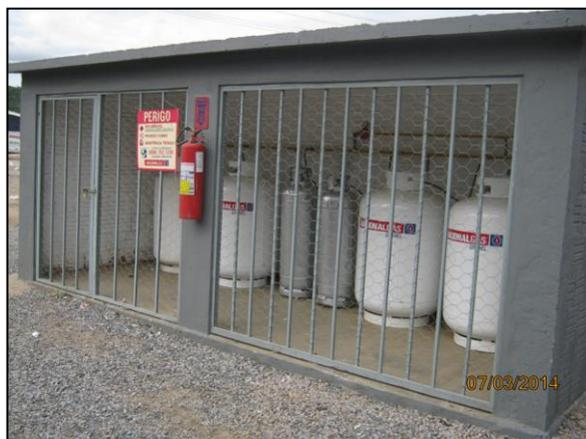
Foto 4.2.270. Armazenamento dos botijões de gás GLP em condições adequadas de segurança em baía do canteiro de obras (mar/2014).
