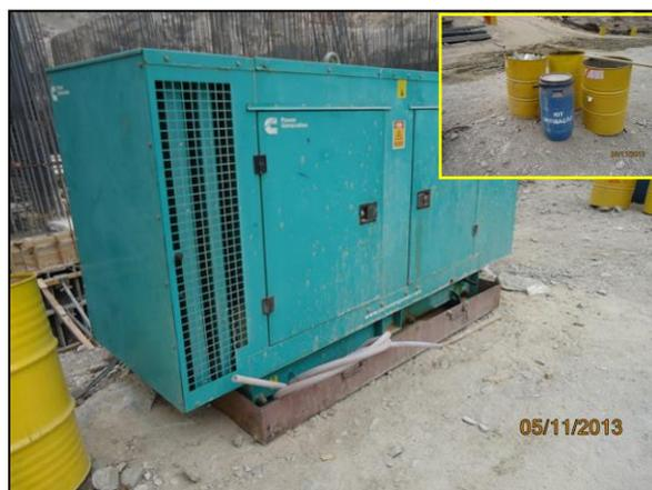
Foto 4.2.286. Gerador da frente de serviço da EBI-03 instalado sobre bandeja de contenção (nov/2013).
