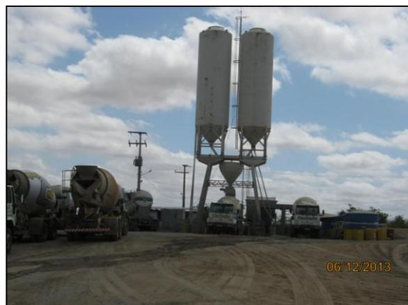
Foto 4.2.140. Central de concreto em operação no canteiro de obras de Penaforte – CE (dez/2013).
