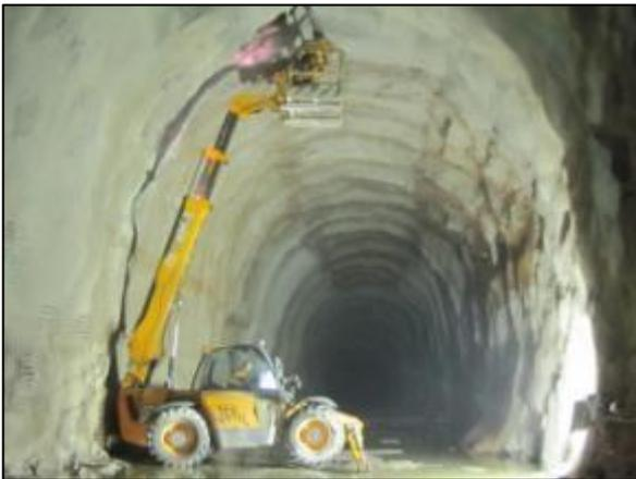
Foto 4.3.94. Revestimento da lateral do emboque do túnel Cuncas II, Lote 14, Meta 3N, em São José de Piranhas - PB (nov/2013).
