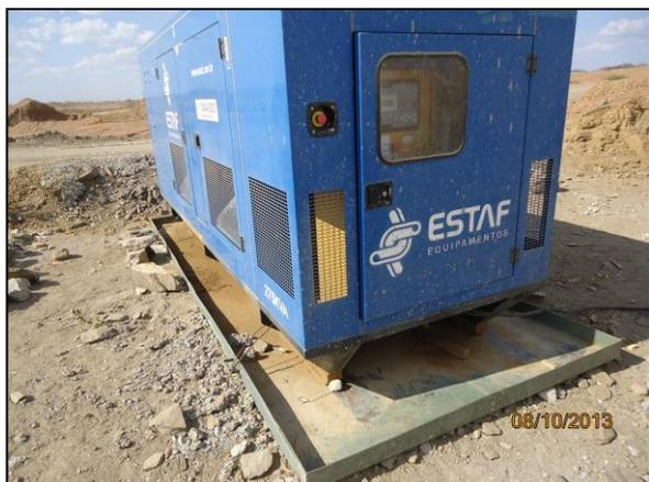
Foto 4.2.96. Gerador disposto sobre bandeja de contenção na área de formação do reservatório Mangueira - WBS 1108 (out/2013).
