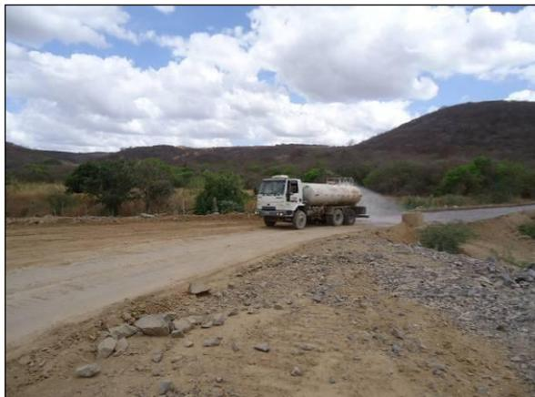
Foto 4.2.441. Umectação da via de acesso à frente de serviço da janela de serviço do túnel Cuncas I - WBS 1410 (nov/2013).
