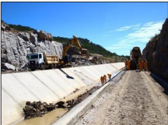
Foto 4.3.96. Concretagem de canal, Meta 2L, em Sertânia - PE (out/2013).
