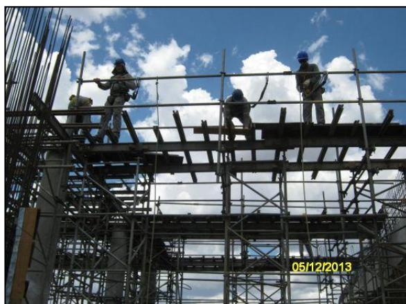
Foto 4.2.34. Colaboradores em atividade de altura equipados com cintos de segurança na frente de serviço do aqueduto Logradouro - WBS 1305 (dez/2013).
