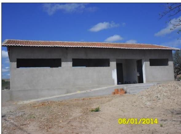
Foto 4.8.11. Sede da associação com cobertura e revestimento concluído, VPR Captação (jan/2014).
