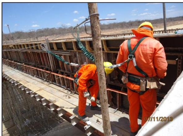
Foto 4.2.126. Colaboradores com EPIs adequados à atividade em altura na passarela WBS 1555 (nov/2013).
