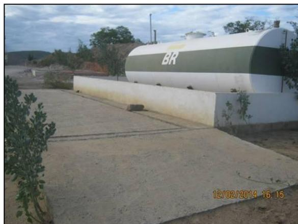
Foto 4.2.53. Estrutura do posto de abastecimento com bacia de contenção, piso impermeável e canaletas de drenagem associadas ao SAO (fev/2014).
