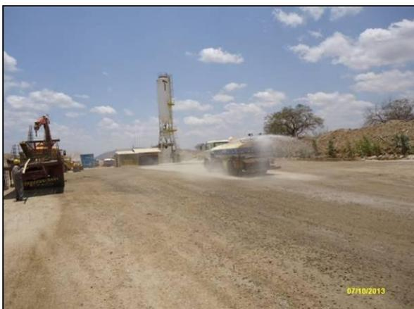
Foto 4.2.27. Atividade de umectação em via de acesso à central de concreto próxima ao segmento de canal WBS 1210 (out/2013).
