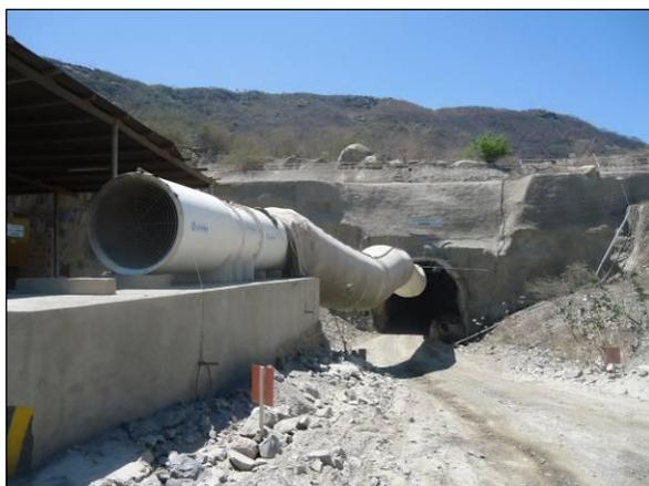
Foto 4.2.449. Duto de ventilação na frente de serviço do desmboque do túnel Cuncas I (dez/2013).
