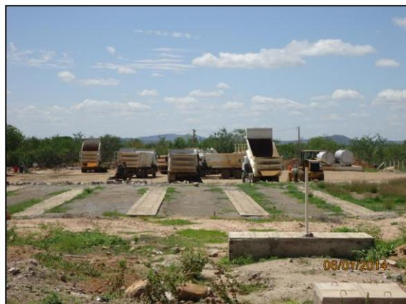
Foto 4.2.294. Sistema de tratamento de efluentes do canteiro de obras composto de fossa seguida de valas de infiltração (jan/2014).
