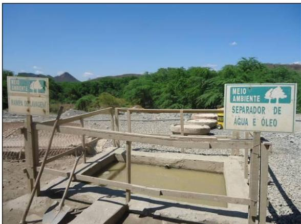
Foto 4.2.483. Separador de água e óleo do lava-jato da janela de serviço do túnel do Cuncas I (dez/2013).
