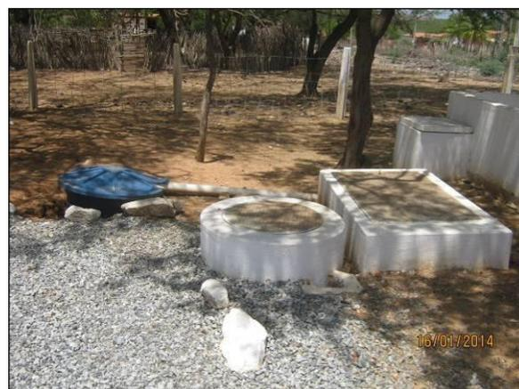
Foto 4.2.26. Separador de água e óleo do posto de abastecimento com manutenção adequada (jan/2014).
