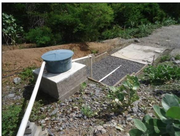
Foto 4.2.476. Fossa séptica que atende a estrutura de apoio do desemboque do túnel Cuncas I (jan/2014).
