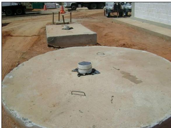
Foto 4.2.194. Sistema de tratamento de efluentes domésticos implantados para atender as instalações de apoio do canteiro central (nov/2013).
