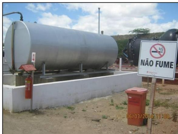
Foto 4.2.283. Extintor de incêndio e kit mitigação disponibilizados próximos ao posto de combustível do canteiro de apoio da EBI-01 (mar/2014).
