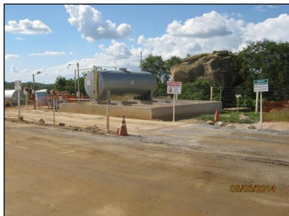
Foto 4.2.142. Posto de abastecimento com bacia de contenção, piso impermeável e canaletas de drenagem associadas ao SAO no canteiro de obras de Salgueiro – PE (mar/2014).
