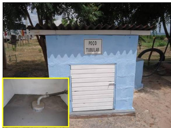
Foto 4.2.466. Estrutura do poço que abastece o alojamento/refeitório em Mauriti - CE devidamente protegida conforme NBR 12244 (jan/2014).
