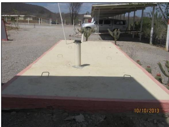
Foto 4.2.382. Tanque séptico para recebimento de efluentes dos escritórios em condições adequadas de manutenção (out/2013).
