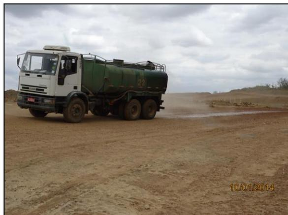
Foto 4.2.65. Umectação de via de acesso na área de formação do reservatório Mangueira - WBS 1108 (jan/2014).
