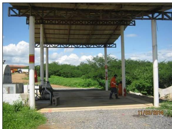
Foto 4.2.236. Posto de abastecimento implantado no canteiro central do antigo Lote 07, com área coberta, canaleta e sistema de tratamento de efluentes (mar/2014).
