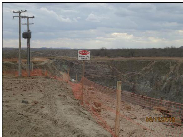
Foto 4.2.250. Placa com indicativo de risco de queda e tela sinalizadora em segmento de corte do poço de sucção da EBI-3 (nov/2013).
