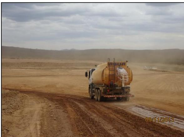
Foto 4.2.114. Umectação da via de acesso na área do reservatório Milagres – WBS 1110 para minimização da emissão de material particulado (nov/2013).
