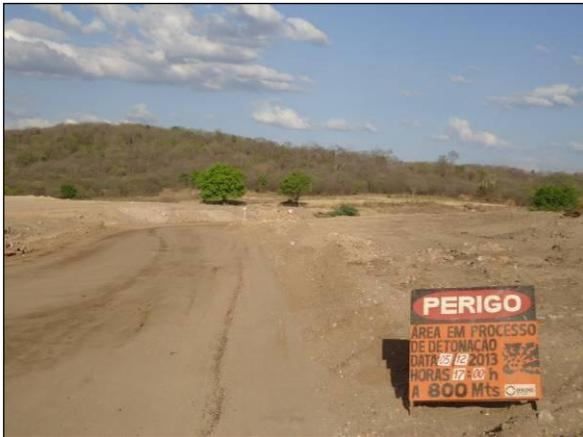
Foto 4.2.200. Placa de programação de detonação implantada a 800 metros do local de fogo previsto (dez/2013).
