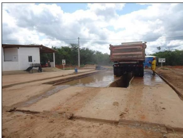
Foto 4.2.190. Lava jato com pista impermeabilizada e canaletas ligadas ao SAO, no canteiro de obras central (mar/2014).
