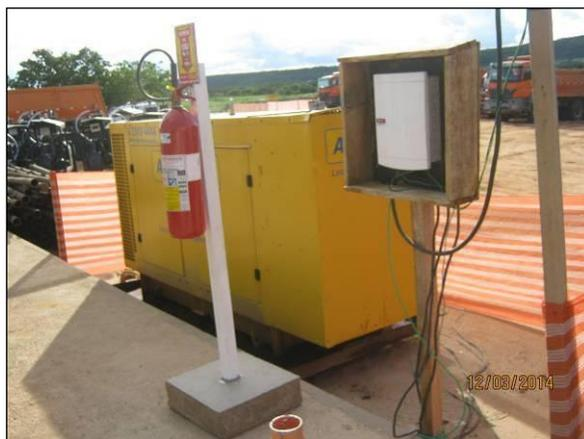
Foto 4.2.244. Gerador sinalizado, com extintor, cerquite e bandeja de contenção de vazamentos, implantado no canteiro de apoio São Miguel (mar/2013).
