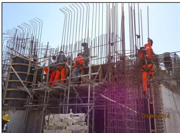
Foto 4.2.259. Colaboradores utilizando EPIs adequados à atividade de armação em altura na forebay de jusante da EBI-01 (jan/2014).
