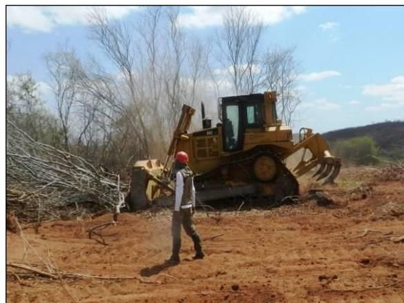
Foto 4.6.2. Acompanhamento de supressão vegetal mecânica (barragem) 'canal de interligação' (WBS 1228). Eixo Norte, Trecho II, Meta 2N (out/2013).
