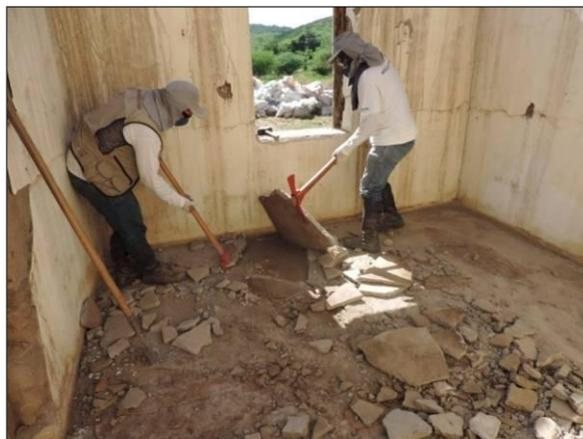
Foto 4.6.59. Sítio Filomena. Execução da retirada do piso atual. Eixo Norte, Meta 2N, Trecho II (fev/2014).
