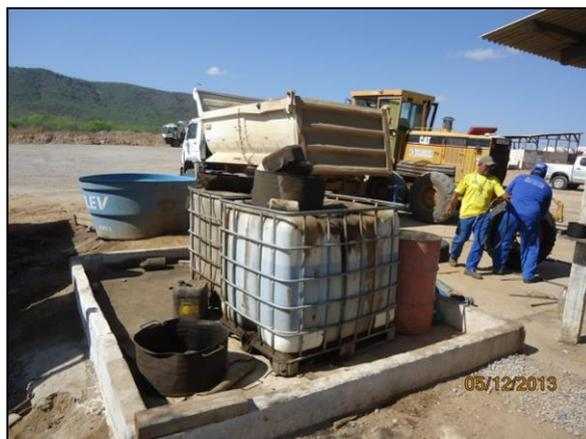
Foto 4.2.97. Local de estocagem de óleo lubrificante em bacia de contenção próxima à borracharia da estrutura de apoio do WBS 1214 (dez/2013).
