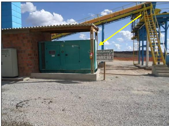
Foto 4.2.198. Gerador sinalizado, com cobertura, extintor de incêndio e bacia de cotenção instalado na central de concreto do reservatório Porcos – WBS 1113 (out/2013).
