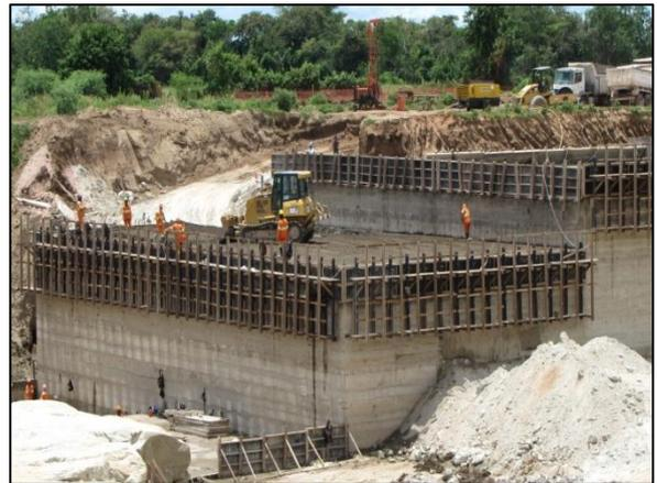
Foto 4.3.93. Construção do vertedouro do reservatório Porcos em Brejo Santo - CE, Meta 2N (fev/2014).
