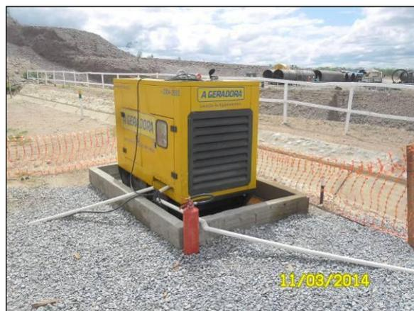
Foto 4.2.349. Bacia de contenção de grupo gerador e extintor de incêndio disposto na EBV-1 (mar/2014).
