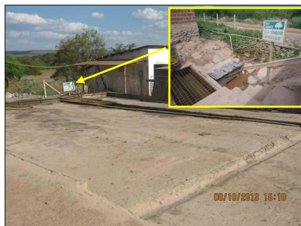
Foto 4.2.468. Lava-jato com sistema de tratamento de efluentes, implantado da frente de serviço do emboque do túnel Cuncas I (out/2013).
