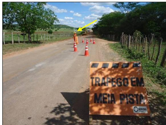
Foto 4.2.170. Sinalização de tráfego em meia pista com operador de "pare e siga" no trecho em manutenção da rodovia municipal que dá cesso ao canteiro central (jan/2014).
