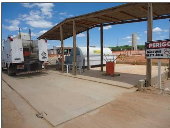
Foto 4.2.187. Posto de abastecimento com pista impermeabilizada, kit mitigação e canaletas de direcionamento dos efluentes ao SAO, no canteiro central (jan/2014).
