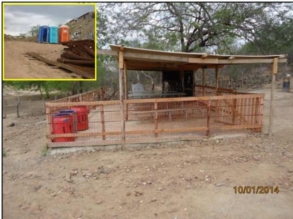
Foto 4.2.92. Estrutura de apoio com mesas, assentos, bebedouros, banheiros químicos e coletores de resíduos na frente de serviço do aqueduto Salgueiro - WBS 1309 (jan/2014).
