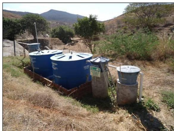
Foto 4.2.474. Sistema de tratamento dos efluentes sanitários do alojamento do canteiro central (out/2013).
