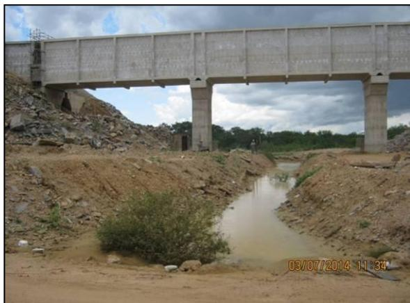
Foto 4.2.62. Canal de restituição para manutenção do fluxo hídrico intermitente do riacho próximo ao aqueduto Logradouro - WBS 1305.
