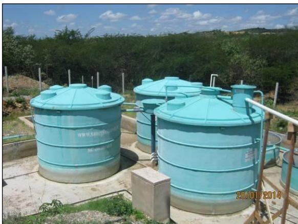
Foto 4.2.427. Estação de Tratamento de Esgoto (ETE) instalada no canteiro de obras (jan/2014).
