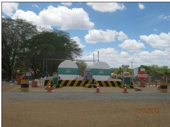
Foto 4.2.11. Posto de abastecimento com bacia de contenção, pista impermeabilizada e canaletas ligadas ao SAO (nov/2013).
