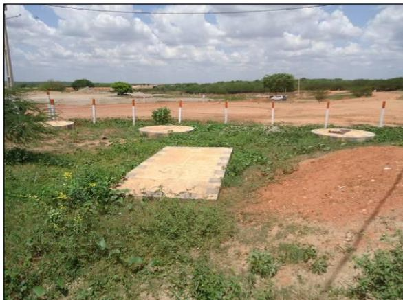
Foto 4.2.240. Fossa/sumidouro implantados para atender as instalações do alojamento do canteiro do antigo Lote 06 (jan/2014).
