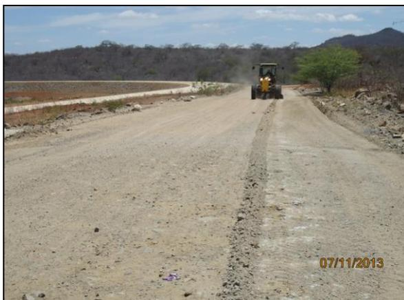
Foto 4.2.64. Motoniveladora em atividade de manutenção da via de acesso do segmento de canal WBS 1214 (nov/2013).
