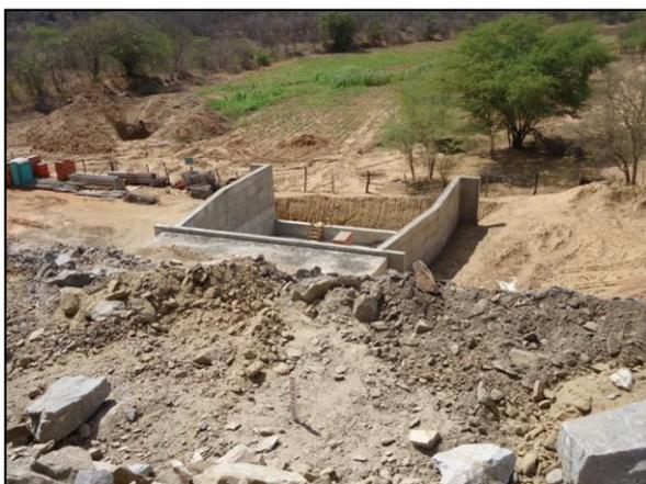
Foto 4.2.161. Bueiro simples celular de concreto - BSCC (bueiro 22) em implantação no segmento de canal WBS 1219 (out/2013).
