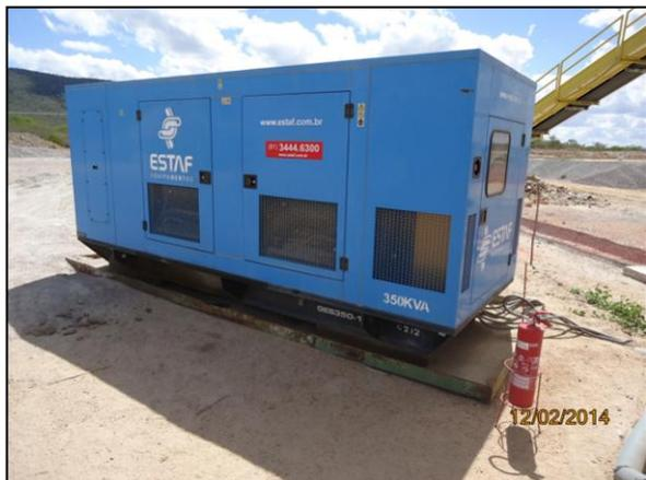
Foto 4.2.98. Gerador sobre bandeja de contenção e equipamento contra incêndio na frente de serviço da central de concreto do segmento de canal WBS 1214 (fev/2014).
