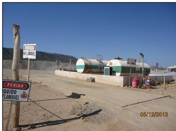
Foto 4.2.89. Posto de abastecimento com bacia de contenção, pista impermeabilizada e canaletas de drenagem ligadas ao SAO na frente de serviço do WBS 1214 (dez/2013).
