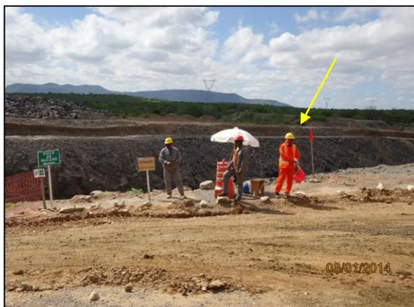
Foto 4.2.251. Colaborador em atividade de sinalização para controle do acesso de veículos ao poço de sucção da EBI-2 (jan/2014).
