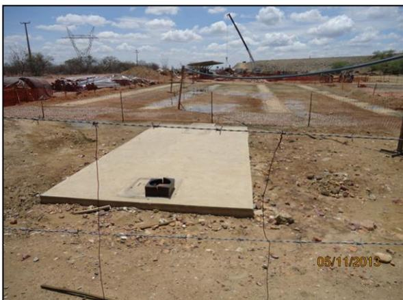
Foto 4.2.293. Sistema de tratamento de efluentes do canteiro de apoio da EBI-1 composto por fossa séptica seguido de valas de infiltração (nov/2013).
