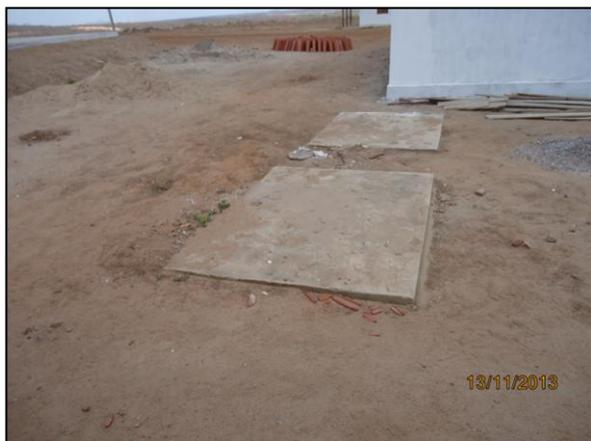
Foto 4.2.583. Sistema de tratamento de efluentes da estrutura de apoio composto por fossa séptica e sumidouro (nov/2013).
