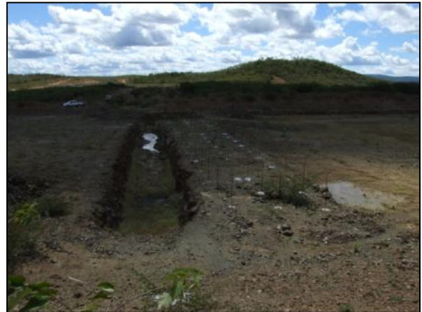
Foto 10.8. Vista da ombreira direita do eixo da Barragem Morros. P30 (maio/2012).
