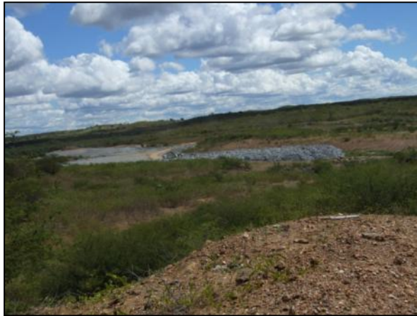
Foto 10.5. Vista para montante da ombreira direita do futuro vertedouro, para o futuro reservatório Morros. P30 (maio/2012).
