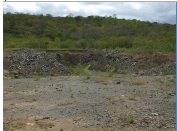
Foto 10.73. Vista do eixo para a ombreira esquerda da futura barragem do Dique Pereiros. P26 (jun/2012).
