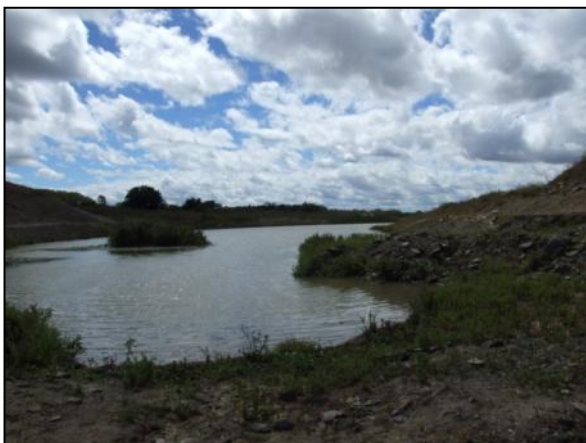
Foto 10.11. Vista para jusante do canal adentrando no futuro reservatório Morros. P37 (maio/2012).
