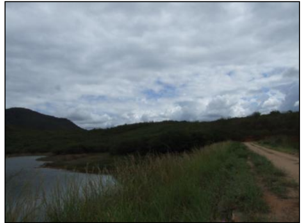
Foto 10.161. Vista para a ombreira esquerda do futuro reservatório Caiçara. De cima do dique. Aos fundos, tomadas d'água dos trechos III e IV P40, (maio/2012).
