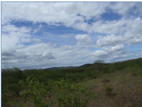
Foto 10.74. Vista do eixo do dique Cuncas, ombreira esquerda para a direita e para montante. P11 (jun/2012).
