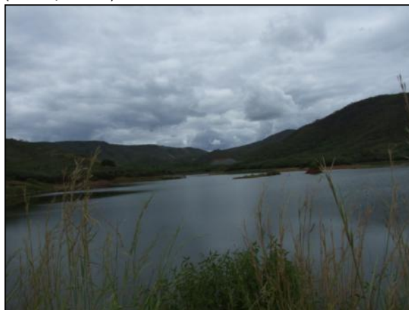
Foto 10.159. Vista de jusante para montante do futuro reservatório Caiçara. Existe um dique que será afogado. P40, (maio/2012).
