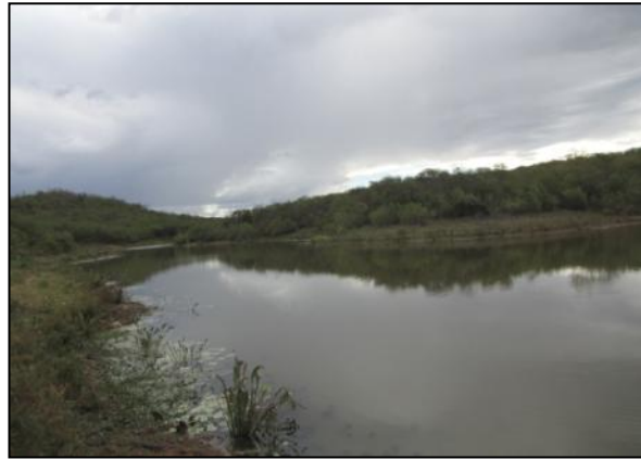
Foto 10.50. Acúmulo de água devido as obras do canal (maio/2012).
