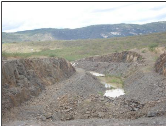
Foto 10.13. Obras do canal (maio/2012).
