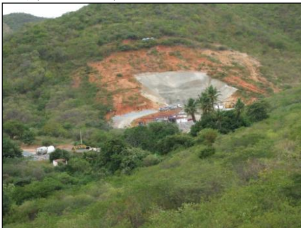
Foto 10.166. Vista para montante da planície de inundação do Córrego Caiçara, tendo na margem direita o desemboque do Cuncas II. P45, (maio/2012).
