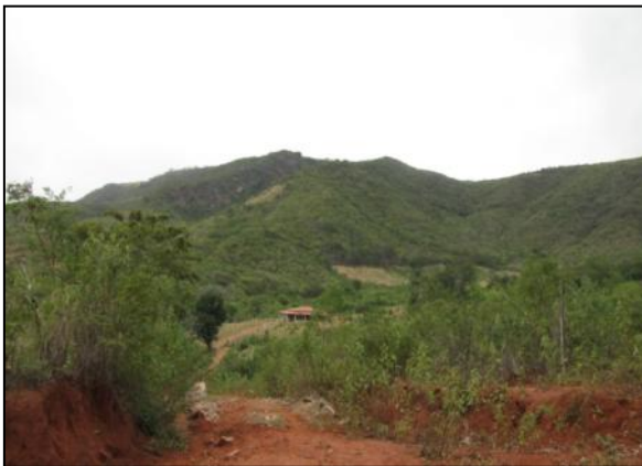
Foto 10.201. Área destinada ao reservatório Caiçara (maio/2012).
