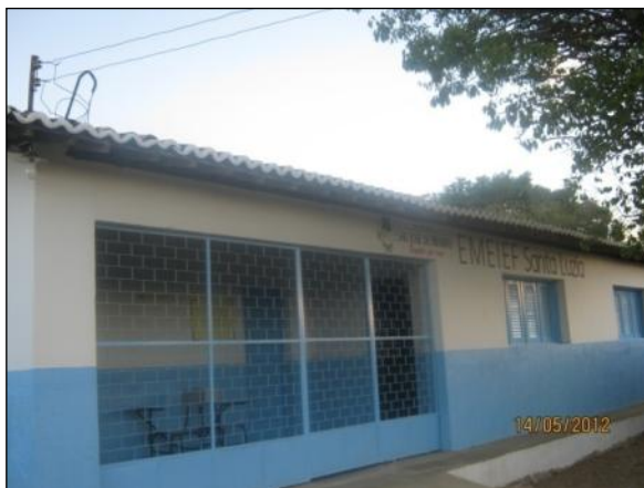
Foto 10.151. Escola Municipal Santa Luzia. São José de Piranhas – PB (maio/2012).
