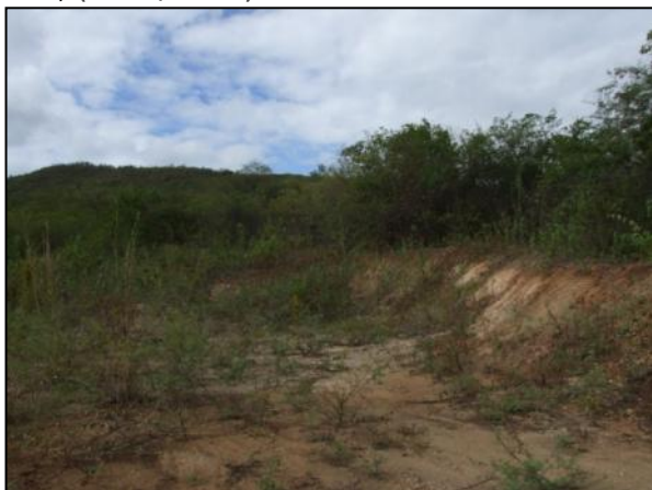
Foto 10.158. Vista para montante da ombreira direita do futuro reservatório Caiçara. Local de Saída do Canal e Trecho II. P41, (maio/2012).
