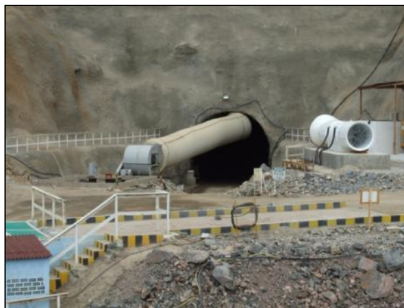
Foto 10.157. Entrada do canal no final do Reservatório Caiçara, pelo desemboque do Túnel Cuncas II. P50, (maio/2012).
