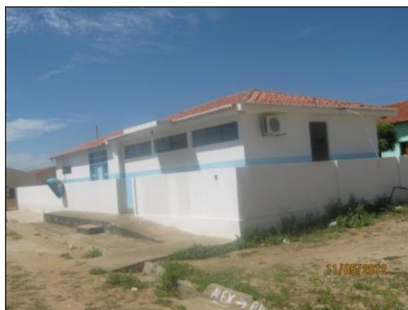
Foto 10.145. PSF II na localidade Boa Vista, São José de Piranhas – PB (maio/2012).
