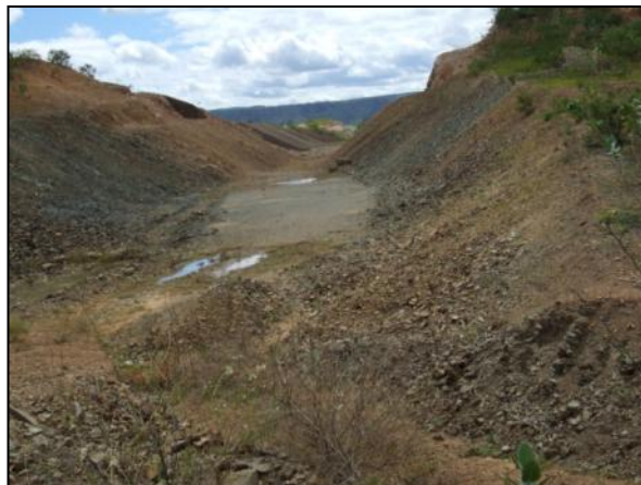
Foto 10.2. Vista para jusante do eixo do canal de saída do futuro reservatório Morros. P33 (maio/2012).
