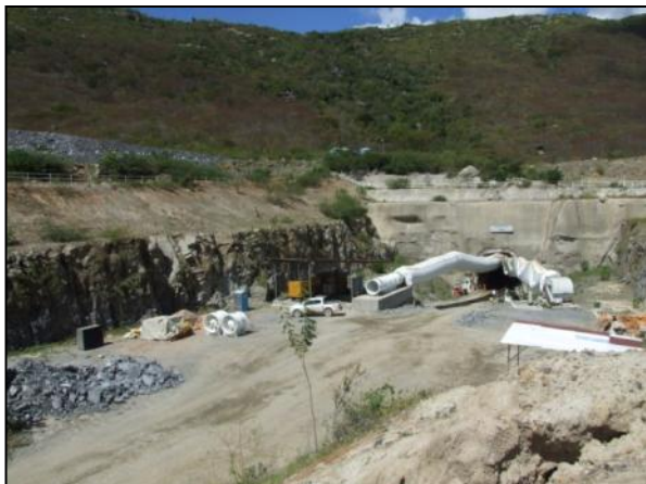
Foto 10.1. Vista do desemboque do túnel Cuncas I, local onde o canal vai adentrar ao Reservatório Morros. P34 (maio/2012).
