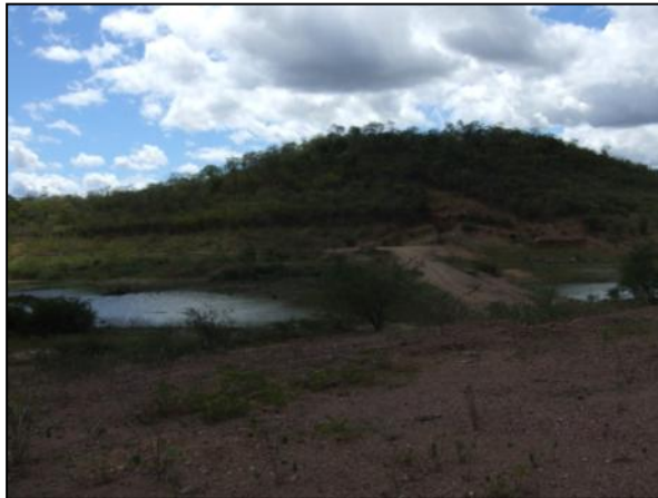
Foto 10.7. Vista do meio do eixo da barragem Morros, para a ombreira esquerda. P31 (maio/2012).
