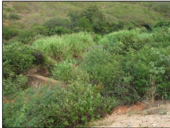
Foto 10.165. Vista para montante da planície de inundação do Córrego Caiçara. Existência de um dique. P51, (maio/2012).
