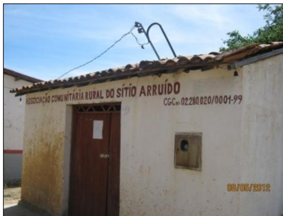
Foto 10.214. Sede da Associação da localidade. Arruídos. Cajazeiras – PB (maio/2012).
