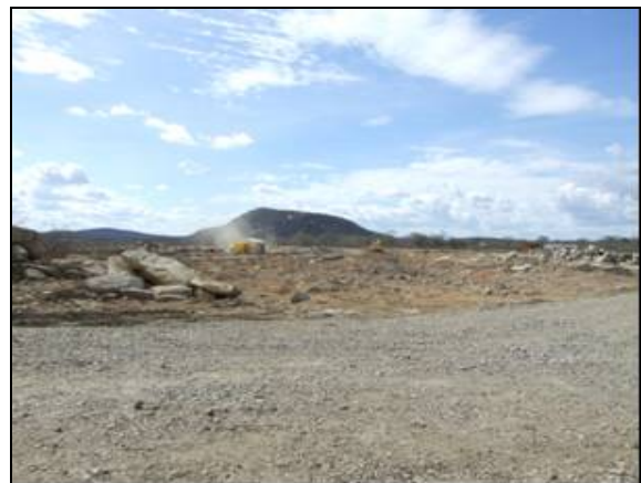
Foto 10.8. Vista do vertedouro sendo construído na ombreira esquerda da barragem Tucutu (out/2011).
