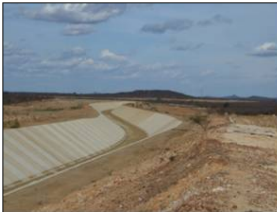
Foto 10.12. Vista para jusante da saída do Canal pela margem esquerda do reservatório Tucutu (out/2011).
