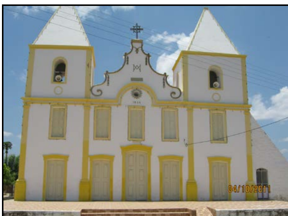
Foto 8.7. Igreja de N.Sª da Conceição, Cabrobó – PE (out/2011).
