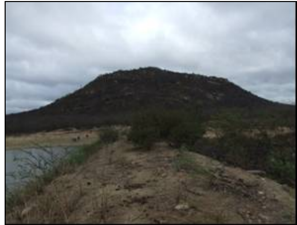
Foto 10.14. Vista do eixo da barragem do açude para a ombreira esquerda focando o serrote ao fundo (out/2011).
