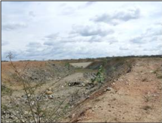
Foto 10.1. Vista para montante da entrada do canal ao reservatório Tucutu pela sua margem direita (out/2011).
