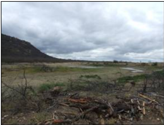
Foto 10.15. Vista para jusante dentro do açude do riacho Tucutu (out/2011).
