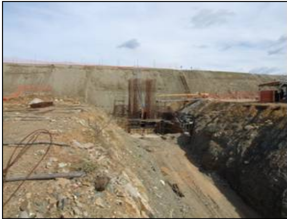
Foto 10.5. Vista para montante da saída do descarregador de fundo (out/2011).
