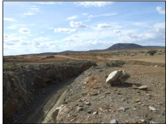
Foto 10.6. Vista para jusante do canal de saída do descarregador de fundo (out/2011).
