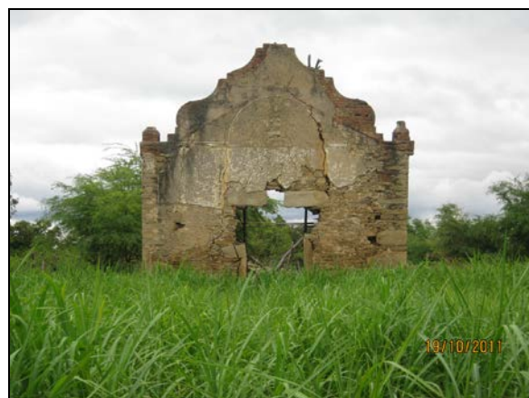
Foto 8.8. Ruínas da 1ª igreja de Cabrobó - PE (out/2011).
