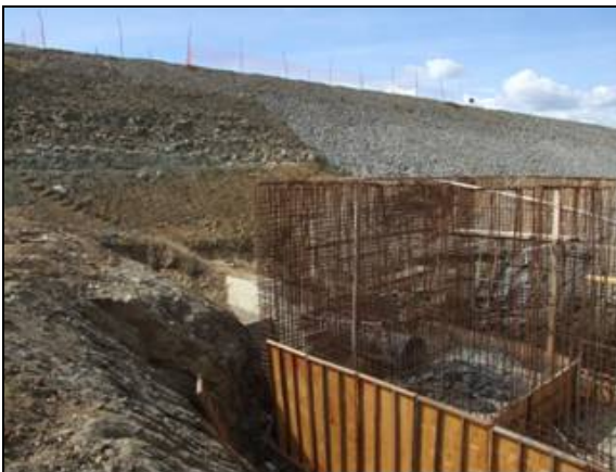
Foto 10.3. Vista para jusante da entrada do descarregador de fundo (out/2011).
