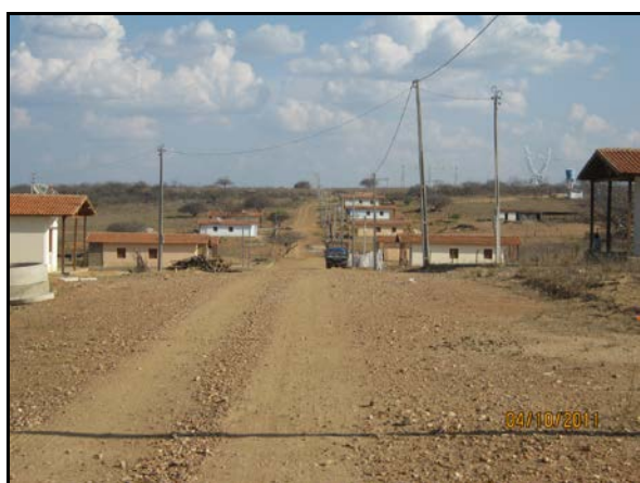
Foto 10.84. Vista das casas da VPR Captação, Cabrobó - PE (out/2011).
