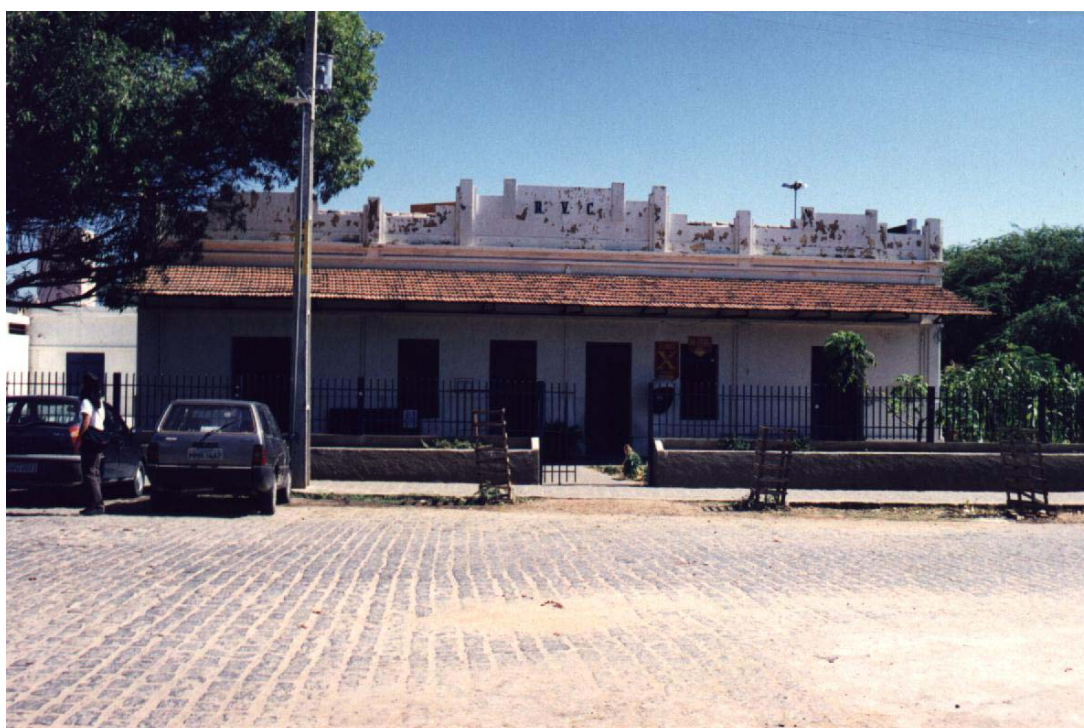
FIGURA 6.5.10-61 – ANTIGA ESTAÇÃO FERROVIÁRIA. CAJAZEIRAS-PB.
