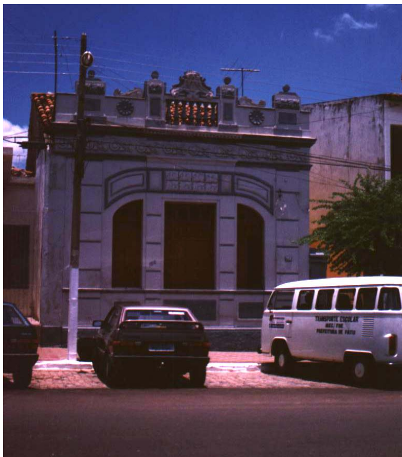
FIGURA 6.5.10-58 – CONSTRUÇÃO HISTÓRICA. PAU DOS FERROS-RN.
