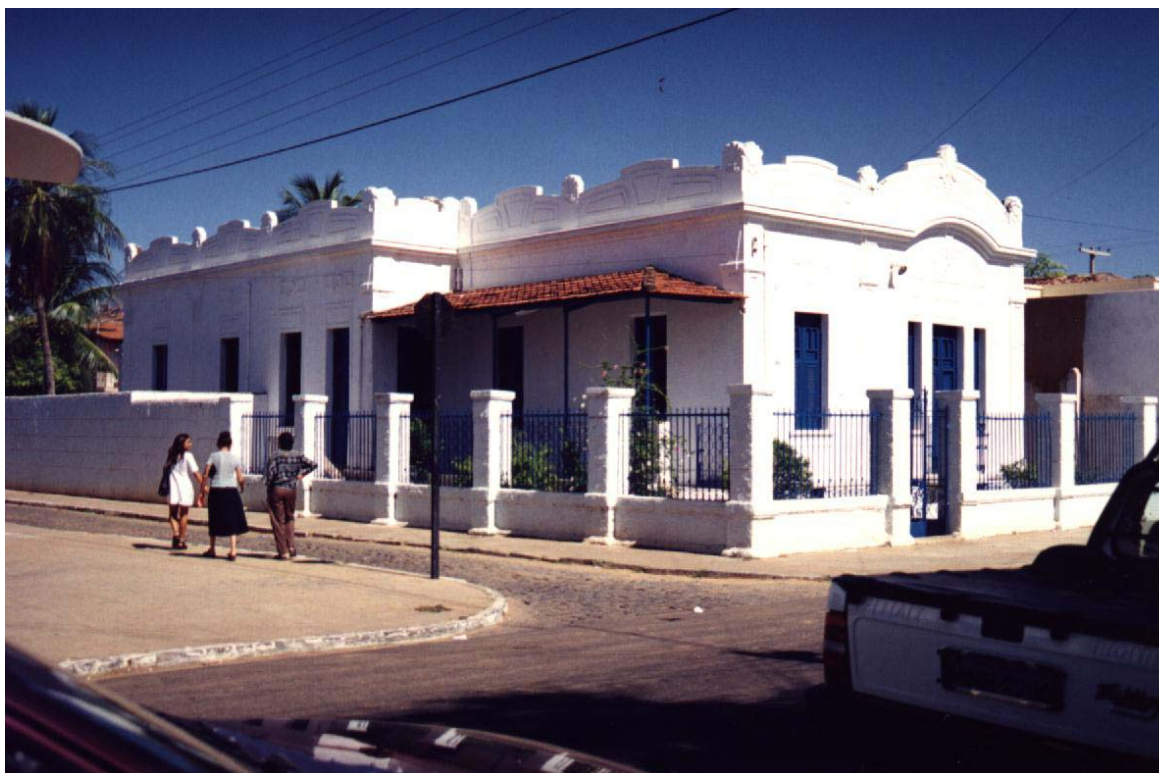
FIGURA 6.5.10-62 – CONSTRUÇÃO HISTÓRICA. CAJAZEIRAS-PB.
