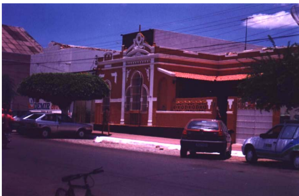
FIGURA 6.5.10-59 – CONSTRUÇÃO HISTÓRICA. PAU DOS FERROS-RN.
