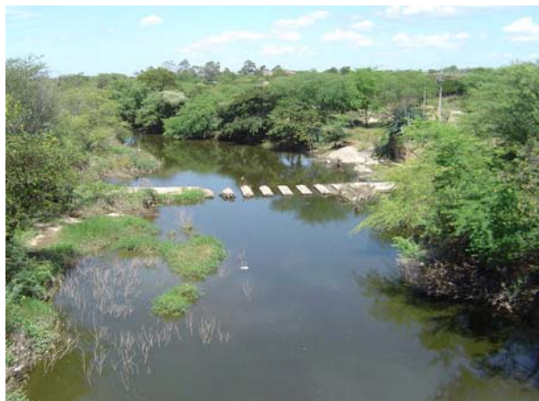
FOTO 6.2.6-16 - RIACHO MULUNGU EM MONTEIRO – VISTA PARA JUSANTE A PARTIR DA PONTE DA ESTRADA MONTEIRO-SUMÉ
