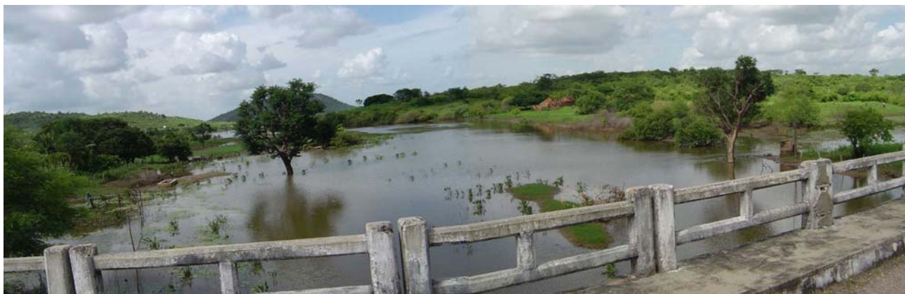
FOTO 6.2.6-9 - PONTE DA RODOVIA PB-405 SOBRE O RIACHO VACA MORTA – VISTA PARA MONTANTE
