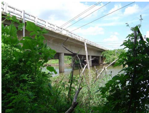
FOTO 6.2.6-10 - PONTE DA RODOVIA PB-405 SOBRE O RIACHO VACA MORTA
