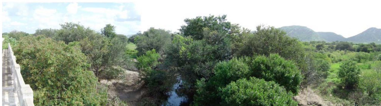
FOTO 6.2.6-11 - PONTE DA RODOVIA PB-405 SOBRE O RIO APODI PB-405
