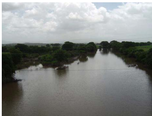
FOTO 6.2.6–22 - RIACHO DOS PORCOS – VISTA PARA JUSANTE A PARTIR DA PONTE DA BR-116 - DETALHE
