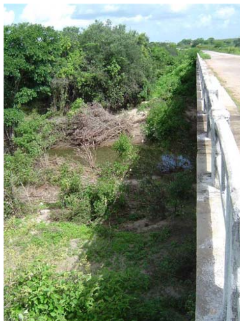
FOTO 6.2.6-14 - TABULEIRO DA PONTE DA RODOVIA PB-405 SOBRE O RIO APODI
