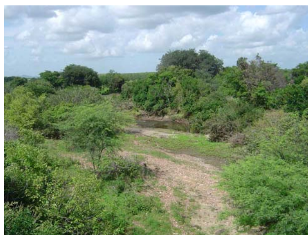
FOTO 6.2.6-13 - PONTE DA RODOVIA PB-405 SOBRE O RIO APODI – VISTA PARA JUSANTE
