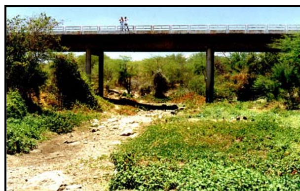
FIGURA 6.3.2.3-9 - PONTE DA BR-412 SOBRE O LEITO SECO DO RIO MONTEIRO (MONTEIRO - PARAÍBA)
