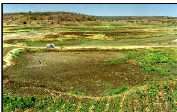
FIGURA 6.3.2.3-8 - VISTA DO TANQUE DE ACUMULAÇÃO DO "AÇUDE DE SUMÉ"(PB)
