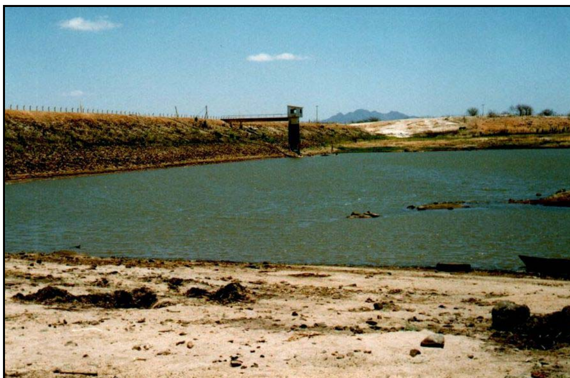
FIGURA 5.4.3.2-16 – AÇUDE MARACUJÁ, NO RIO DAS ANTAS, NA SUB-BACIA DO RIO PIANCÓ, NA BACIA DO RIO PIRANHAS, AO LADO DA RODOVIA BR-361 (SANTA TEREZINHA - PB).
