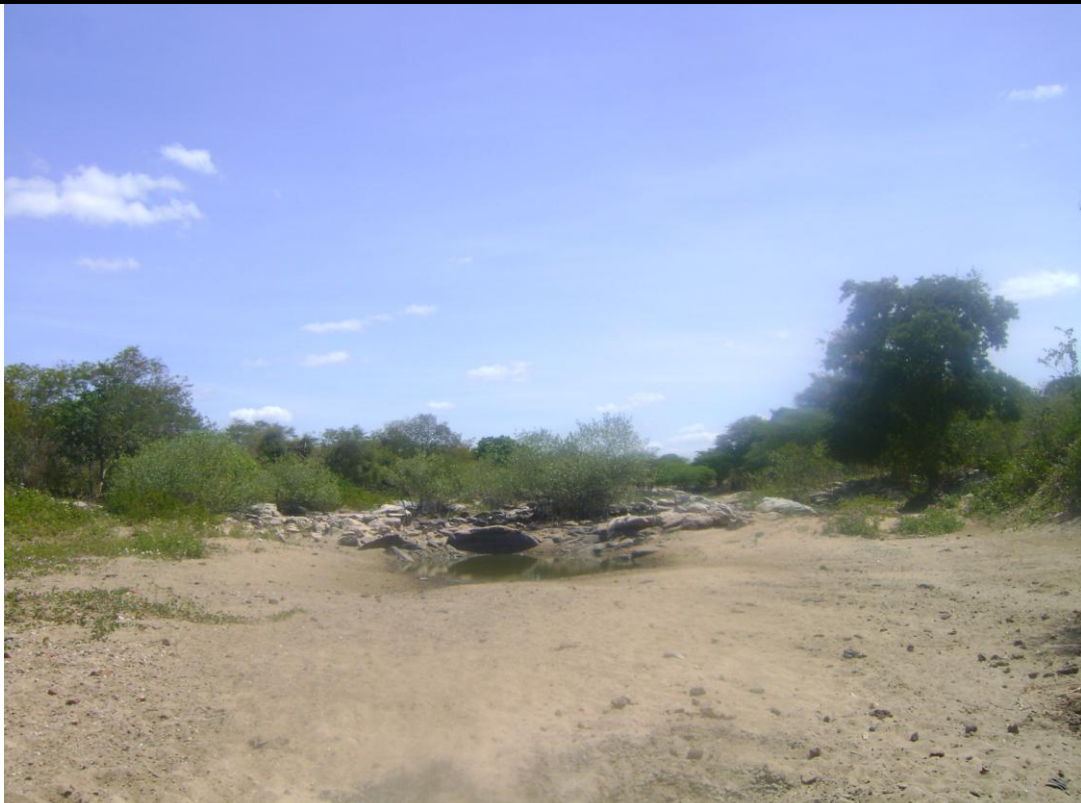
📍 FOTO N° 04-JUSANTE
