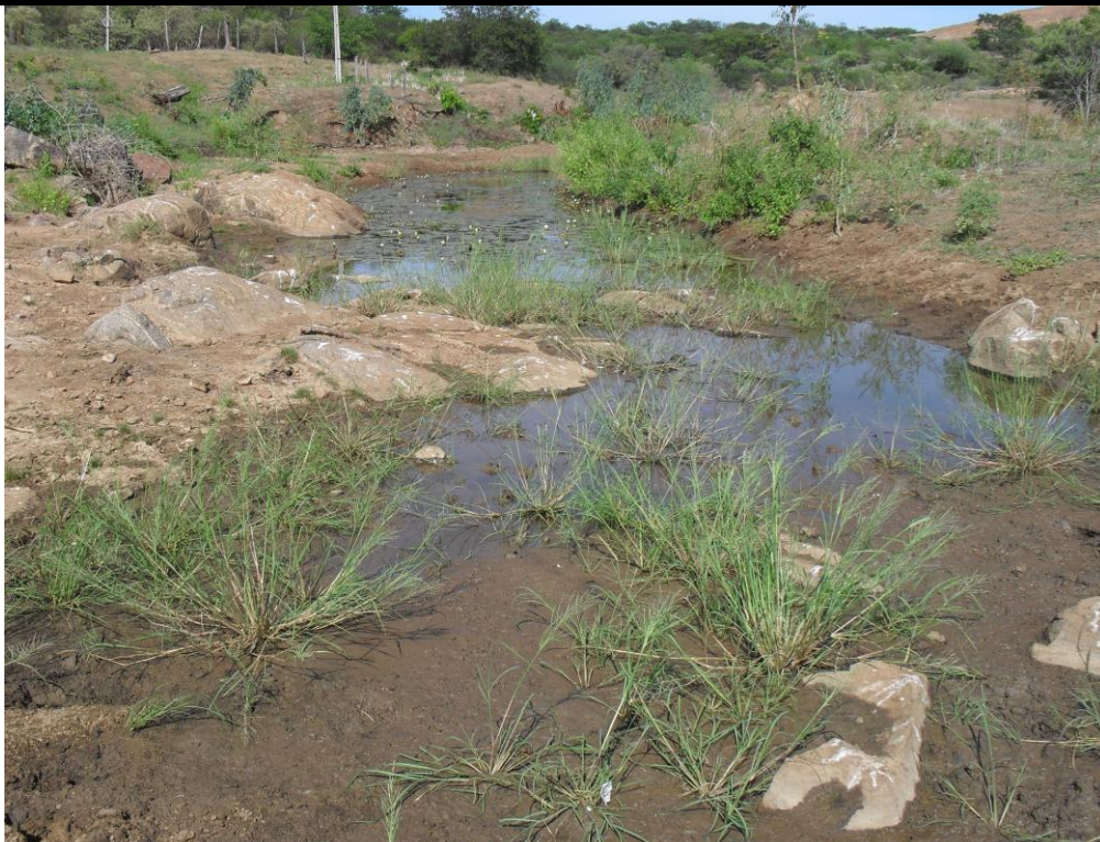
📍 FOTO N°03 – MONTANTE
