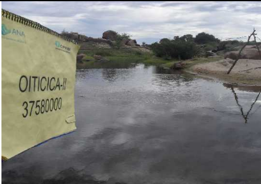
☞ FOTO N° 03 – MONTANTE
