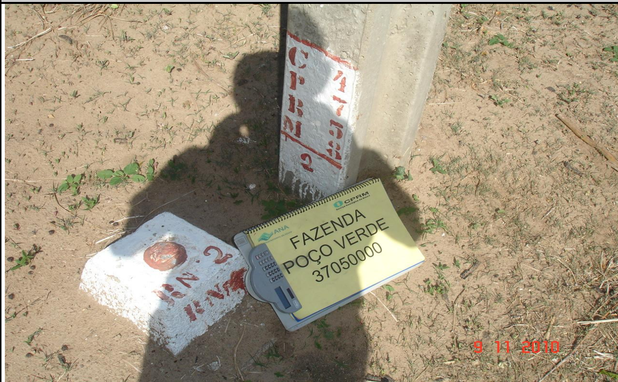
FOTO Nº 07 – RN-2 ANTES DA MANUTENÇÃO
