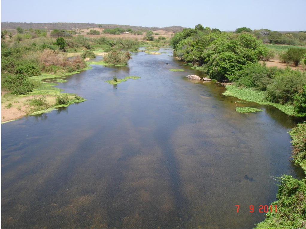
☞ FOTO N° 03 - MONTANTE
