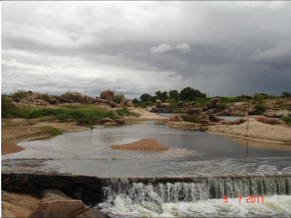
☞ FOTO N° 03 - MONTANTE
