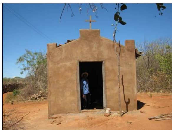
Foto 06. Capela localizada em Serra do Talhado, reformada pelos moradores.
