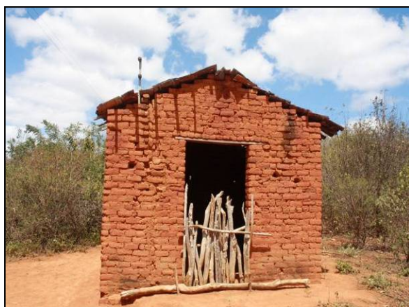
Foto 09. Capela antes da reforma, realizada no ano de 2012, construída com a técnica de adobe.
