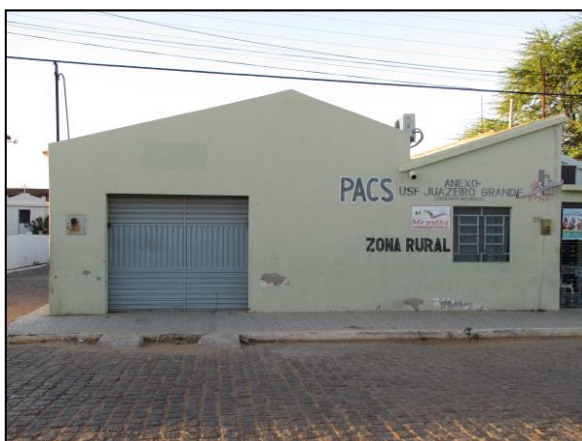
Foto 10. Posto de Saúde Juazeiro Grande destinado às comunidades quilombolas, localizado na zona urbana de Mirandiba.
