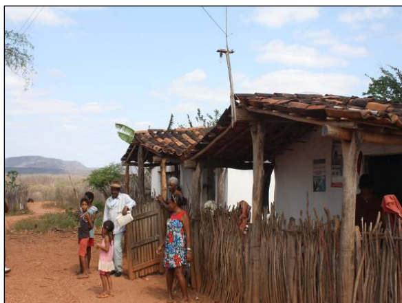
Foto 05. Moradias construídas com a técnica de taipa com reboco de cimento.
