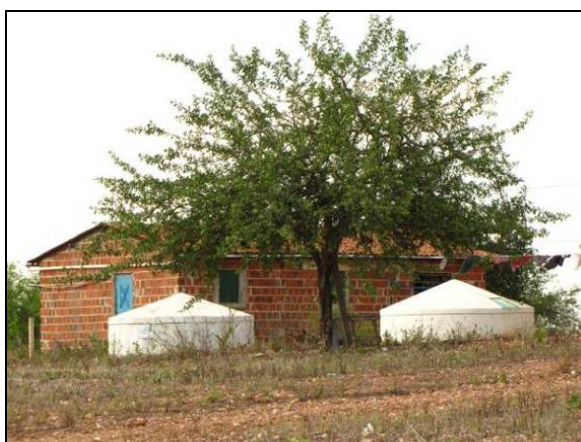
Foto 12. Cisternas com sistema de captação de água da chuva.
