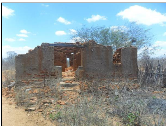
Foto 01. Ruína da casa da primeira moradora da comunidade, dona Alexandrina.
