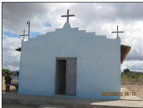
Foto 05. Capela localizada na comunidade de Cruz dos Riachos, construída pelos moradores.
