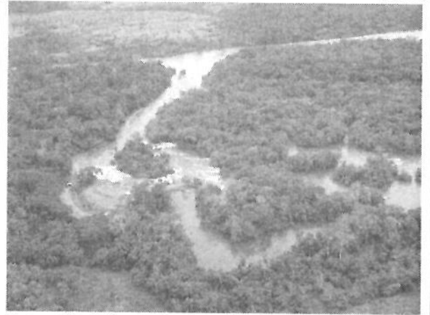
Foto 18. Vista aérea de CGH às margens do rio Teles Pires.
