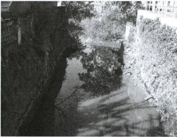
Figura 7: Rio Pedreira funcionando como receptor do esgoto sanitário da região
