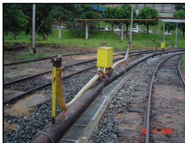
Figura 9.47: Conexões de engate e mangote flexível
