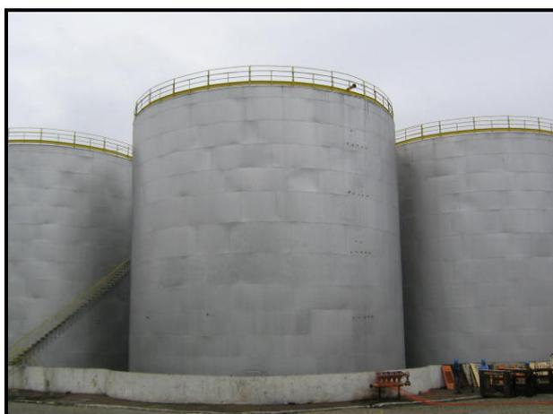
Figura 9.46: Tanques de armazenamento com bacia de contenção
