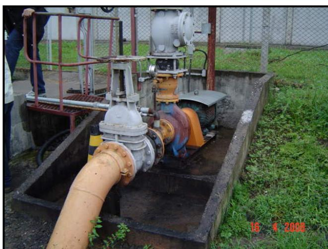
Figura 9.48: Dispositivos para o bombeamento do óleo recebido
