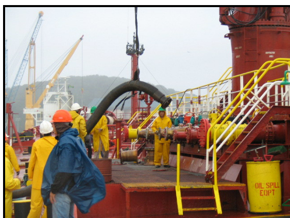
Figura 9.39: Içamento do mangote para acoplamento nos terminais do navio
