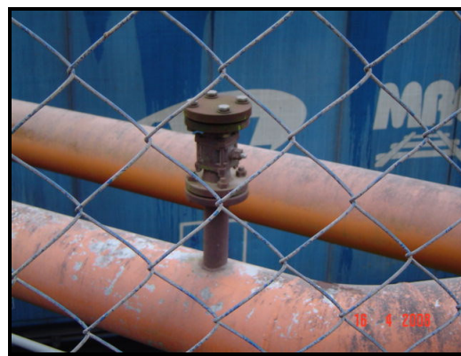
Figura 9.37: Válvula para alívio de pressão
