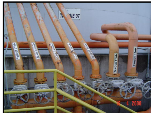
Figura 9.35: Comando por registros de válvulas
