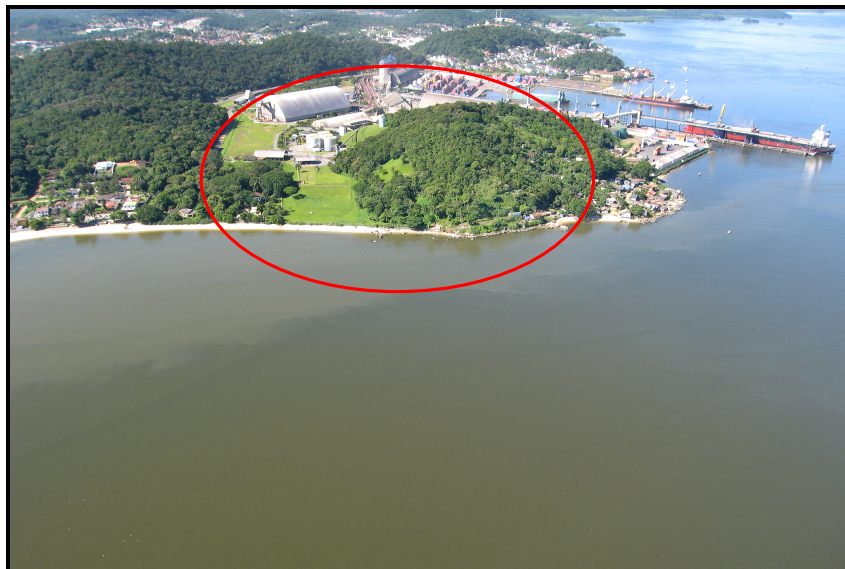
Figura 7.50: Visualização da área de instalação do empreendimento, mostrando a ocupação humana, a presença de edificações e a proximidade do porto.
