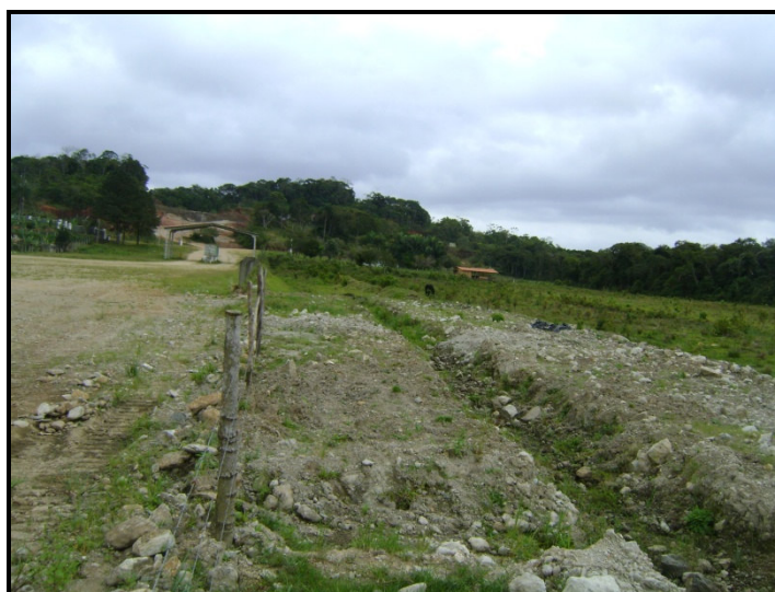
Figura 6.51: Vista parcial da vala de drenagem posicionada ao longo da extrema sul da área (04/09/08).
