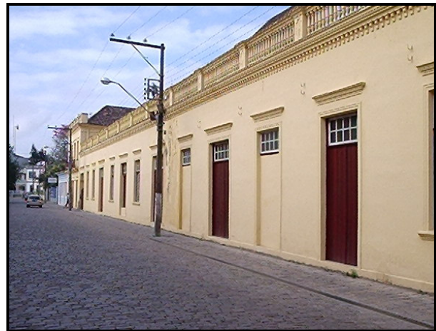
Figura 5.3: Edificação tombada pelo IPHAN.
