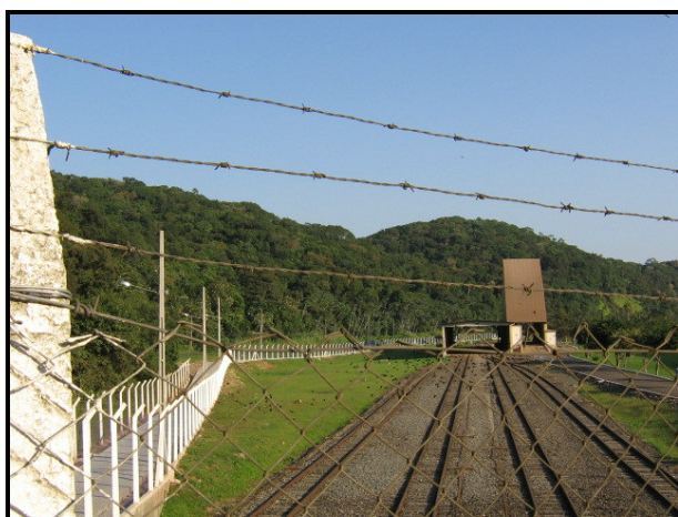
Figura 5.119: Moega pertencente à Bunge Alimentos para recebimento dos grãos transportados pelo modal ferroviário.
