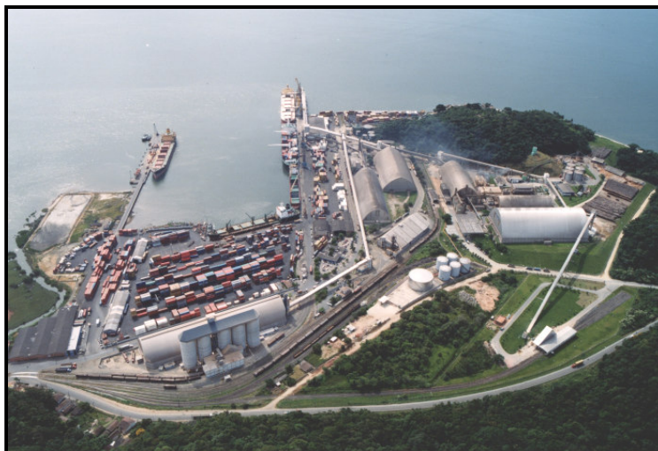
Figura 5.97: Vista geral do Porto de São Francisco do Sul. (Fonte: APSFS, 2005a).
