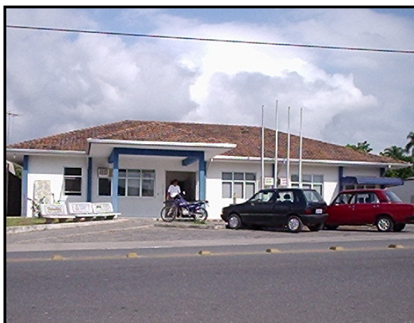
Figura 5.111: Vista Geral da delegacia da comarca de São Francisco do Sul.
