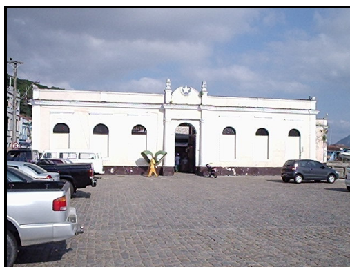
Figura 5.27: Fachada do Mercado Municipal de São Francisco do Sul.
