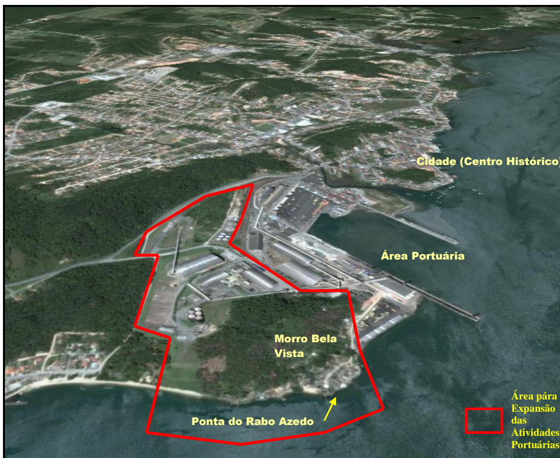
Figura 4.1: Vista aérea parcial de São Francisco do Sul destacando, entre outras, o Centro Histórico (Área da Cidade), a Área Portuária e as Áreas para Expansão das Atividades Portuárias. (Google Earth - 2008)
