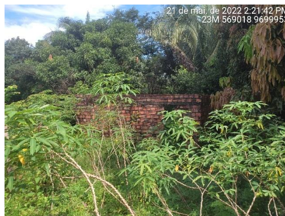
Foto 371 – Construção inacabada. Fonte: MRS, 2022.
