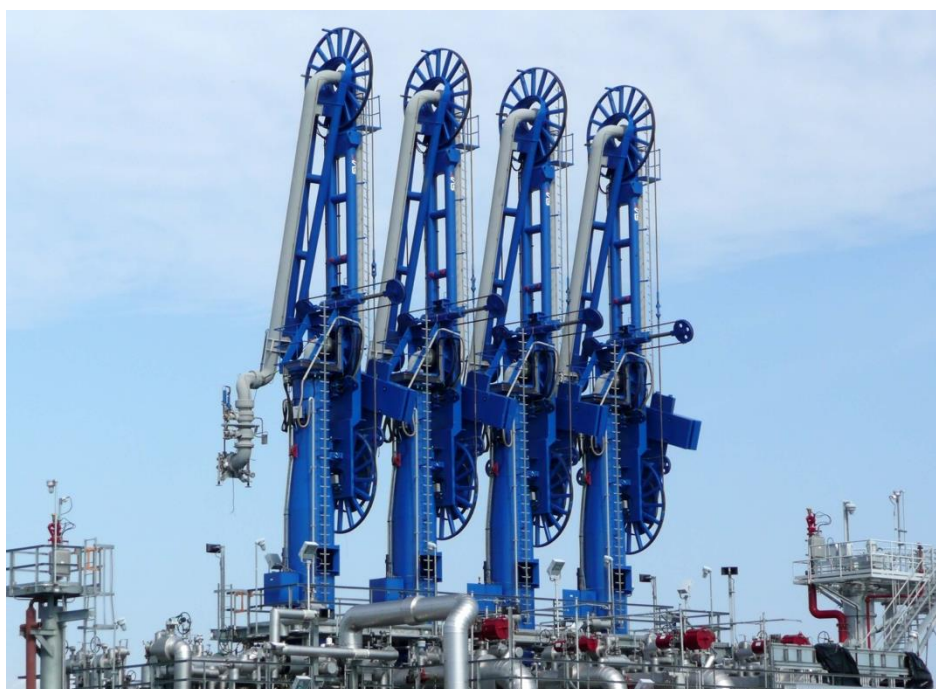
Figura 5 - Exemplo de braço de transferência de GNL. Fonte: Fabricante SVT GmbH
