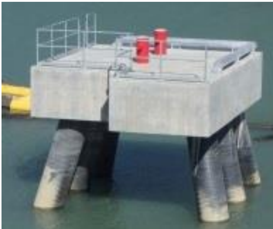
Figura 4 - Exemplo de píer de atracação em dolphins. Fonte: Squamish Terminals
