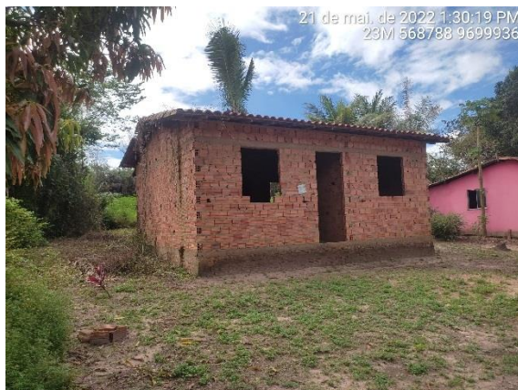
Foto 368 – Casa em construção. Fonte: MRS, 2022.
