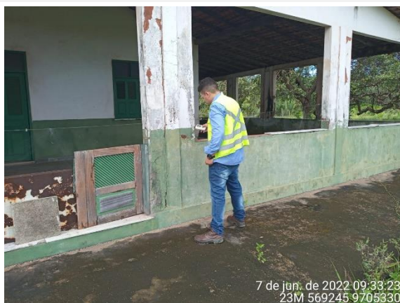
Foto 9 - Medição de vibração no Ponto 01.
