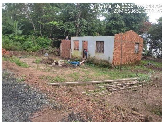
Foto 370 – Casa em construção. Fonte: MRS, 2022.
