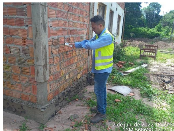
Foto 16 - Medição de vibração no Ponto 08.
