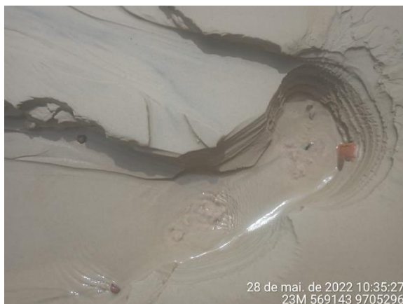
Foto 24 – Afloramento de água na AID do empreendimento.
