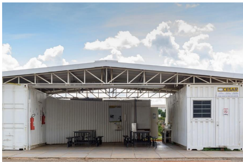
Figura 34 – Área interior, refeitório em contêineres. Fonte: Grupo Cesar.
