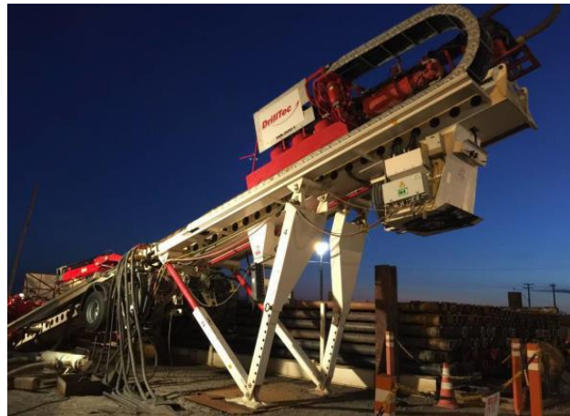
Figura 42 – Perfuratriz direcional horizontal.
