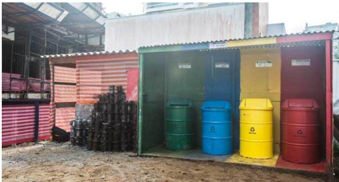
Figura 41 - Coleta seletiva em canteiro de obras. Fonte: ArqBrasil.
