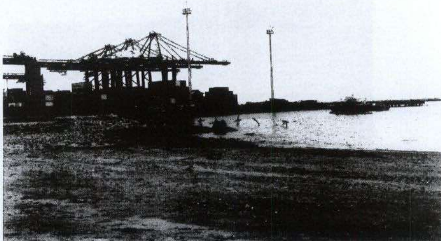
Ilustração 34: Área destinada a ampliação do Porto de Salvador.
