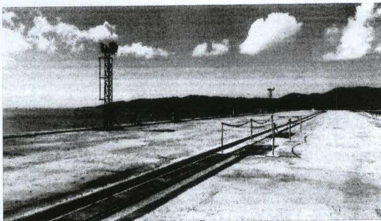
Ilustração 9: Pier de Atracação 2 do Estaleiro Enseada Paraguaçu.
