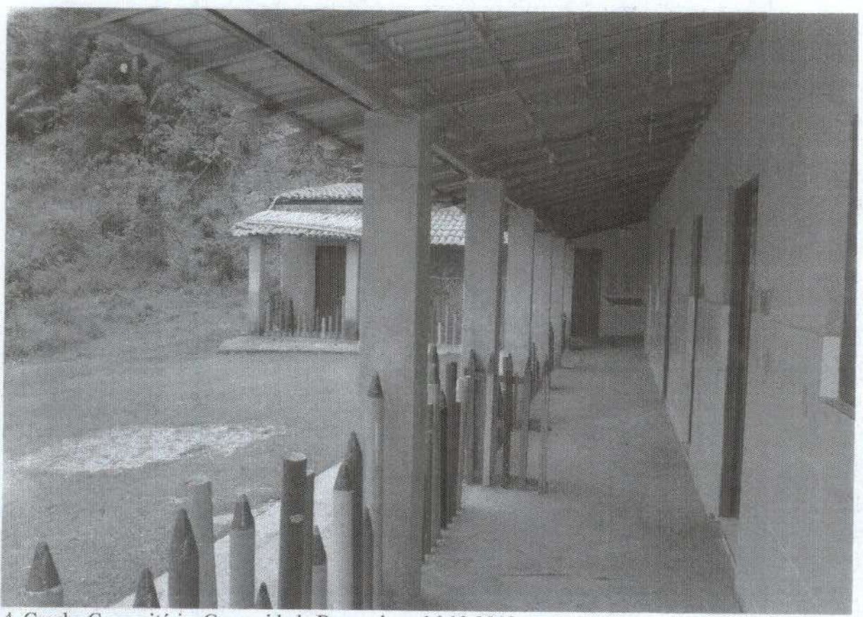
4. Creche Comunitária. Comunidade Bananeiras, 16.12.2013.
