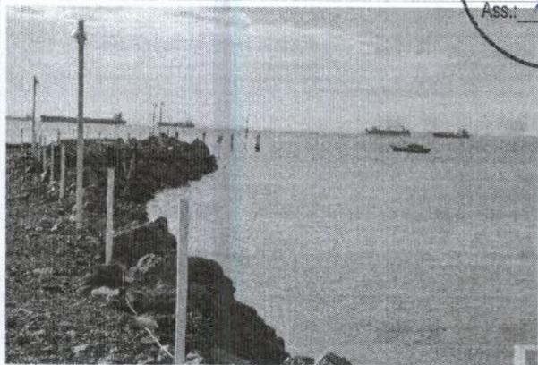
Foto 02. Segmento de quebramar perpendicular à linha costa em construção localizado em frente ao restaurante Amado.
