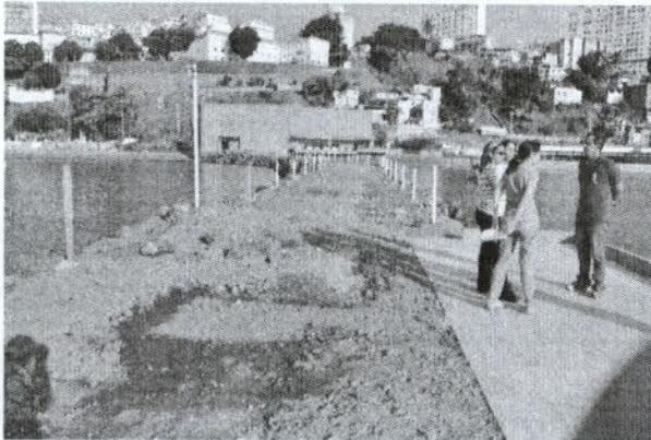
Foto 03. Segmento de quebramar perpendicular à linha costa em construção localizado em frente ao restaurante Amado (ao fundo).
