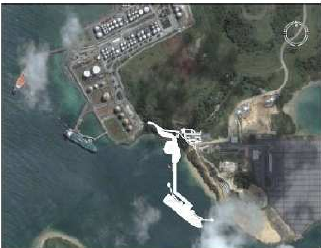
Figura 2.1 – Local a ser Instalado o Novo Píer
