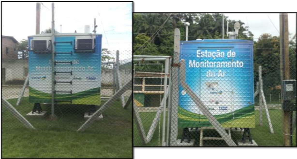
Figura 01: Estação de monitoramento localizada em Caboto (Candeias)
