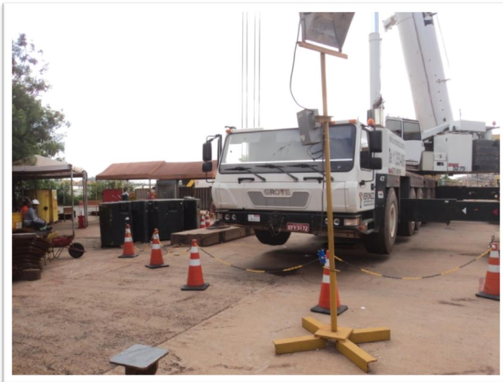
Figura 3: Exemplo de pátio de fabricação de tubulação / camisa metálica
