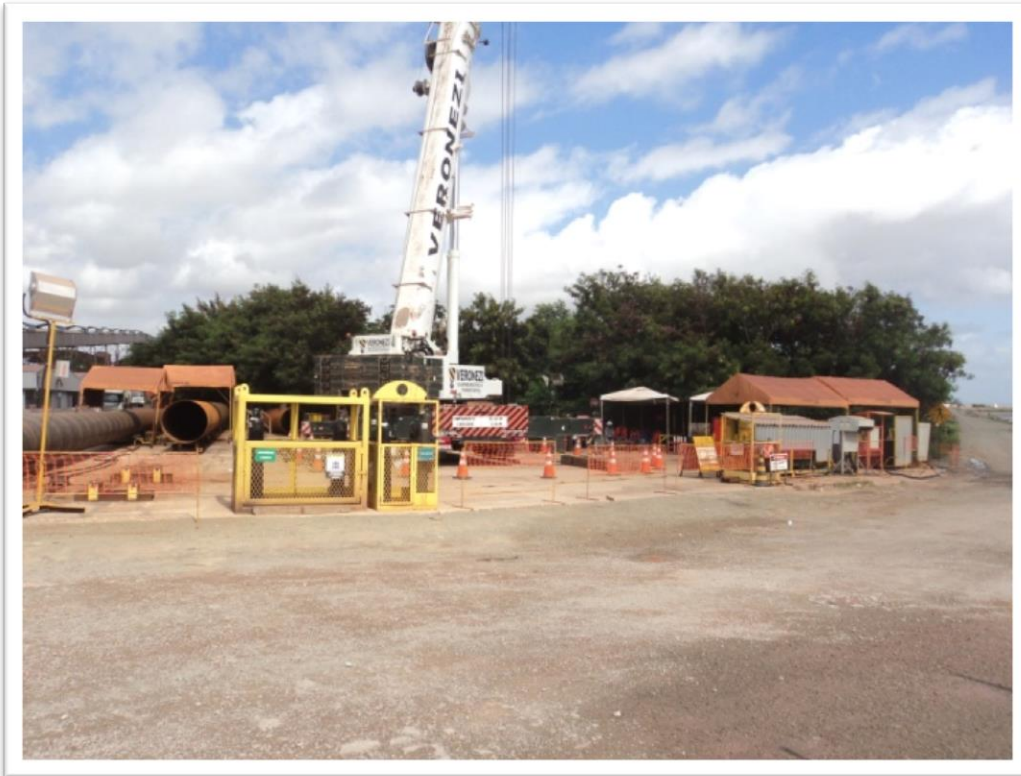
Figura 4: Exemplo de Pátio de fabricação de tubulação / camisa metálica
