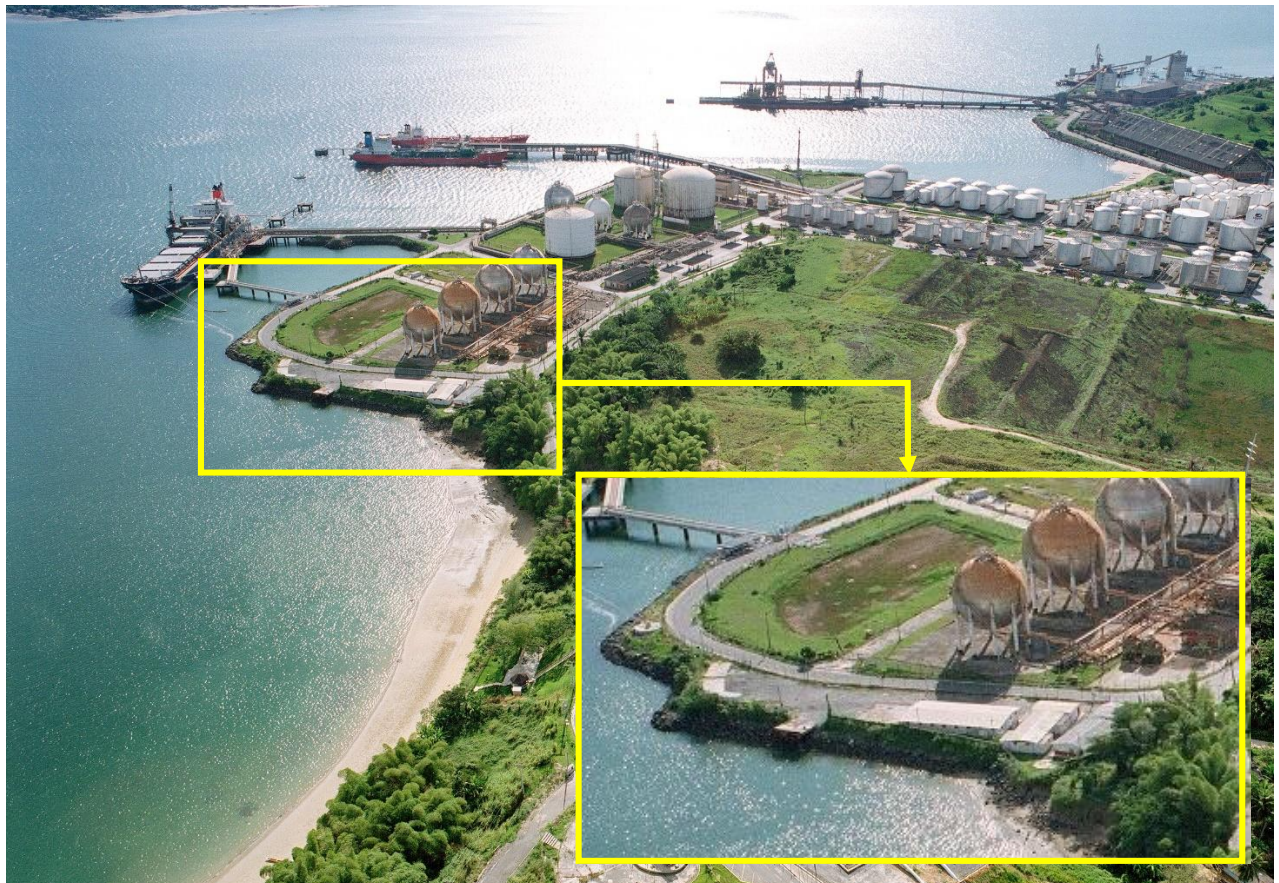
Foto Aérea do Porto de Aratu – Local do Canteiro de Terra
