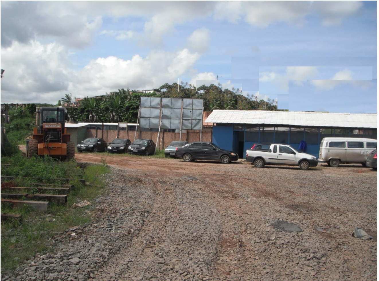
Exemplo de Canteiro de Obras Provisório
