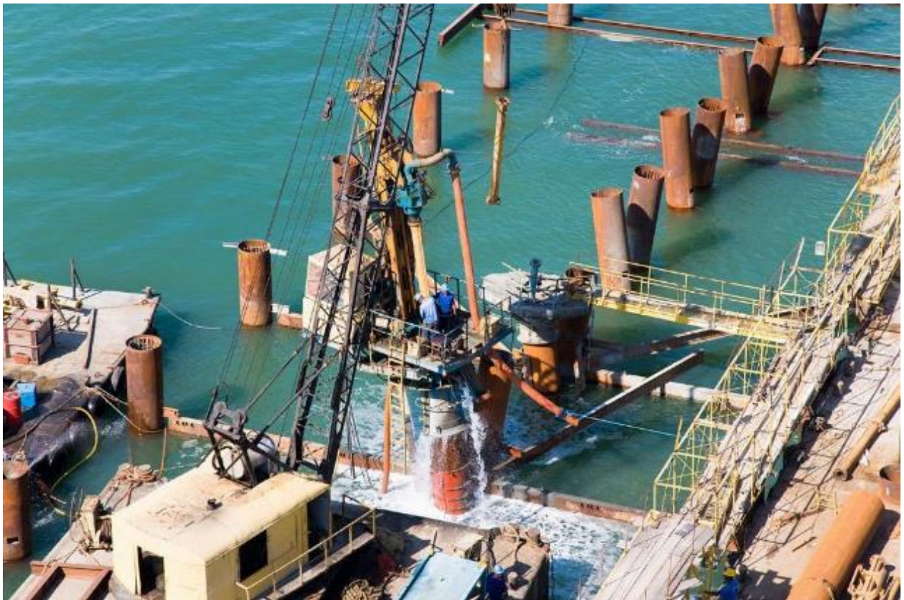
Perfuratriz Rotativa (Wirth) Executando Tubulão Inclinado
