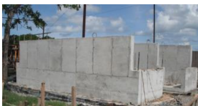
Montagem dos Pré-Moldados de Concreto
