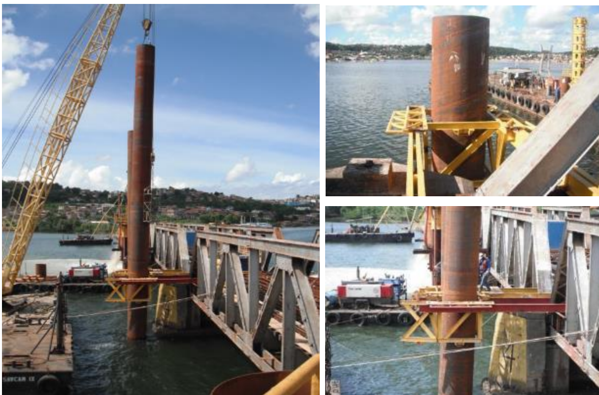
Montagem dos Gabaritos e Verticalização das Camisas Metálicas
