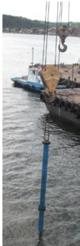
Concretagem Submersa com Tremonha dos Tubulões
