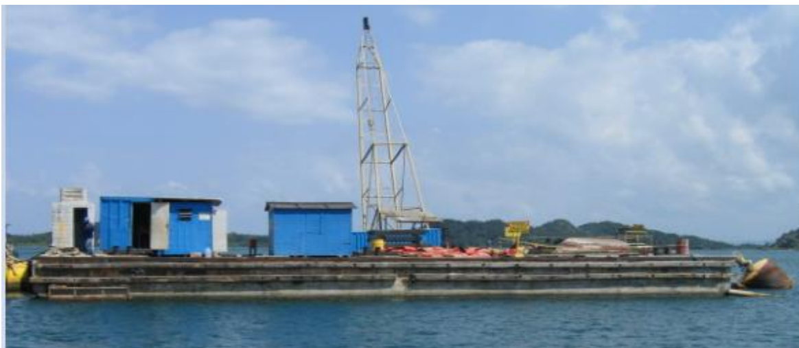
Exemplo de Balsa Canteiro
