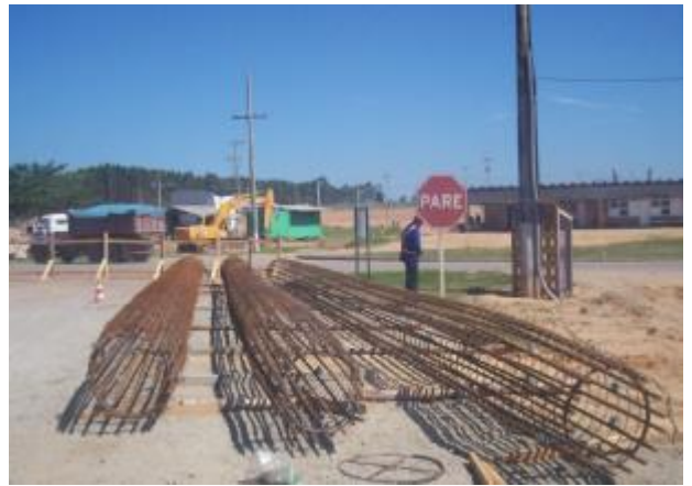
Montagem e Emenda das Armaduras do Tubulões
