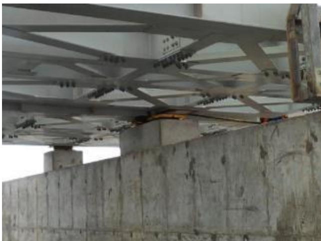
Fixação dos Aparelhos de Apoio
