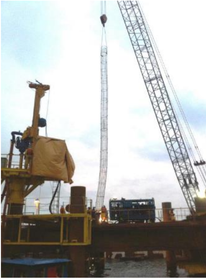
Montagem e Emenda das Armaduras do Tubulões
