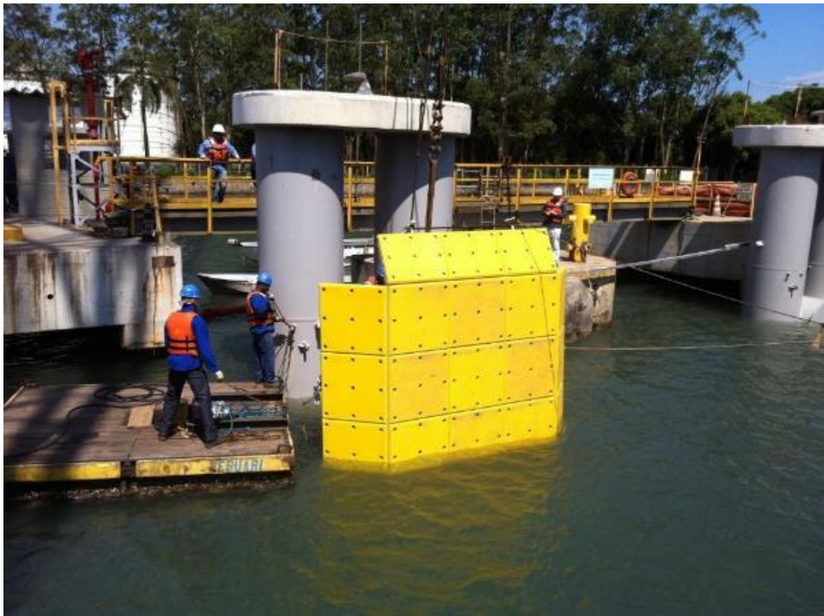
Montagem de Defensas Marítima de Atracação
