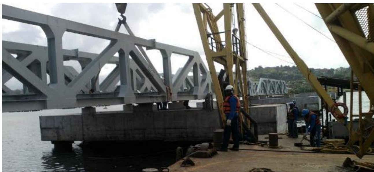
Içamento e Montagem dos Vão Trelaçados
