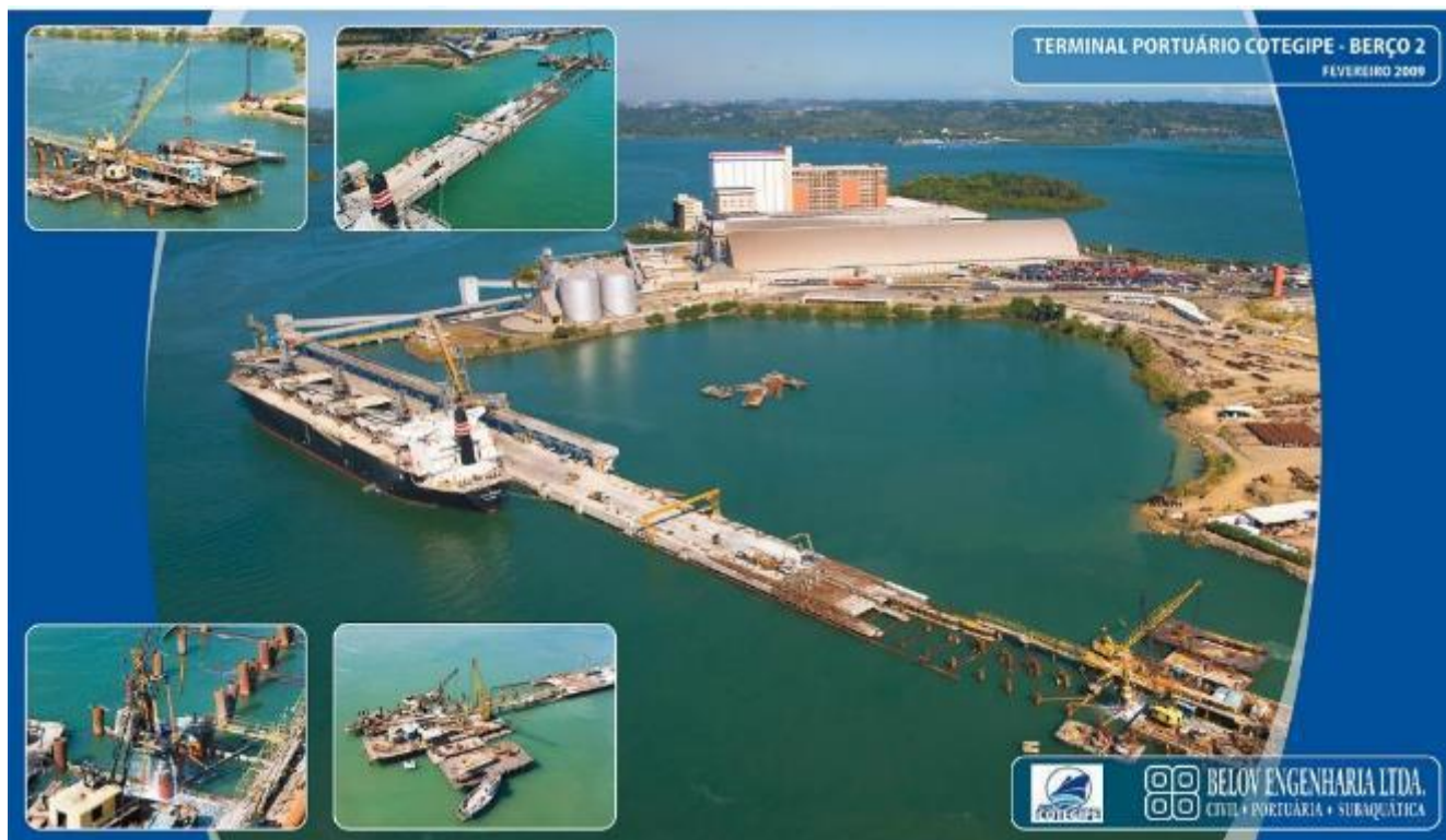
Pôster Obra Terminal Portuário de Cotegipe 2009
