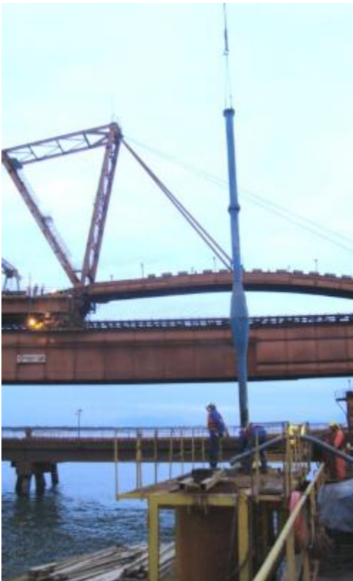
Concretagem Submersa com Tremonha dos Tubulões
