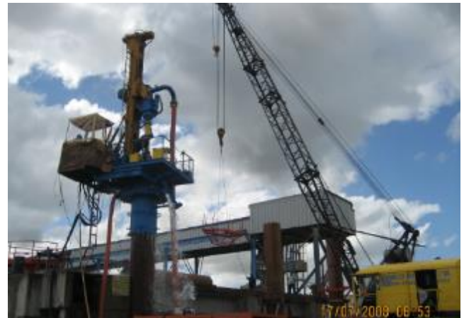
Perfuratrizes Rotativas (Wirth) para Tubulões Profundos
