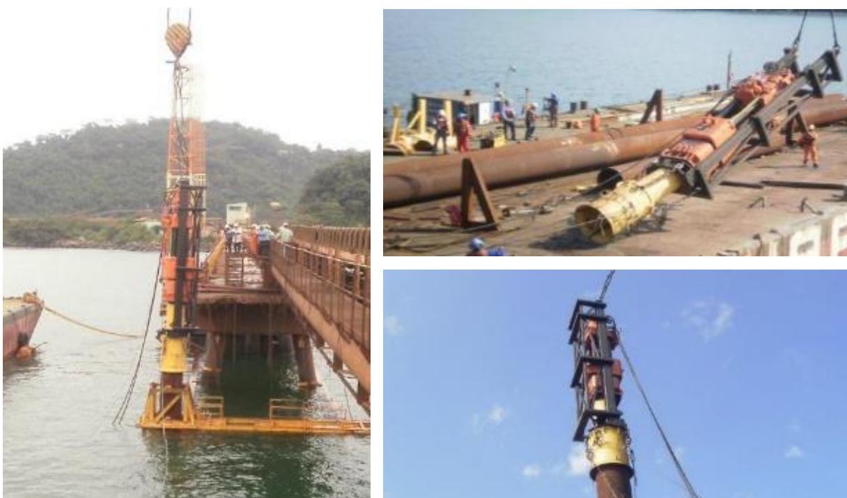
Cravação com Martelo de Impacto (Guia Suspensa)
