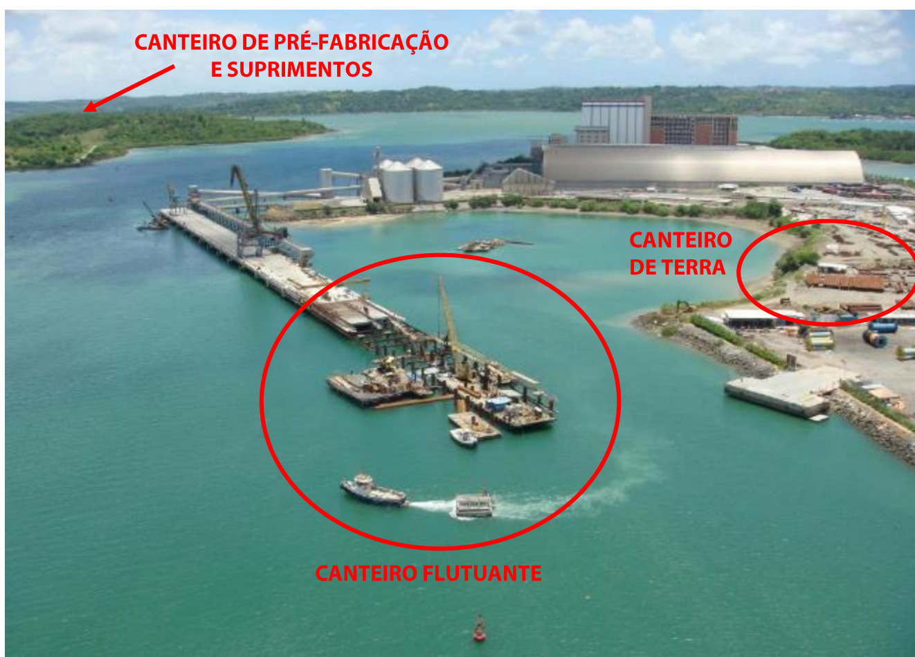
Exemplo de Arranjo de Obra – Obra Terminal Portuário de Cotegipe 2009
