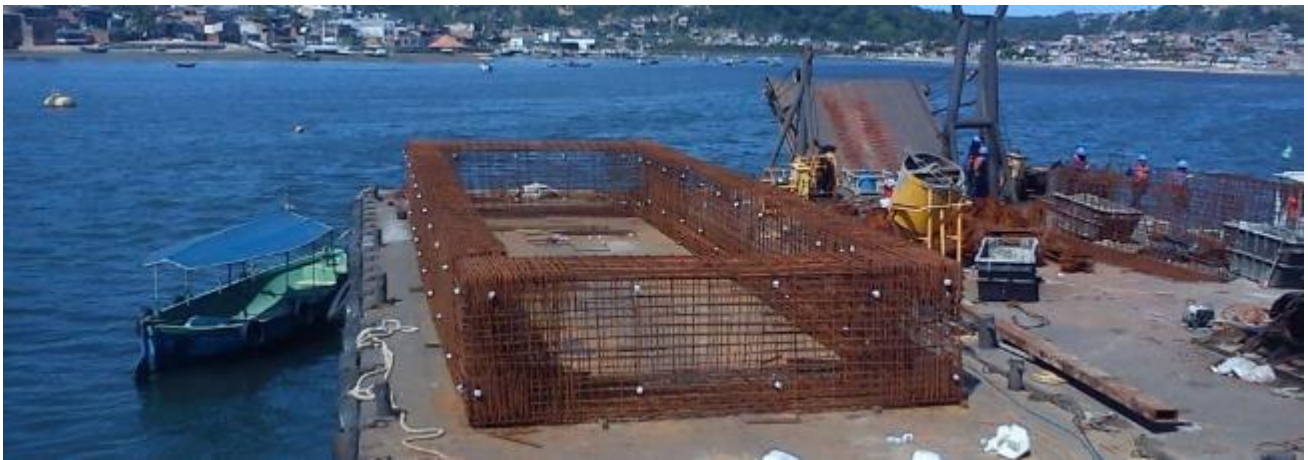
Montagem Armaduras e Concretagem "in loco"
