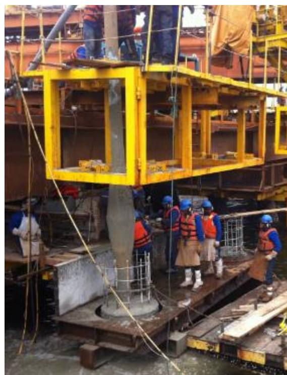
Expurgo do Concreto Contaminado e Cura
