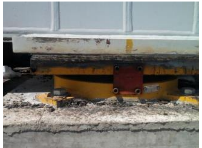
Fixação dos Aparelhos de Apoio
