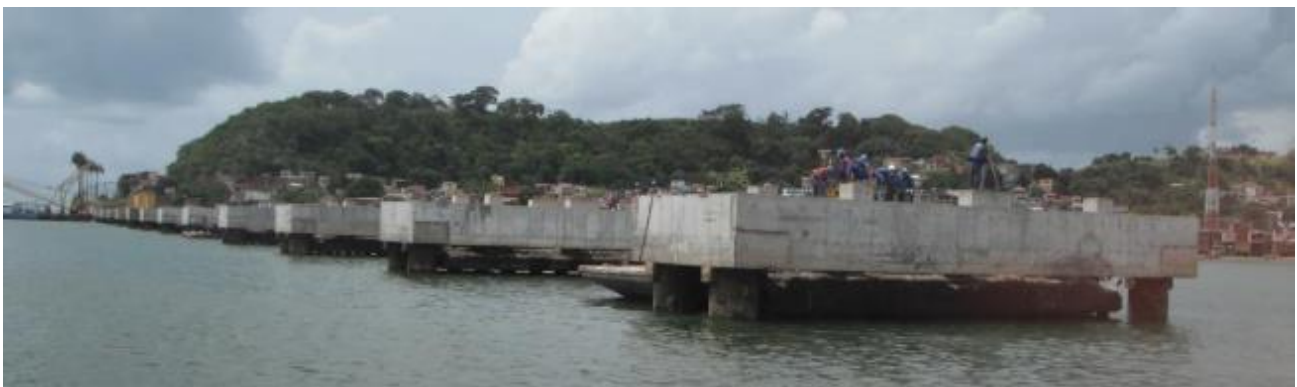
Exemplo de Blocos de Apoio e Plataformas Concretadas
