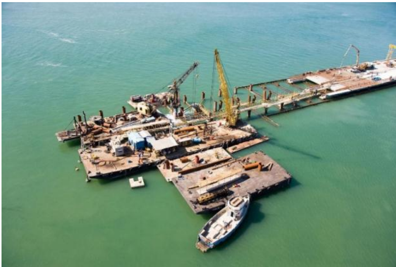
Exemplo de Arranjo de Balsas – Obra Terminal Portuário de Cotegipe 2009
