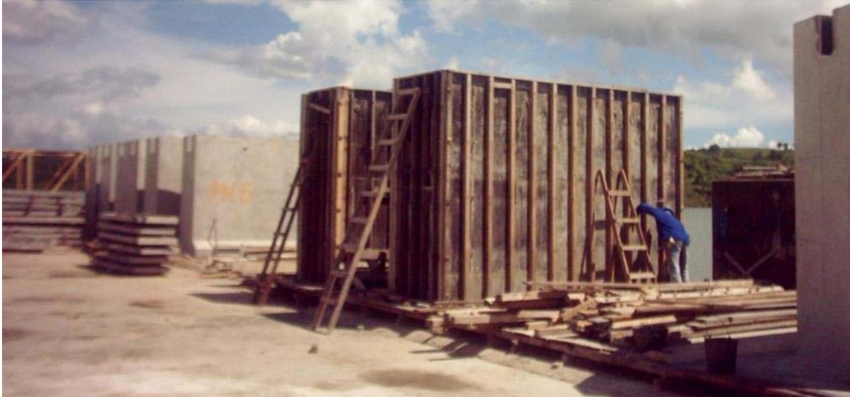
Central de Fabricação de Pré-moldados em Concreto
