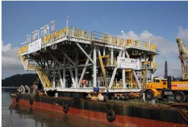
Modulo de Plataforma Offshore - Construído no CMM em 2013
