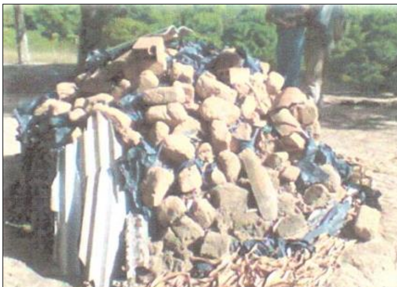
Figura 8.3-948. Adobe utilizado para construção de casas na comunidade de Rio dos Macacos (Fonte: Zagatto Consultoria, 2012).
