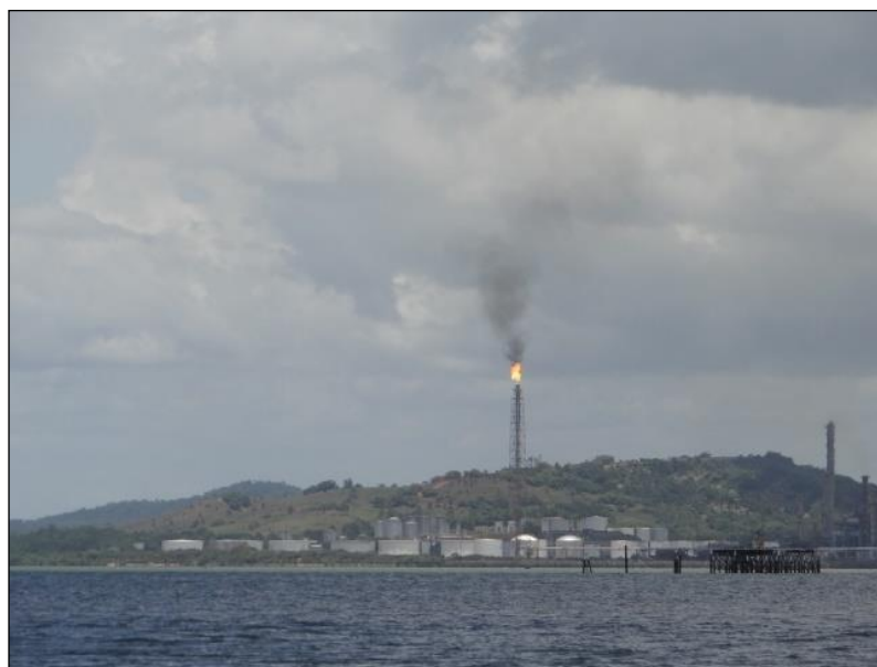
Figura 8.3-195. Refinaria Landulpho Alves Mataripe em São Francisco do Conde (UTM 546640 / 85955303) (Fonte: Bourscheid, 2014).
