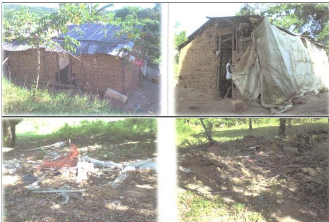
Figura 8.3-936. Acima, casas no Tombo da Barragem de Rio dos Macacos. Abaixo à esquerda, galinheiro, segundo os moradores, derrubado pela Marinha. Abaixo à direita, casa que ruiu pela não possibilidade de manutenção pela proibição da Marinha. (Fonte: Zagatto Consultoria, 2012).
