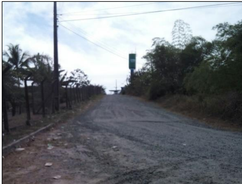
Figura 8.3-188. Vista para o único acesso a ADA para veículos através de estrada irregular ao lado do Porto da Ford – UTM 555217/8586577 (Fonte: Bourscheid, 2015).
