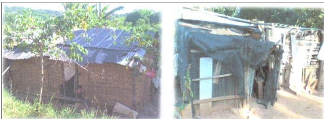
Figura 8.3-928. Moradias localizadas no interior da área da Marinha. Na foto à direita banheiro improvisado (Fonte: Zagatto Consultoria, 2011).
