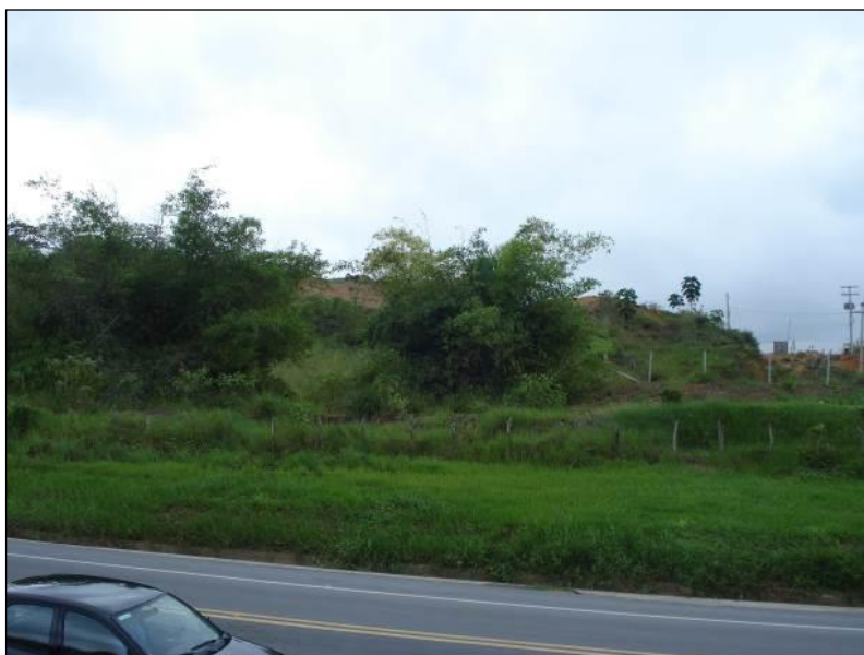
Figura 8.1-47. Atividade de instalação de indústria com cortes e aterro. Presença de processos erosivos (Fonte: Bourscheid, 2014).
