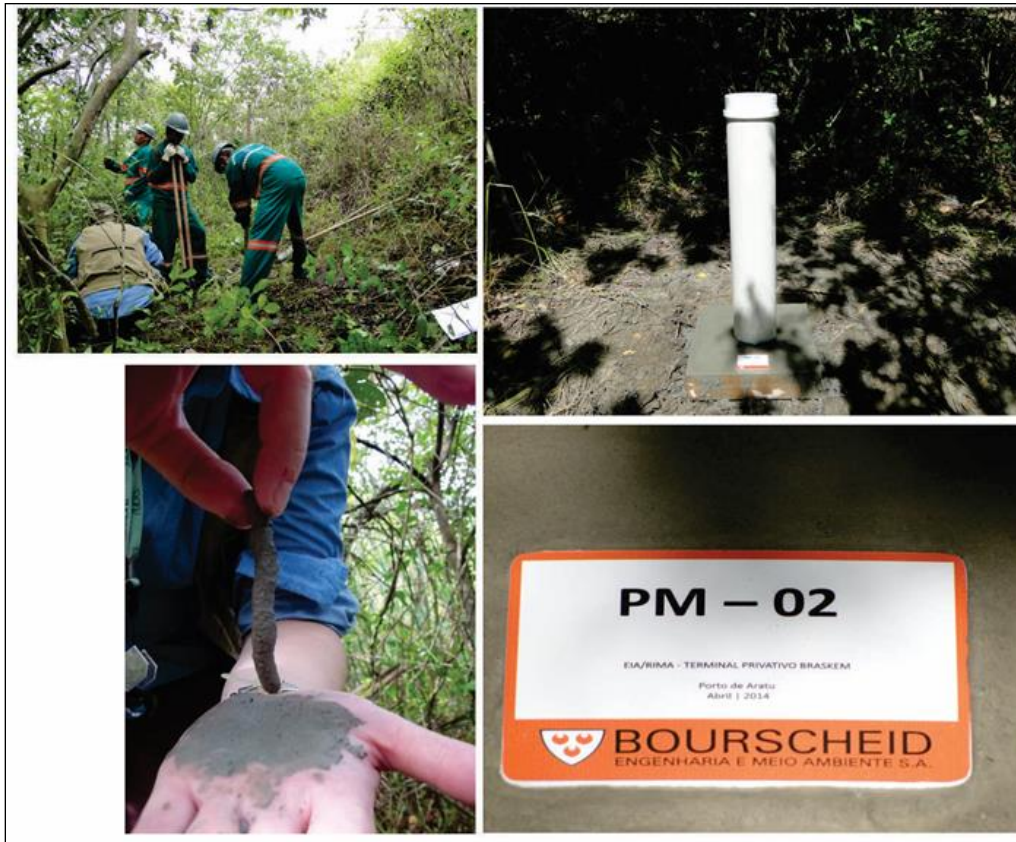
Figura 8.1-54. Vista do entorno do poço PM-02 instalado, ensaio tátil-visual apontando para substrato argiloso plástico e consistente e selo sanitário devidamente instalado.
