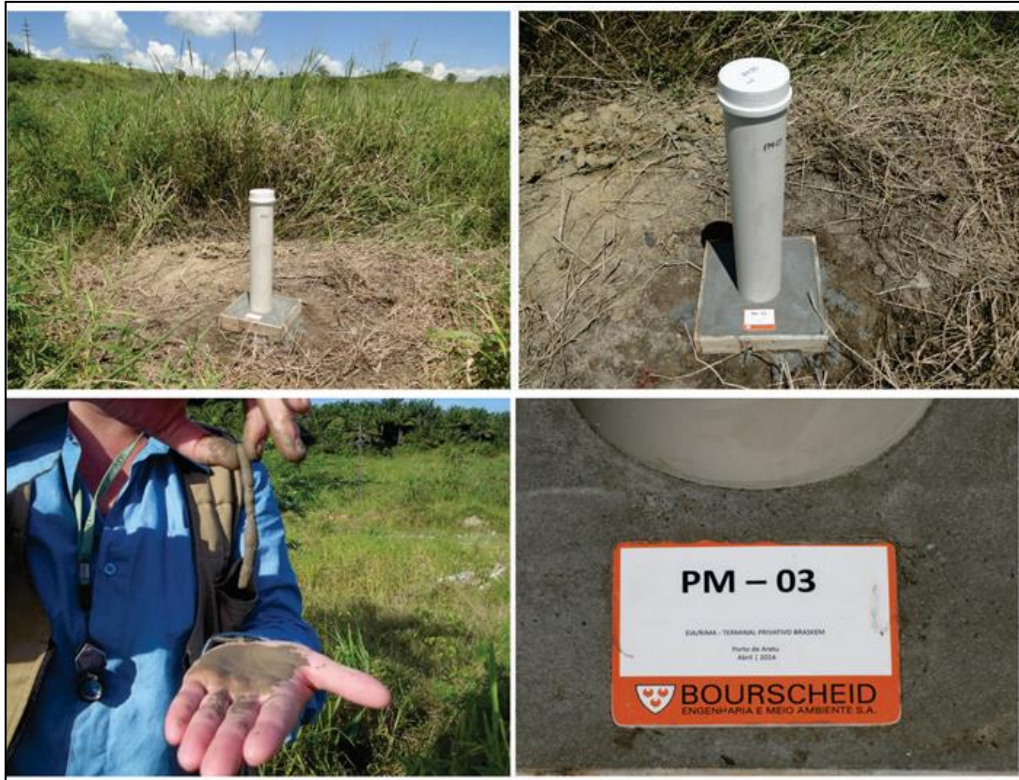
Figura 8.1-55. Vista do entorno do poço PM-03 instalado, ensaio tátil-visual apontando para substrato argiloso plástico e consistente e selo sanitário devidamente instalado (Fonte: Bourscheid, 2014).
