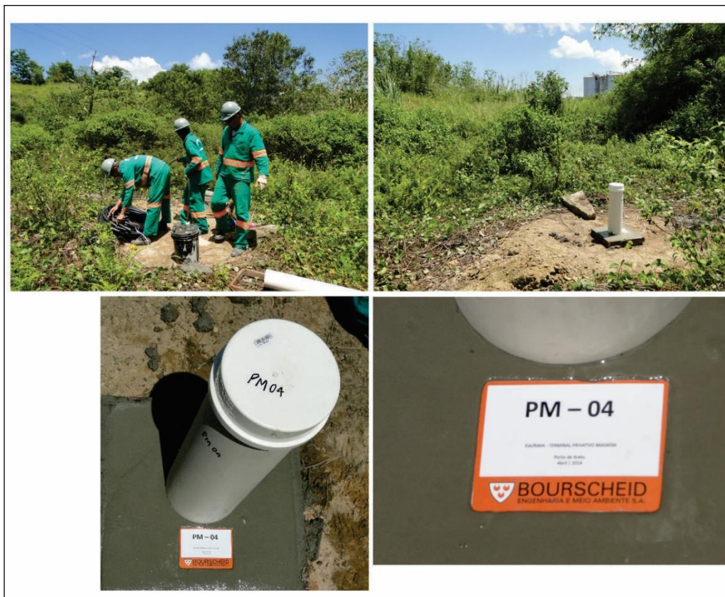
Figura 8.1-56. Vista para o entorno do poço PM-04 instalado, ensaio tátil-visual apontando para substrato argiloso plástico e consistente e selo sanitário devidamente instalado (Fonte: Bourscheid, 2014).
