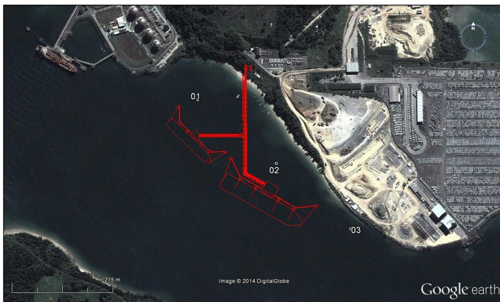
Figura 8.1-176. Localização do Píer da Braskem e dos pontos utilizados para a avaliação do clima de onda (Fonte: Imagem Google Earth, 2011).
