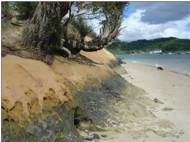
Figura 8.1-29. Aspecto de afloramento de arenito com coloração amarelada na ADA (Fonte: Bourscheid, 2013).
