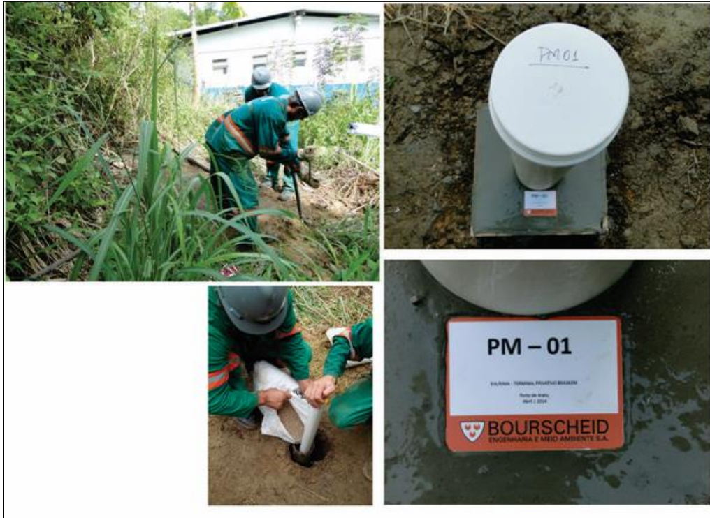
Figura 8.1-53. Vista do entorno do poço PM-01 (empreendimento), da instalação e do selo sanitário devidamente instalado (Fonte: Bourscheid, 2014).
