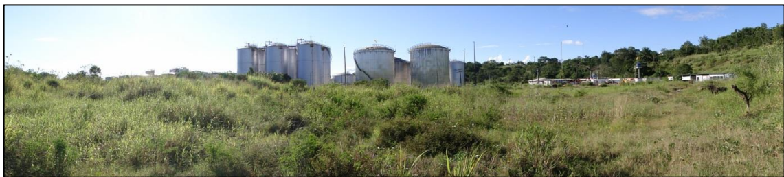
Figura 5.4-3. Vista panorâmica do local onde será instalado o canteiro 4 (Fonte: Bourscheid, 2014).
