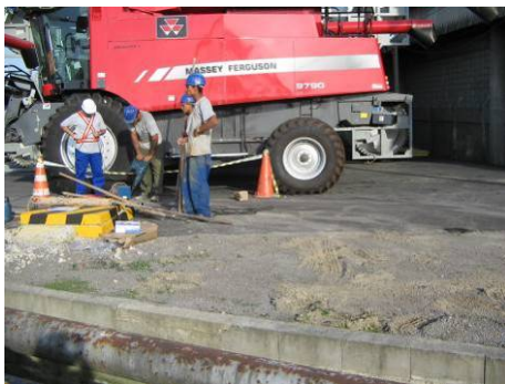
Foto 03 - Instalação do PM-03
