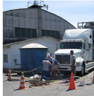
Foto 02 - Instalação do PM-02
