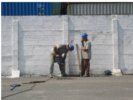
Foto 05 - Sondagem de solo superficial
