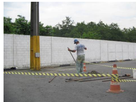
Foto 04 - Instalação do PM-04
