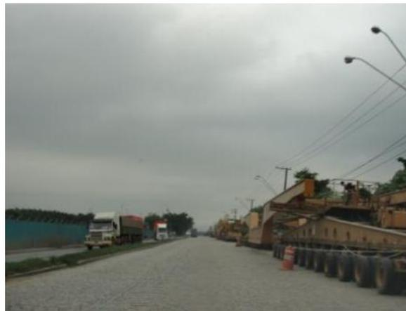
**Foto 5.3.5.3-1 Av. Eng. Augusto Barata. Pista sentido Santos, trecho anterior ao atual TPD. Via com pista dupla e duas faixas de rolamento por sentido. O pavimento existente é em paralelepípedos. Há um pequeno canteiro central dividindo as pistas.**
