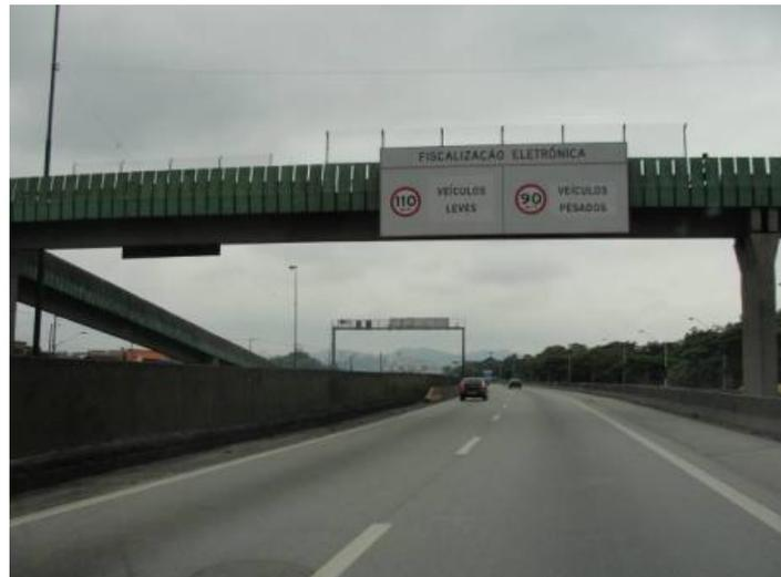
**Foto 5.3.5.1-7 SP150 Rodovia Anchieta, pista sul, trecho de baixada. Melhoria significativa das condições geométricas da pista. Presença de acostamento. Velocidade regulamentada em 110km/h para automóveis e em 90km/h para ônibus e caminhões.**
