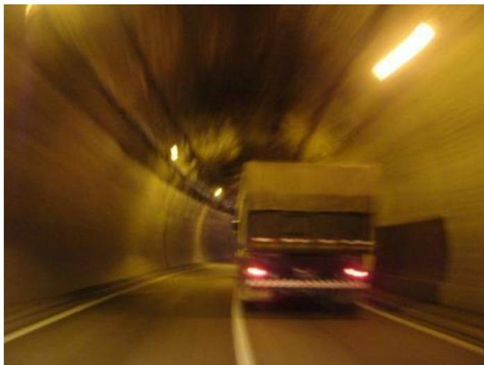
**Foto 5.3.5.1-4 SP150 Rodovia Anchieta, pista sul. Presença de vários túneis, onde as restrições geométricas da pista tornam-se mais evidentes: rampa acentuada, inexistência de acostamento, curvas acentuadas.**
