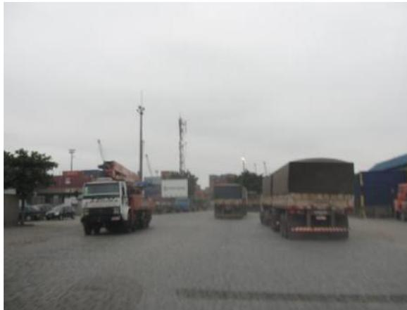
**Foto 5.3.5.3-7 Av. Eng. Augusto Barata. Pista sentido Santos, trecho posterior ao atual TPD. A via não mais é dividida por canteiro central. Conforma-se então em pista simples com uma faixa de rolamento por sentido e estacionamento praticado junto ao meio-fio em ambos os lados da via.**
