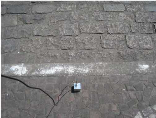
Foto 5.1.4.2-1 Acelerômetro fixado no pod metálico no eixo z.
