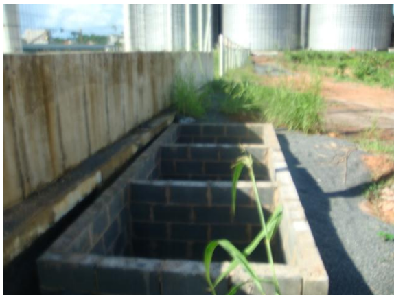
Fig.4-caixa do lançamento 6 (inativa)
