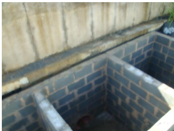
Fig.5-det da caixa do lançamento 6
