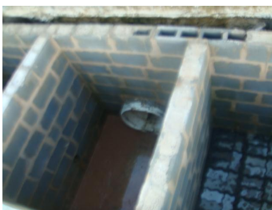
Fig.9-det da caixa do lançamento 7
