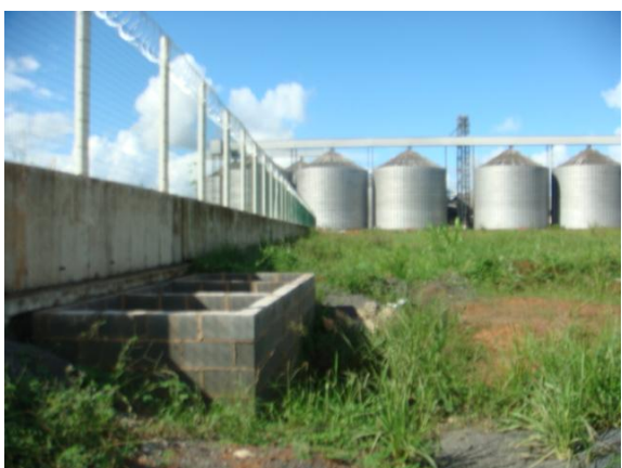
Fig.8-caixa do lançamento 7 (inativa)
