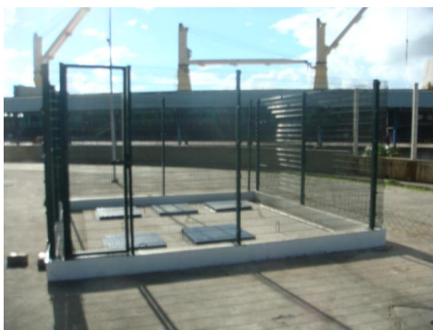
Fig.10-caixa de ret. lançamento 2
