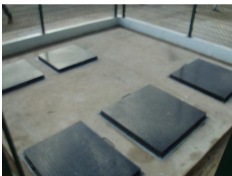
Fig.12-caixa de ret. lançamento 2
