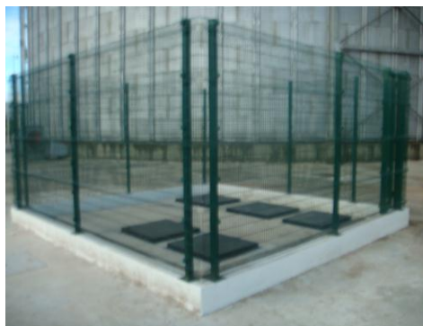
Fig.11-caixa de ret. Lançamento 3
