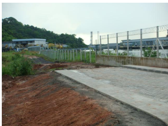
Fig.1-trecho executado da rua periférica
