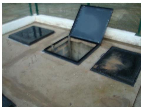
Fig.13-caixa de ret. Lançamento 3
