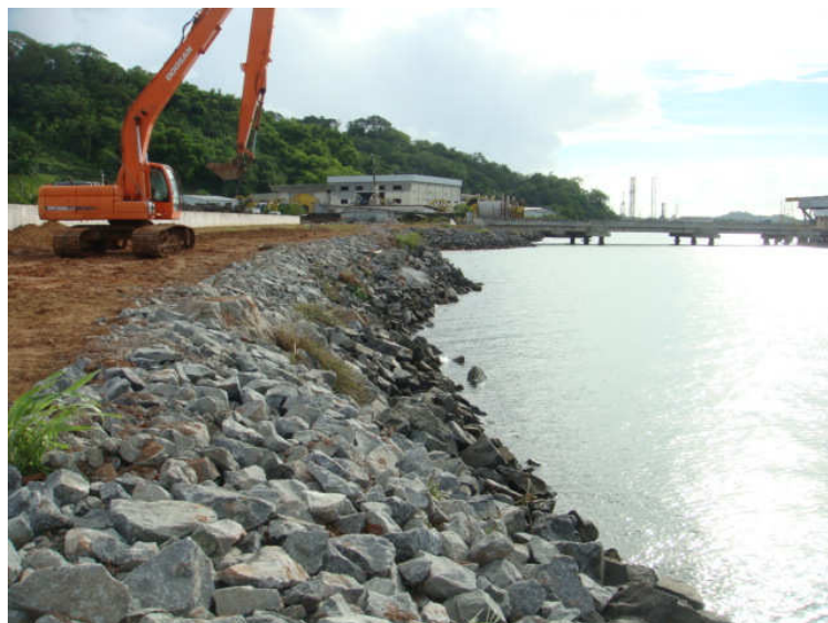
Fig.7 (faixa de enrocamento do tpc)
