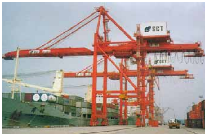
Foto 3 - Porto de Santos - Guindaste-Pórtico para Transferência de Contêineres entre Embarcação/Cais
