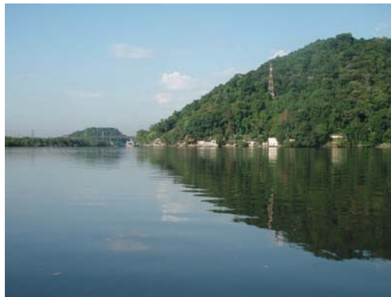
Figura 6.15 Vista parcial de Monte Cabrão.
