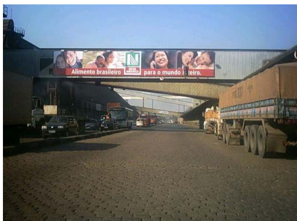
Foto 9.5-29 Avenida Eduardo Guinle, entre os terminais na regiões de Outeirinhos
