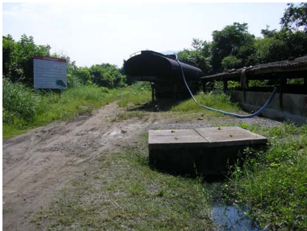
Foto 9.5-44 Recolhimento de chorume e vista para a área lateral do terreno lindeira ao estuário
