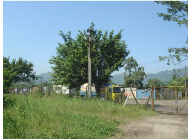
Foto 9.5-52 Idem. Ao fundo a Avenida Engenheiro Augusto Barata
