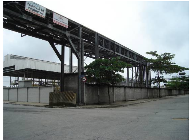
Foto 9.5-39 Bairro da Alemoa: cruzamentos de dutos com o sistema viário
