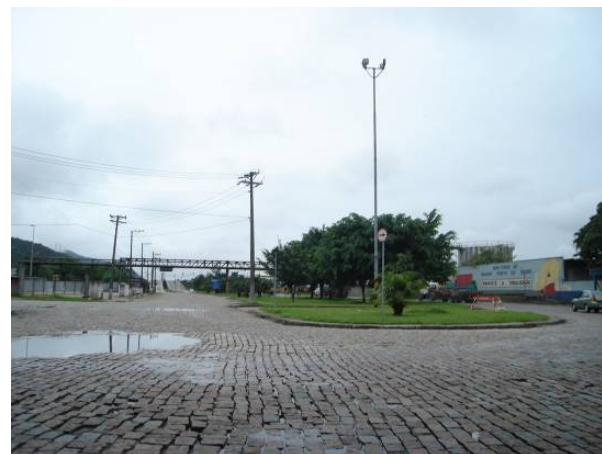
Foto 9.5-21 Rotatória da Alemoa. Pavimento em paralelepípedo
