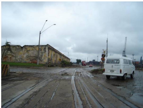
Foto 9.5-18 Cruzamento em níveis com ramais ferroviários
