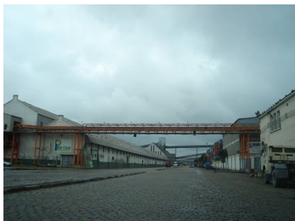
Foto 9.5-30 Avenida Eduardo Guinle, entre os terminais na regiões de Outeirinhos
