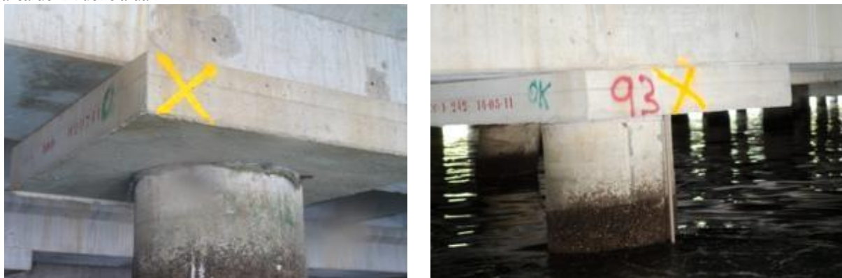
Figura 2.8.2.3.5-2 – Esquema de marcação com tinta spray na cor laranja, para melhor visualização das estacas, nas área de influência da BTP.
