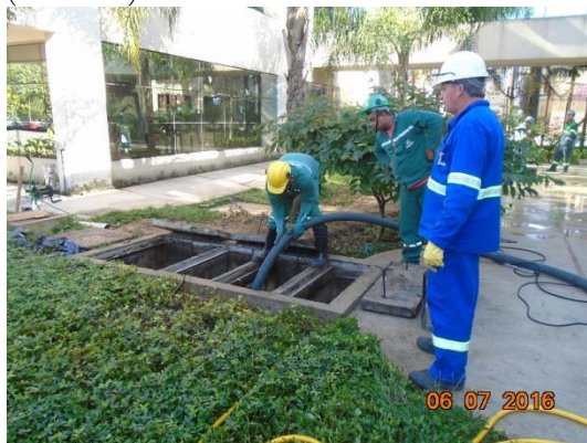
Figura 2.6.5.2.2-1 – Limpeza de caixa de gordura (Refeitório)
