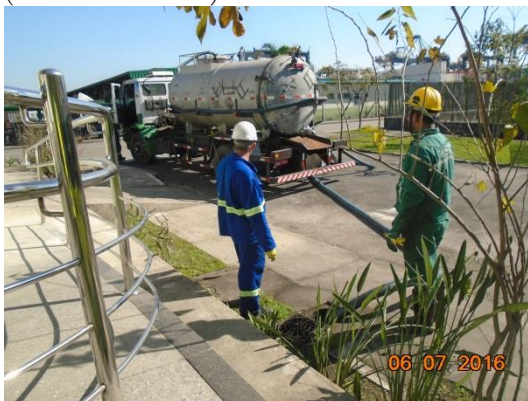
Figura 2.6.5.2.2-2 – Limpeza de caixa de gordura (Casa dos Visitantes)
